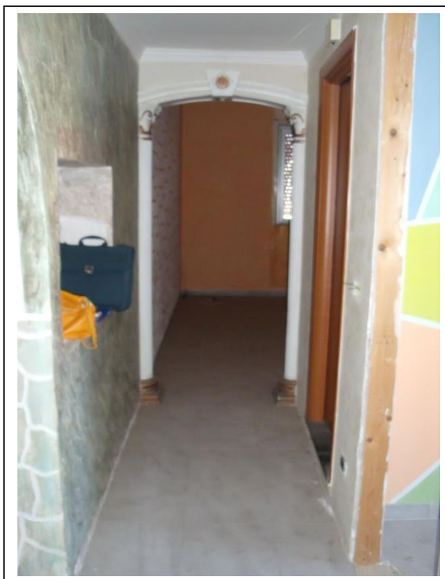
12. Interno unità immobiliare, vista verso lato sud, presenza di controsoffitto.
