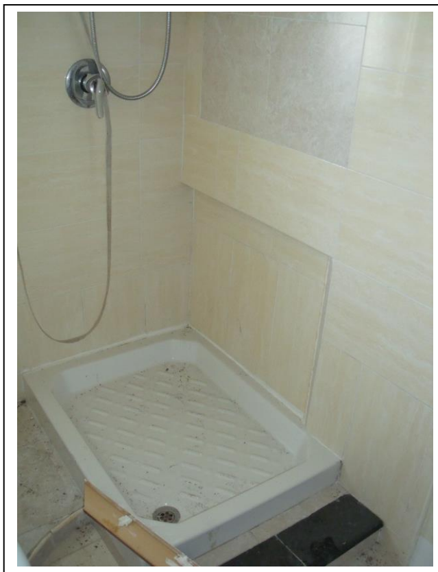
22. Interno servizio igienico con vista verso lato nord-ovest.
