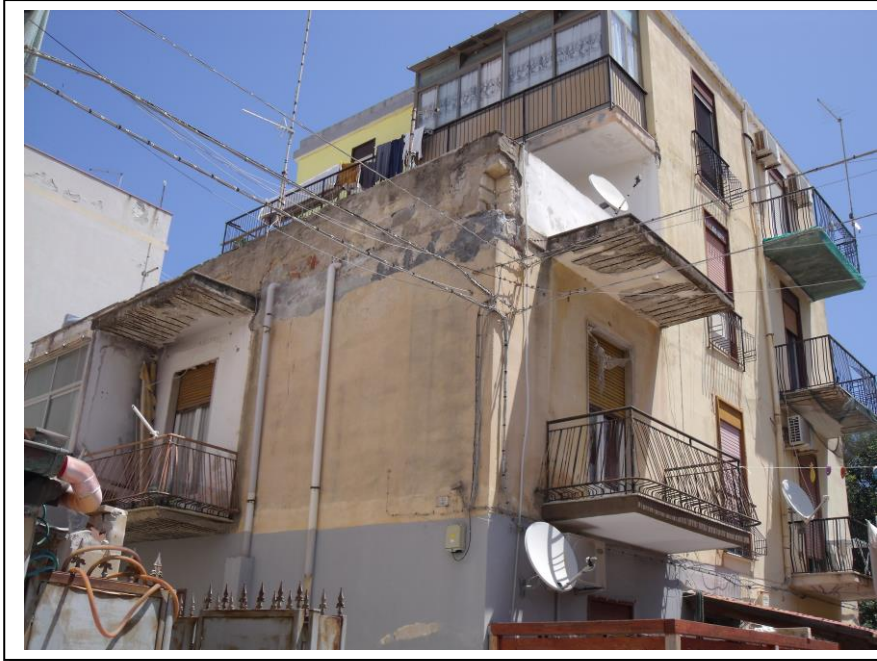
02. Vista prospettica dell'unità immobiliare su Ronco IV di via Filisto e su stradella interna di accesso laterale, l'intera costruzione consiste in piano terra, primo, secondo e terzo, l'u.i. in questione è al piano secondo.
