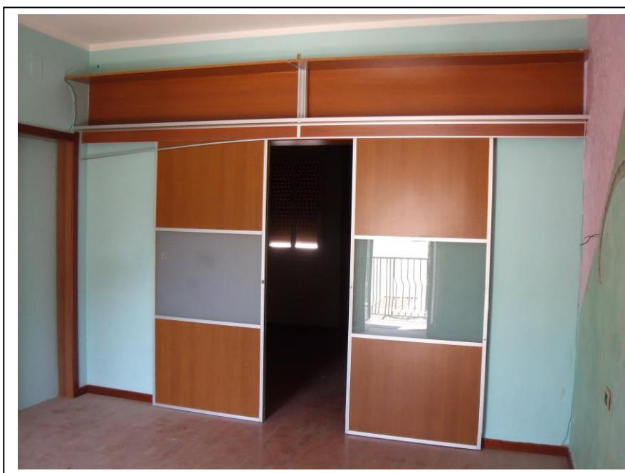
27. Interno u. i. con vista verso lato nord, in foto porta scorrevole a due ante di separazione con vano adiacente. Sulla sinistra presenza di vano porta preesistente chiuso successivamente.
