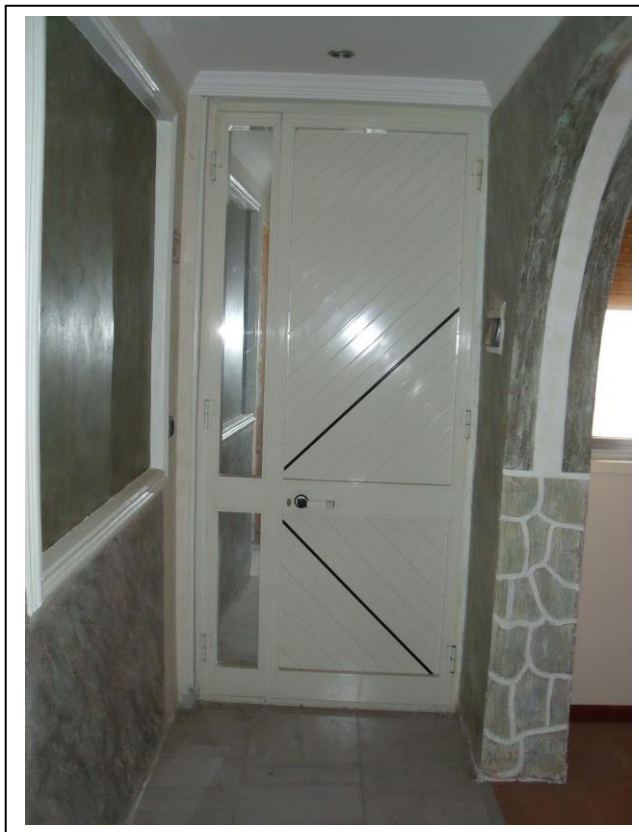
11. Portoncino d'ingresso all'unità immobiliare con vista verso lato nord.
