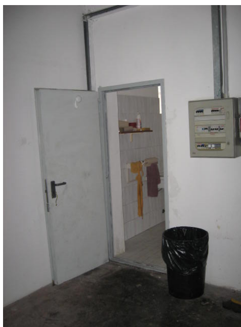
porzione fronte nord ed
