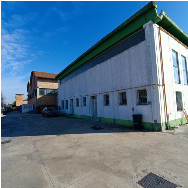
Scorcio fianco nord ovest e particolare sud est
