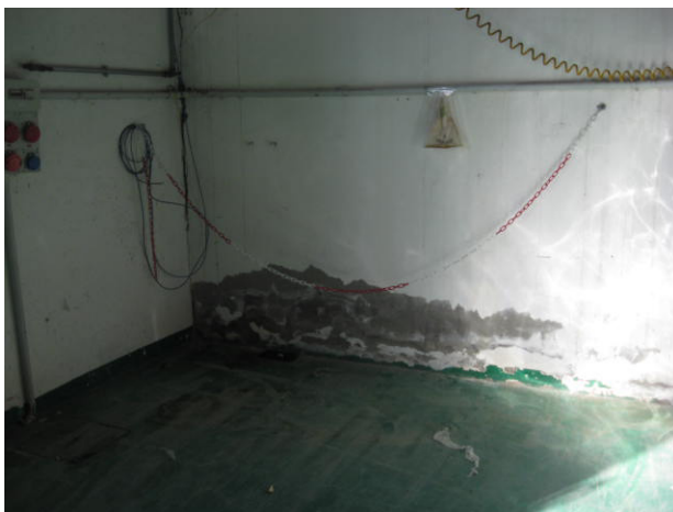
particolare ammaloramento da umidità e pavimento adiacente zona di uscita
