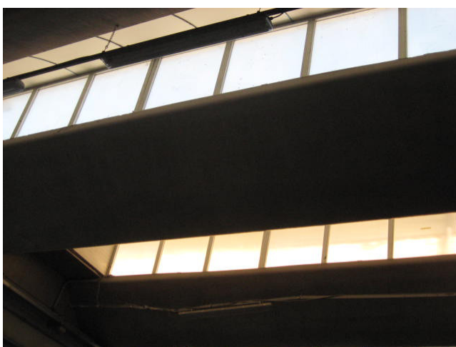
Shed/copertura corpo centrale
