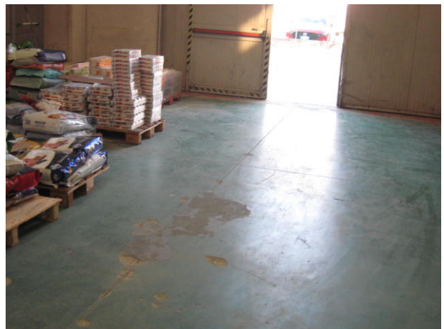
particolare ammaloramento da umidità e pavimento adiacente zona di uscita
