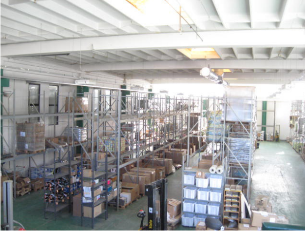
Panoramica e particolare elemento di riscaldamento
