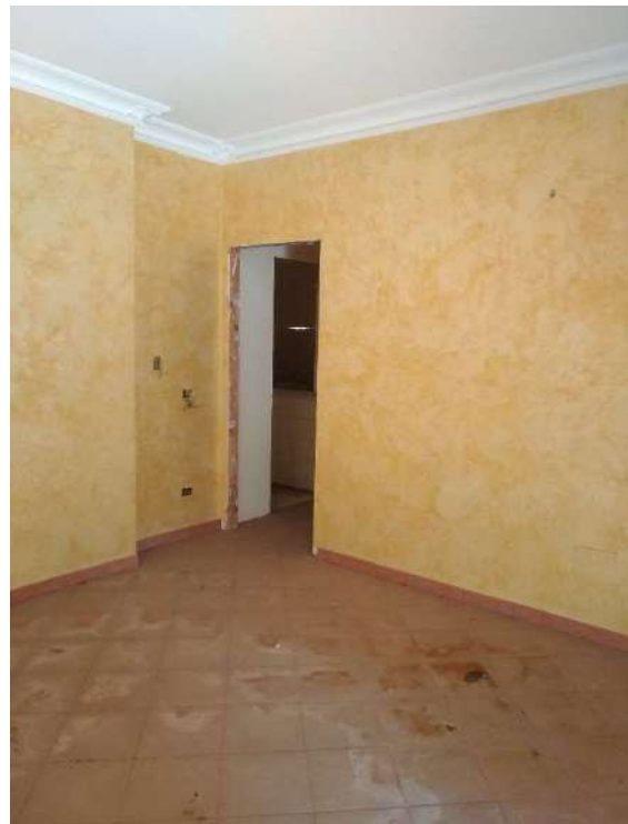
FOTO 23 VANO 10 PIANO SECONDO
