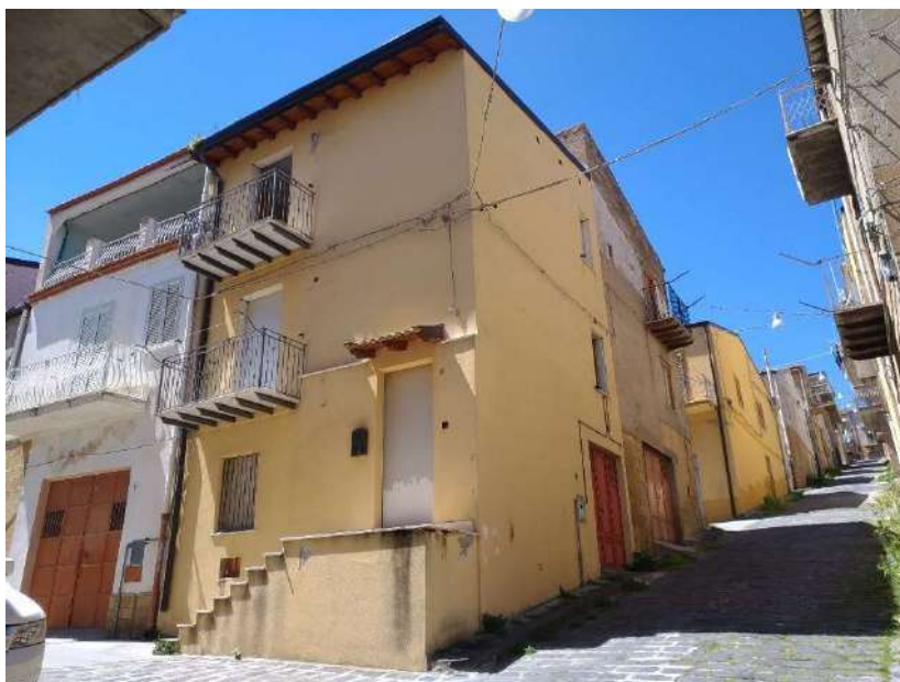
FOTO 1 – PROSPETTO via FARACI angolo via PALAZZO
