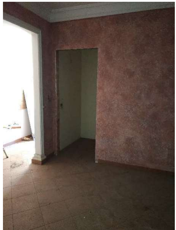
FOTO 14 VANO 6 PIANO PRIMO
