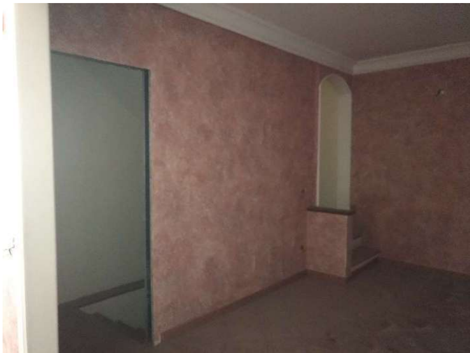
FOTO 15 – 16 – 17 VANO 6 PIANO PRIMO
