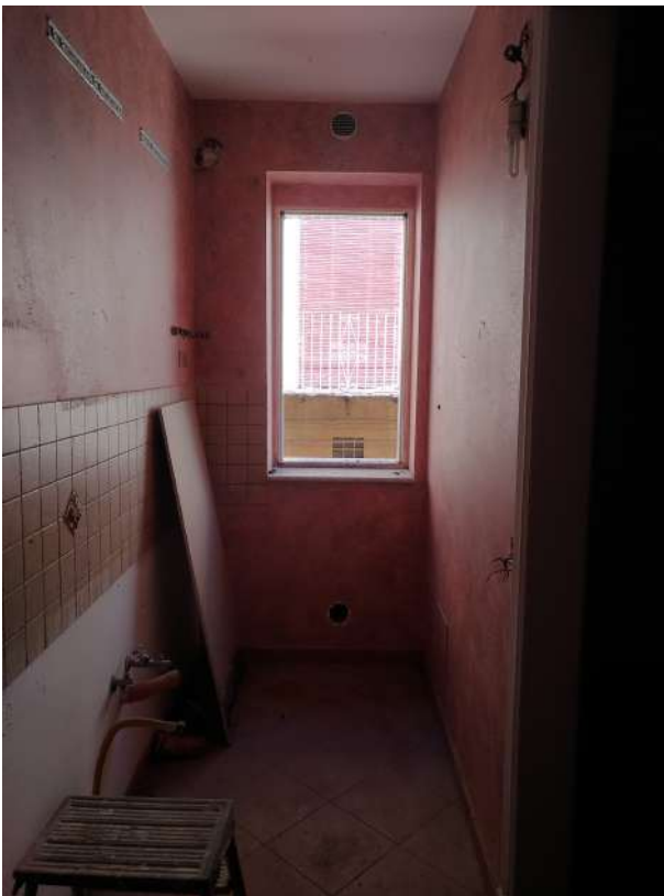
FOTO 20 VANO 7 PIANO PRIMO
