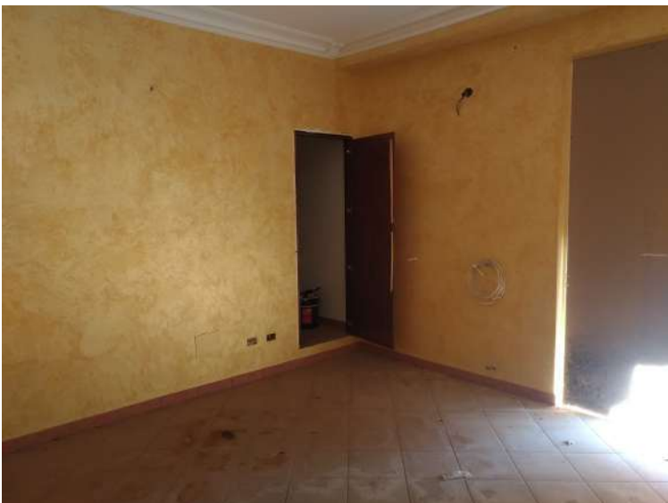
FOTO 25 VANO 10 PIANO SECONDO
