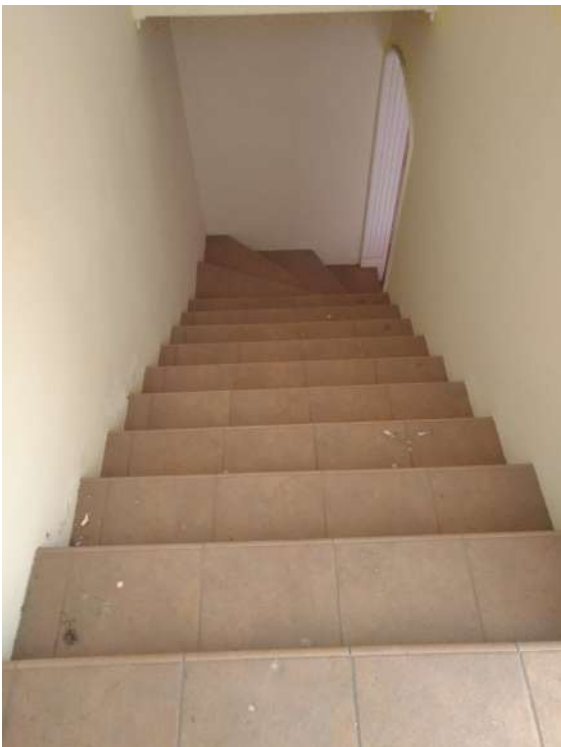
FOTO 22 VANO 9 ( VANO SCALA )
