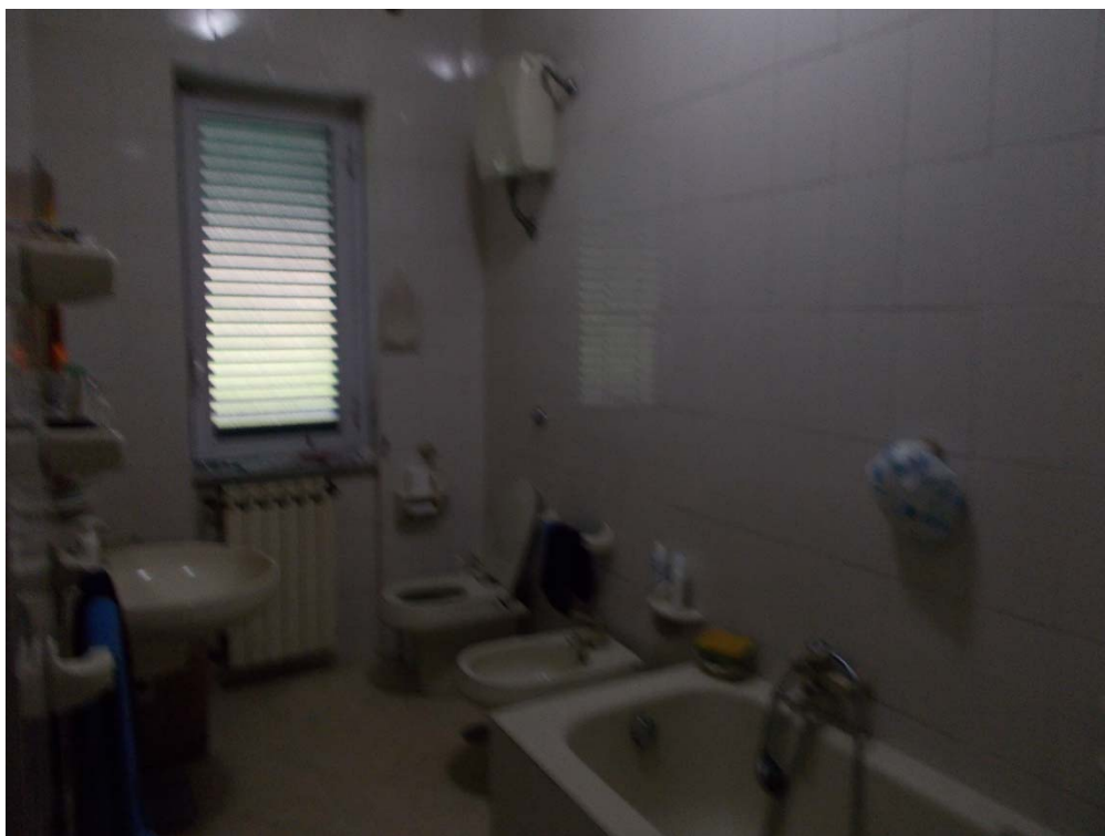
FOTO N°7: PIANO PRIMO BENE N°1
