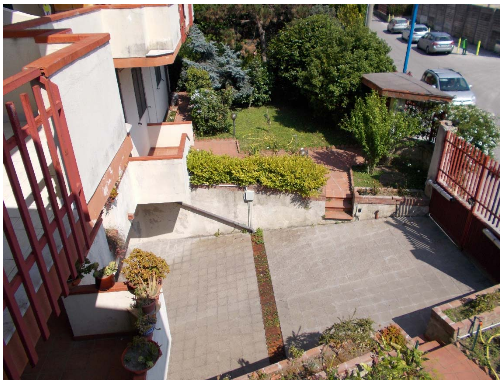
FOTO N°16: VISTA RAMPA E GIARDINO-BENI N°4 E N°5
