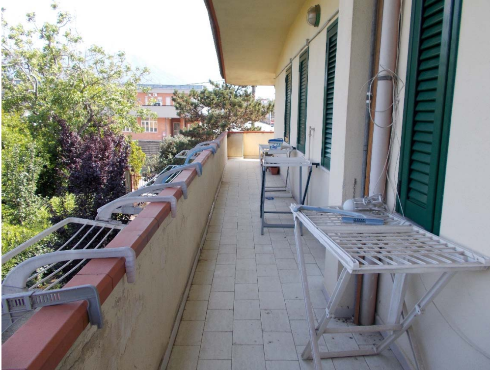
FOTO N°11: PIANO PRIMO BENE N°1
