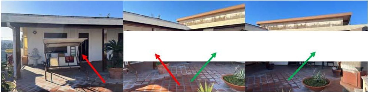
Viste delle due unità dal terrazzo a livello (in comune): con la freccia rossa, l'unità originaria e sanata con concessione rilasciata nel 2006 (legge 47/85); con la freccia verde, l'unità realizzata successivamente senza titolo e non sanabile
