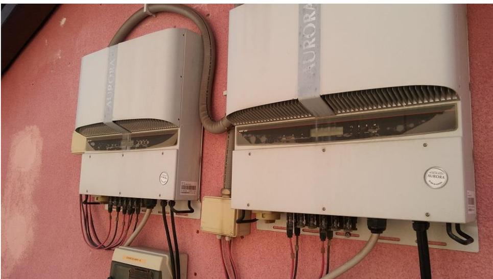
*Figura 5: particolare impianto: inverter*
