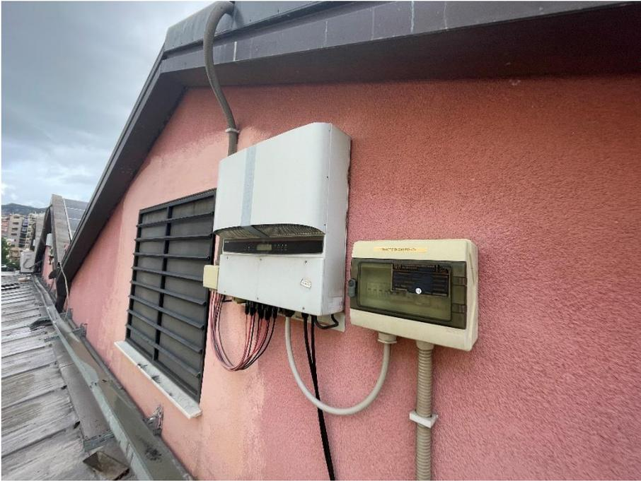
*Figura 6: particolare impianto: inverter*
