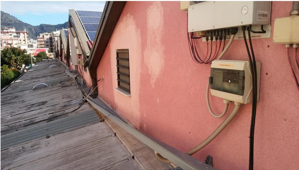
*Figura 7: accesso alle falde con canaline danneggiate*
