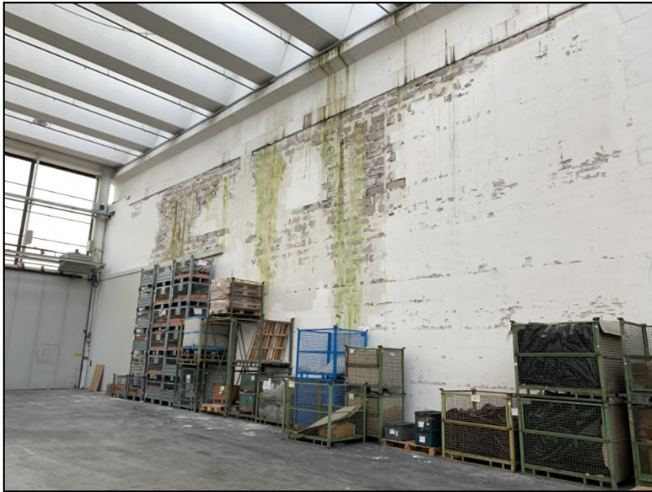
Particolare della copertura in cui verranno condotte analisi non invasive e volo con drone
