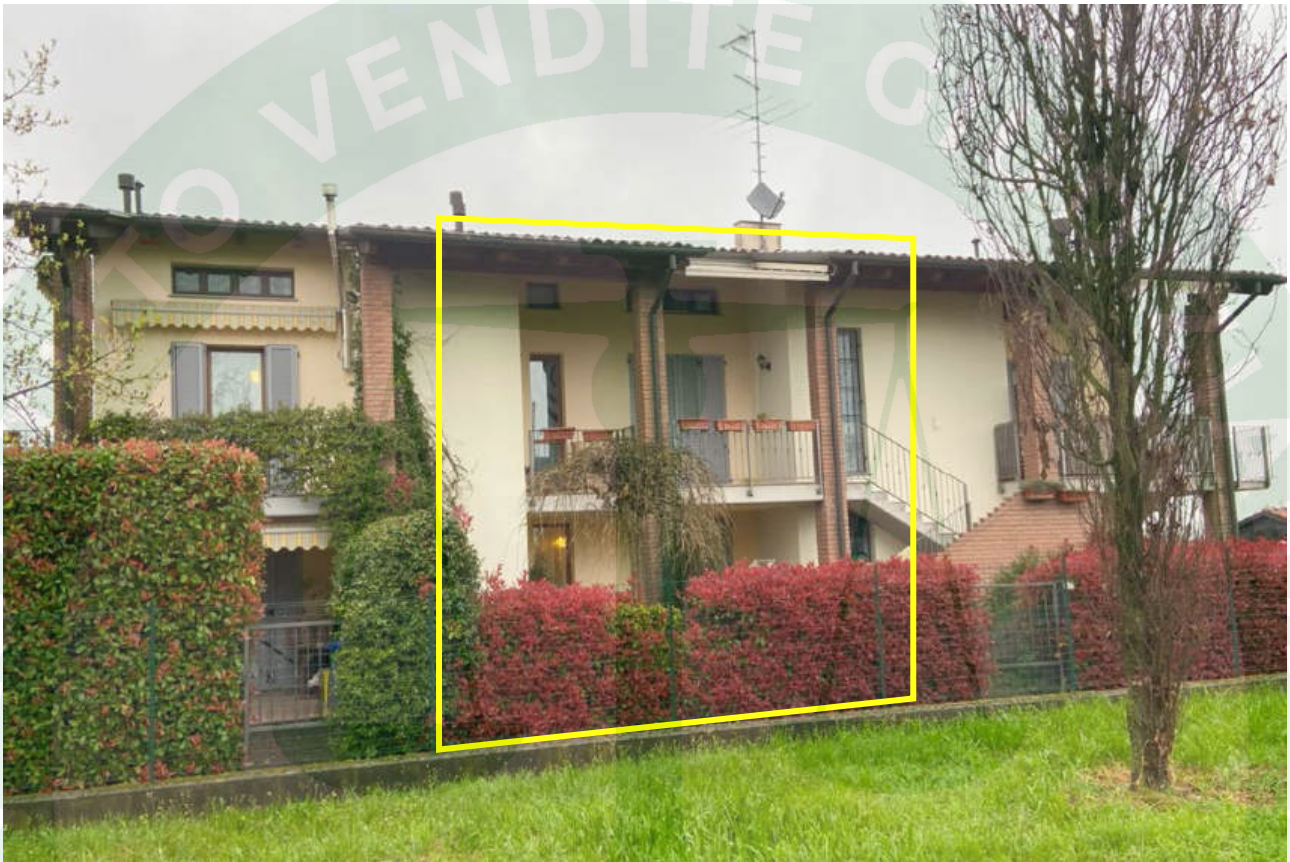
Vista fronte sud
