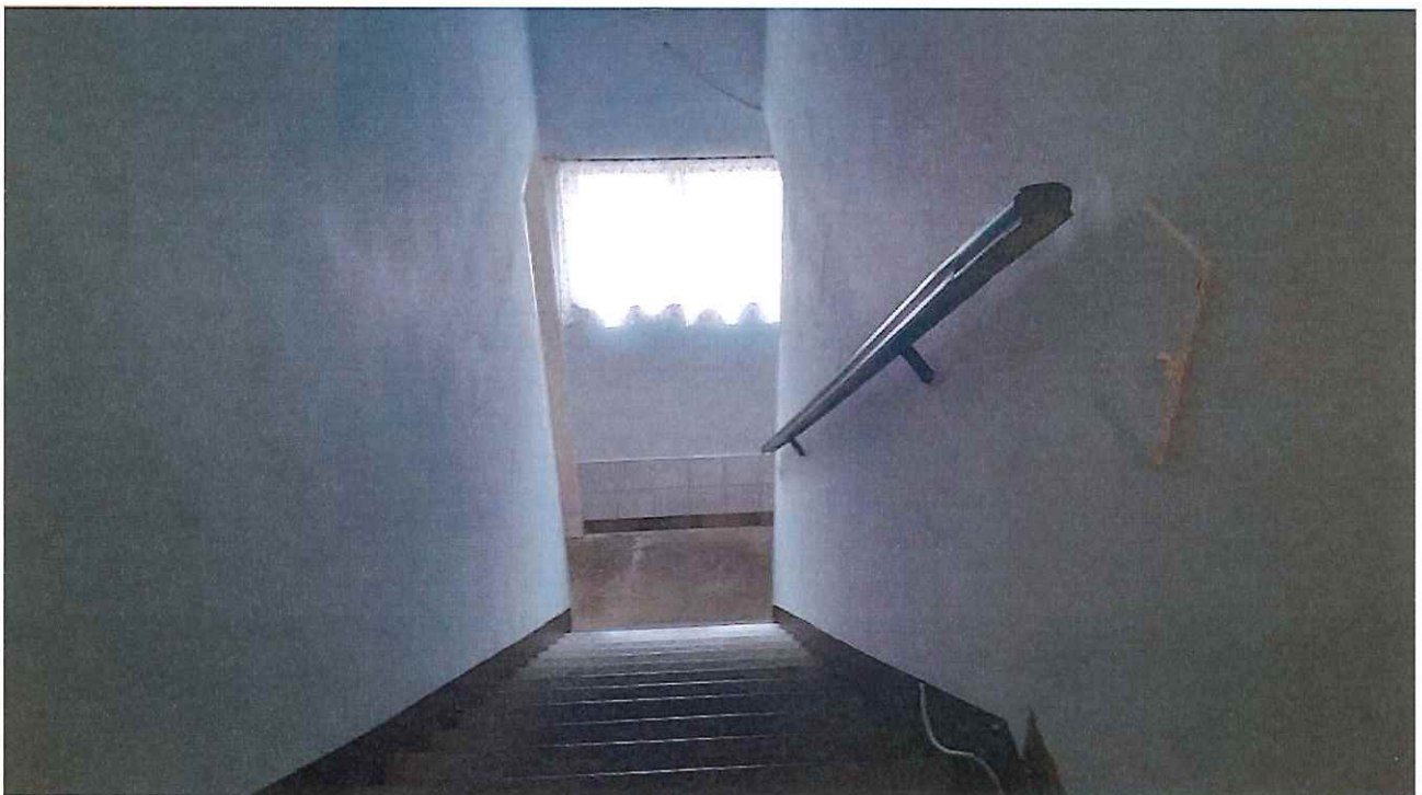
Figura 16 SCALA ACCESSO PIANO INTERRATO
