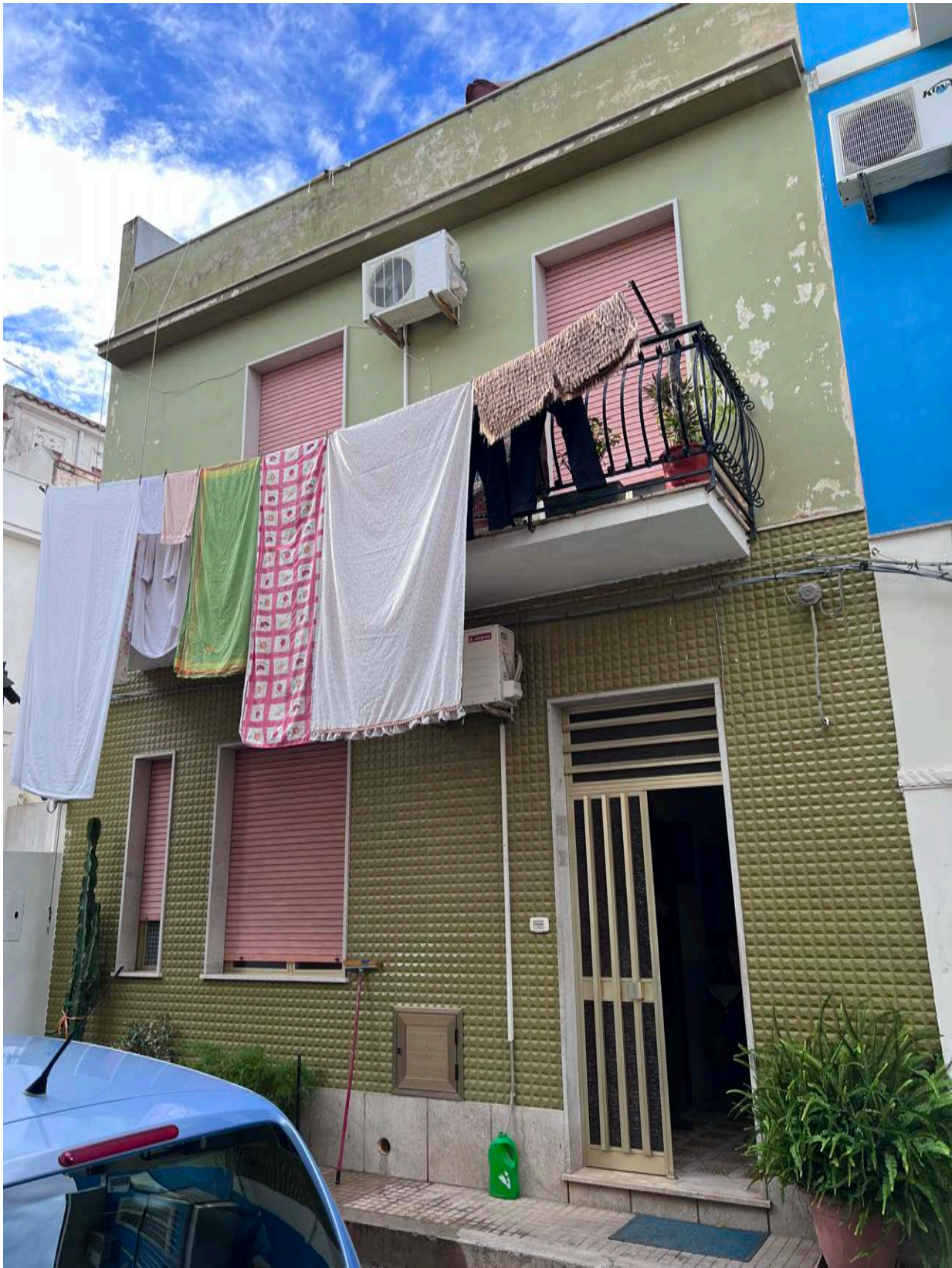
Foto degli esterni e degli interni (sopralluogo)
