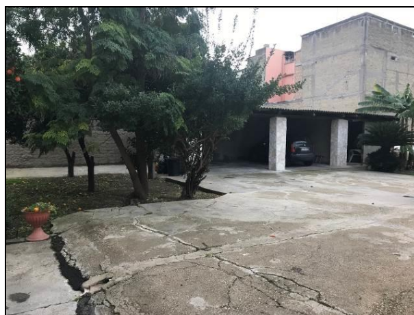
Area esterna al fabbricato
