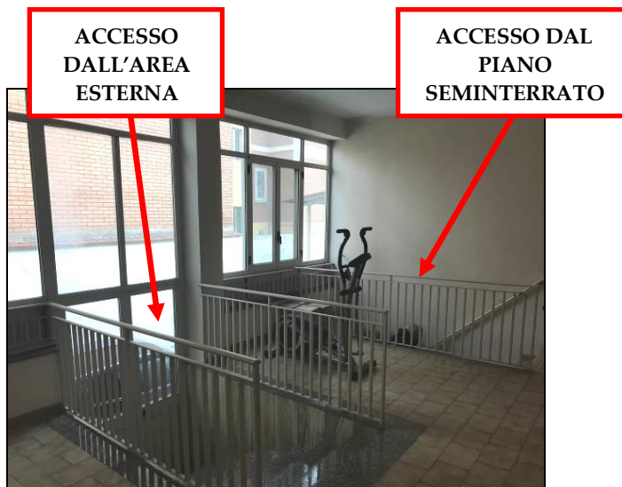
Scale di accesso al piano rialzato
