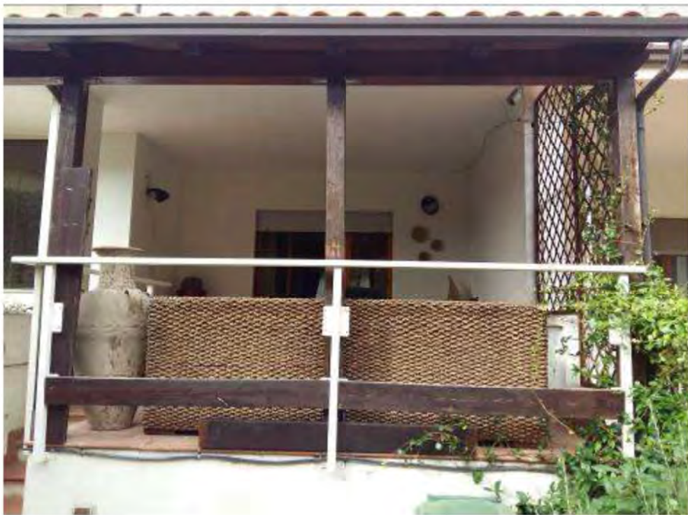
Veranda vista da giardino
