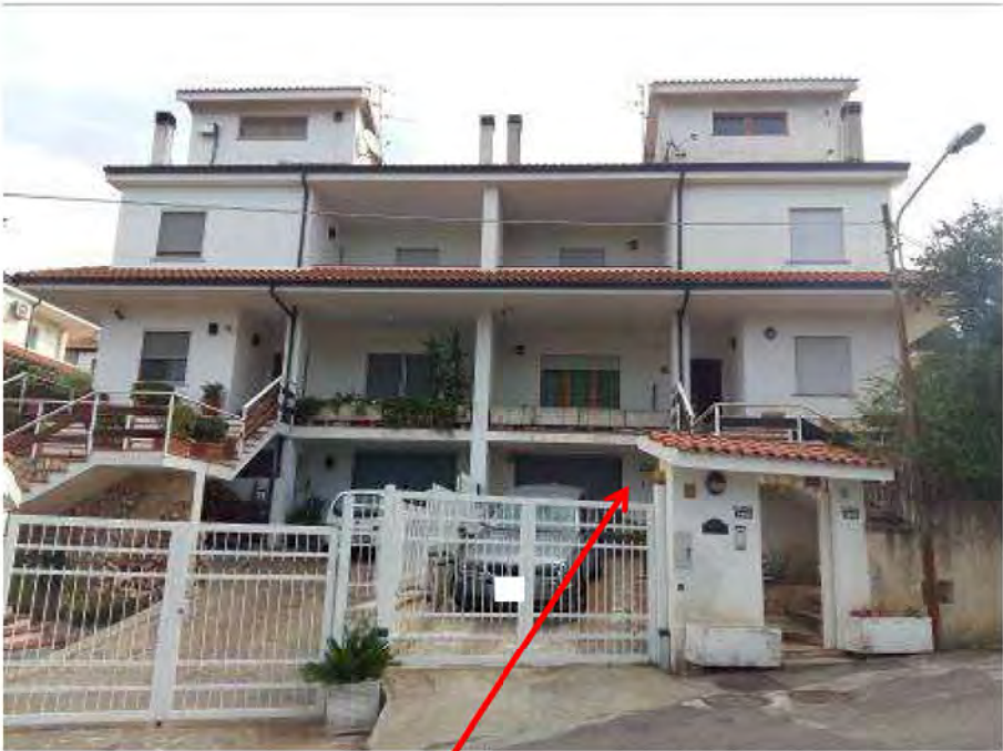
Villa bifamiliare (fabbricato interessato porzione di destra) – lato Ovest
