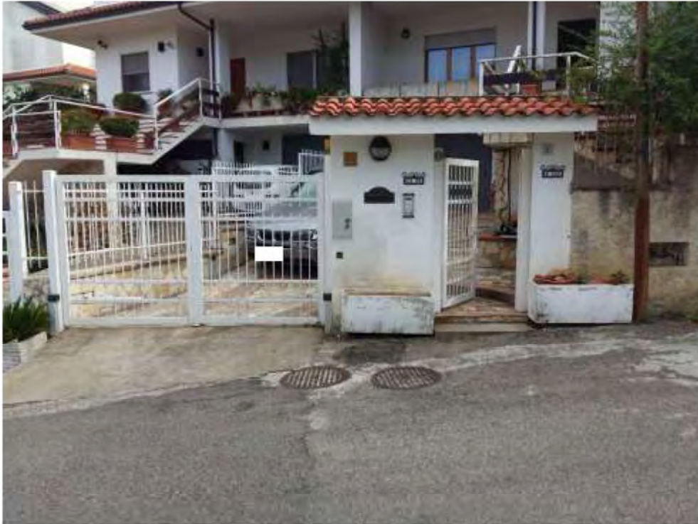
Ingresso carrabile e pedonale
