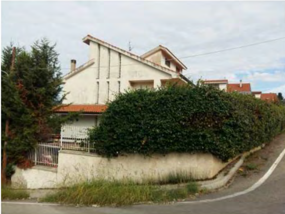
Villa bifamiliare (fabbricato interessato) – lato Sud
