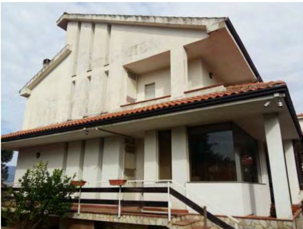
Villa bifamiliare (fabbricato interessato) – prospetto lato Sud
