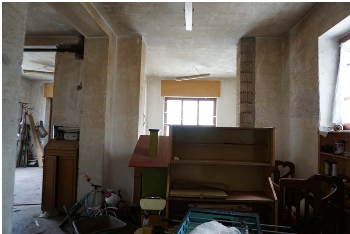
Foto n. 3 Lab. artigianale 3 Piano terra
