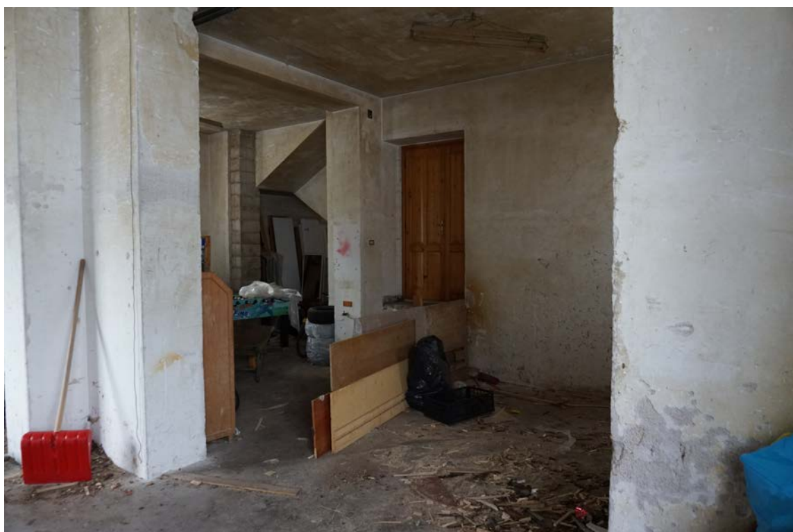
Foto n. 4 Lab. artigianale 4 Piano terra
