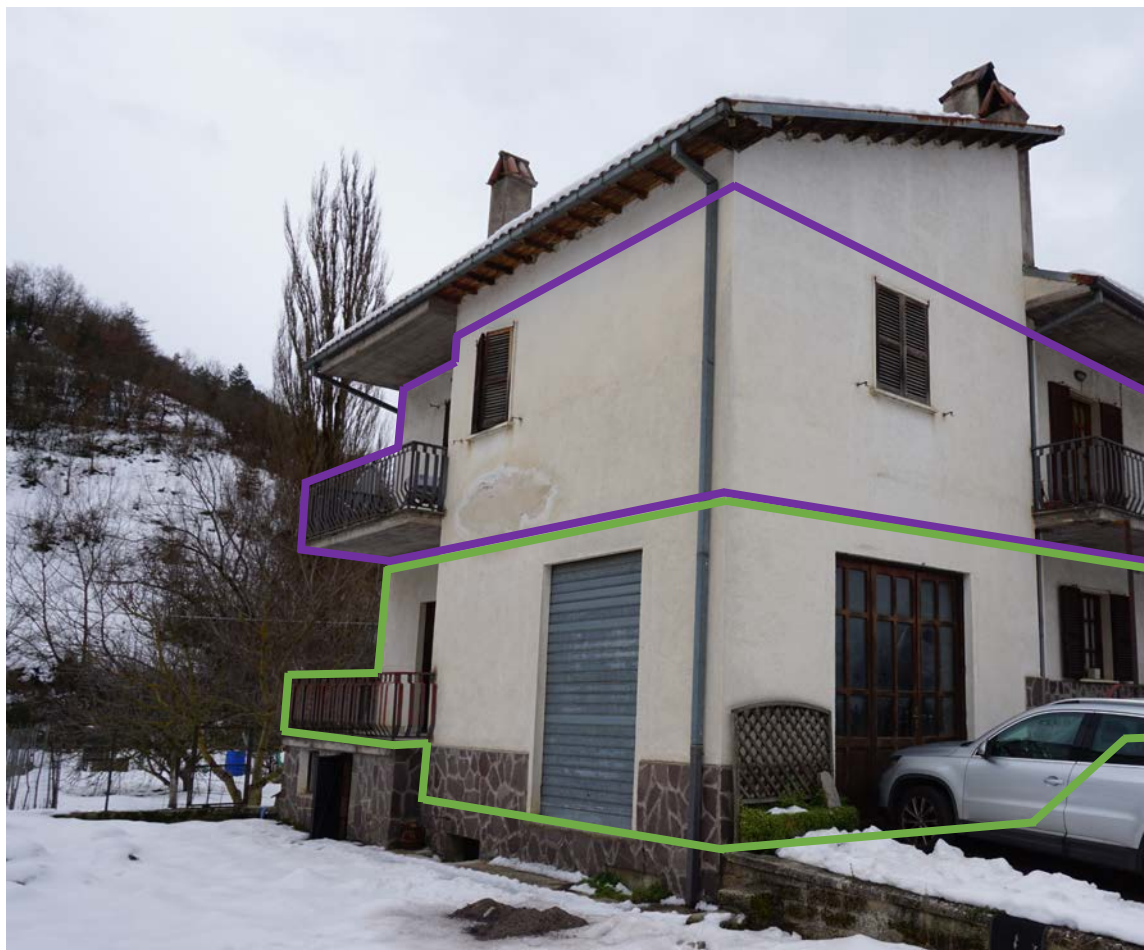
Foto n. 3 Esterno del Fabbricato Prospetto Nord- Ovest Lotto 001 - 002 - 003 - 004
