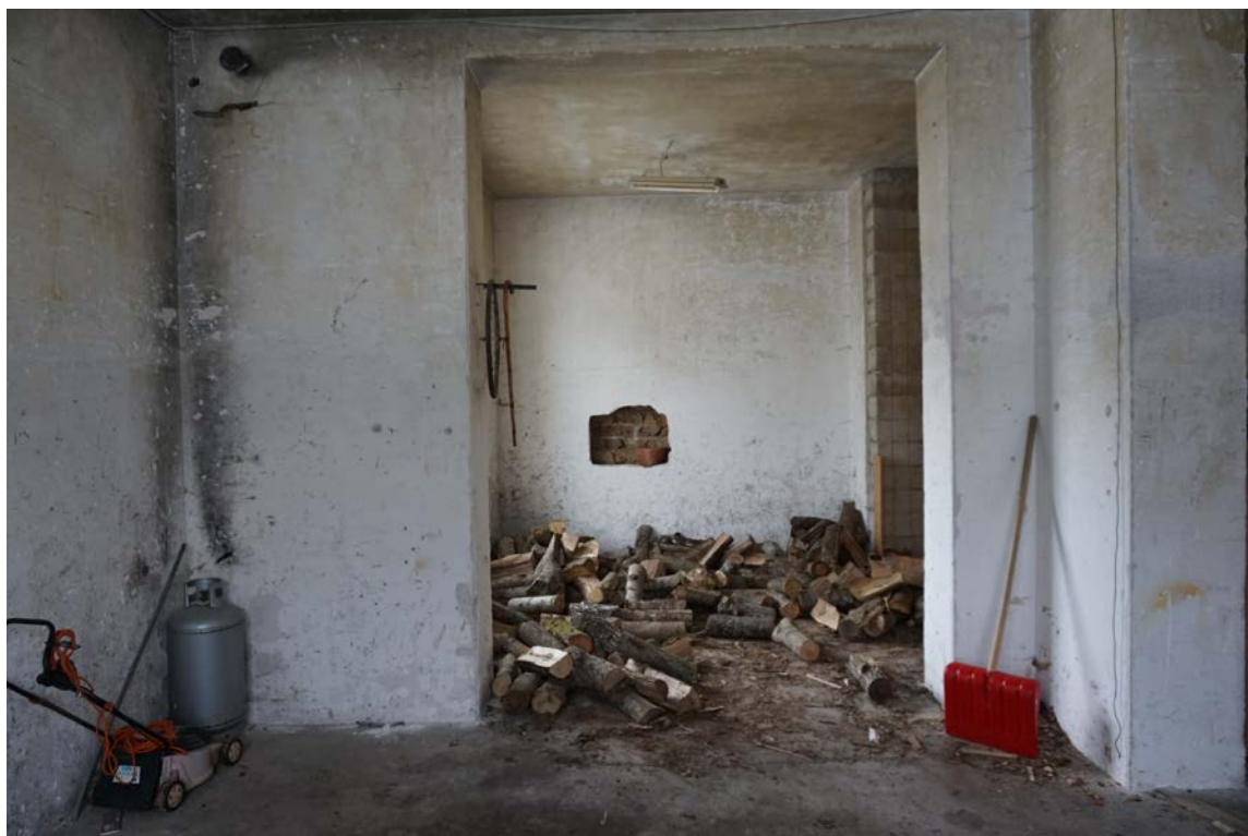
Foto n. 1 Lab. artigianale 1 Piano Terra
