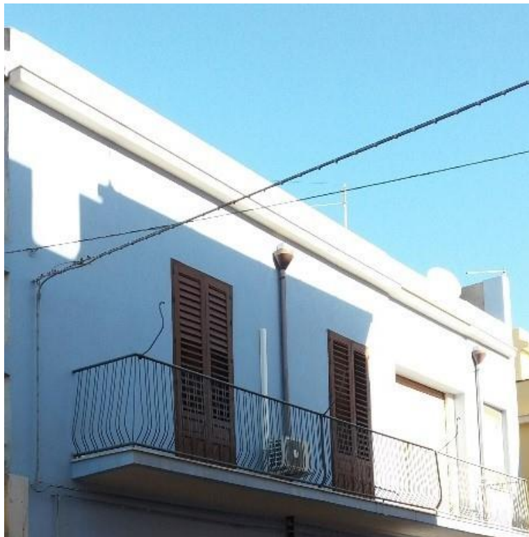
FOTO IMMOBILE SITO IN PACHINO (SR) VIA S. BUGGIA N° 10 PIANO PRIMO
