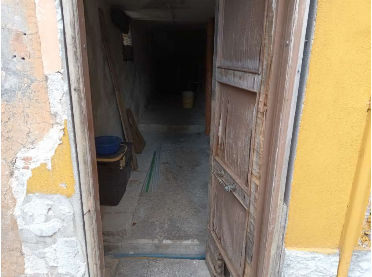
Foto n. 29 – Porta del locale di servizio comune
