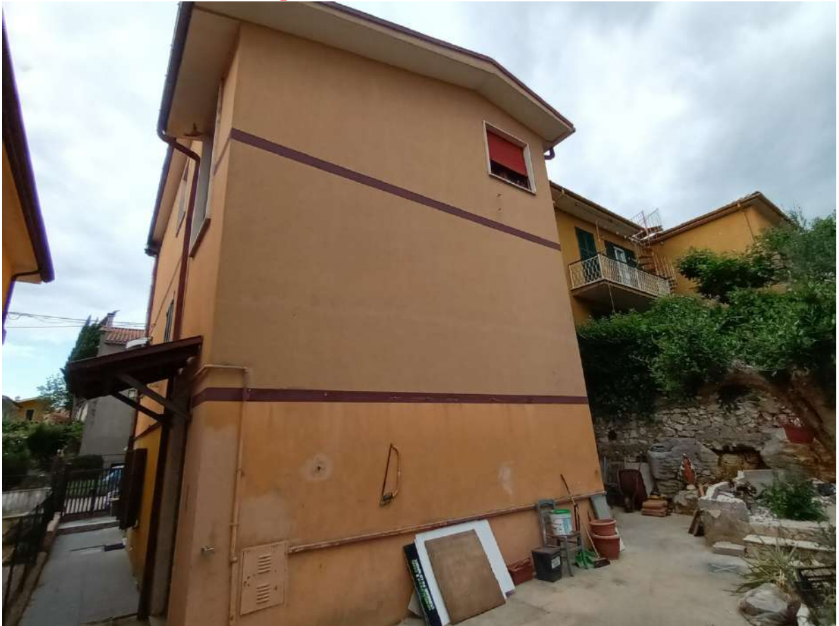
Foto n. 5 – Lato posteriore dell'edificio, dove è ubicata la scala
