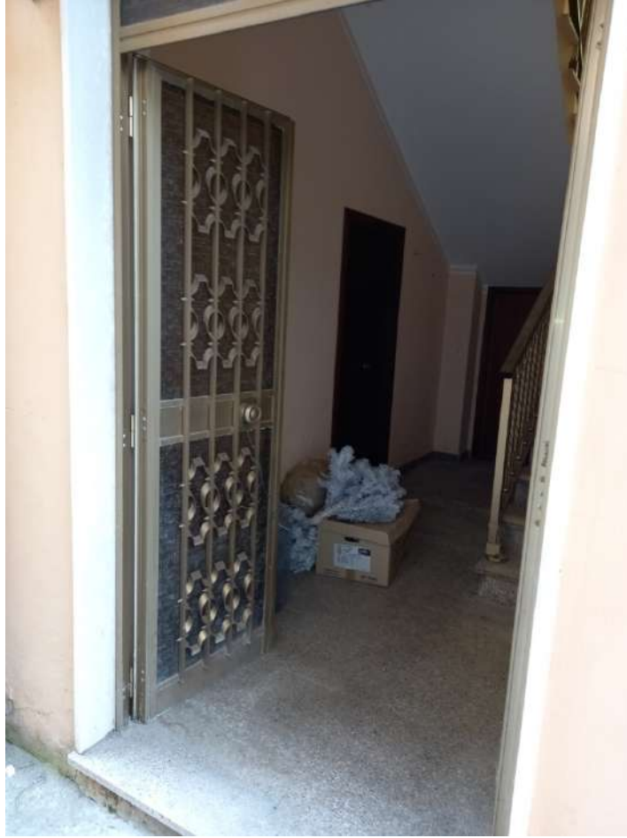
Foto n. 7 – Porta di ingresso alla scala
