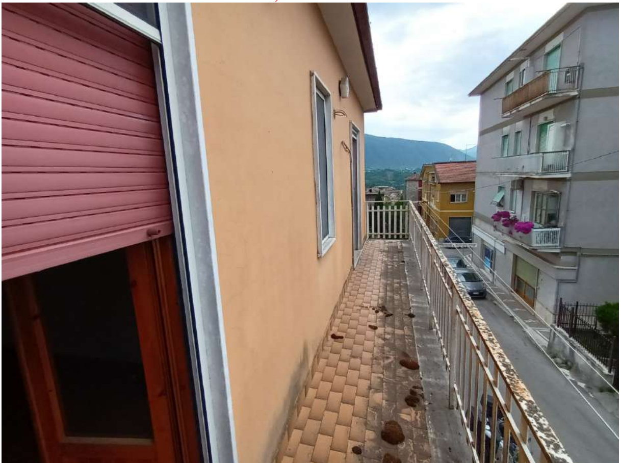
Foto n. 28 – LOTTO n. 2 – Balcone, comunicante con entrambe le stanze da letto
