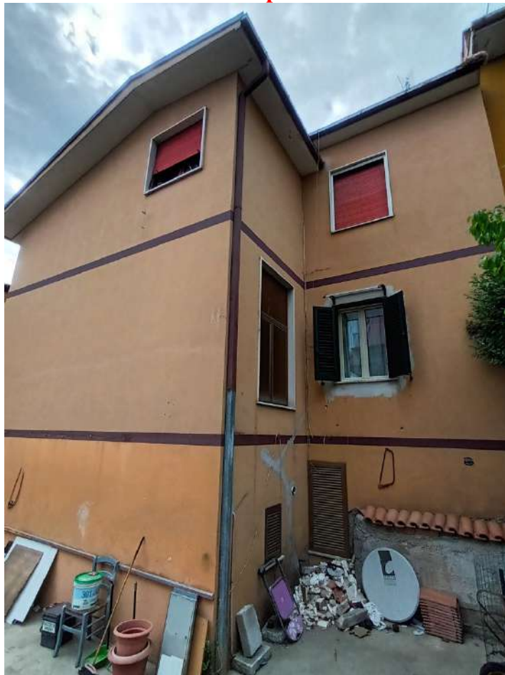
Foto n. 6 – Ancora lato posteriore dell'edificio
