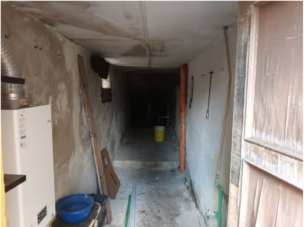
Foto n. 30 – Locale di servizio comune
