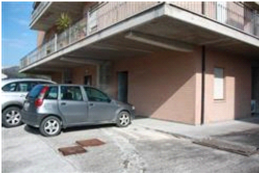
vista fabbricato piano terra
