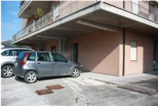
vista fabbricato piano terra
