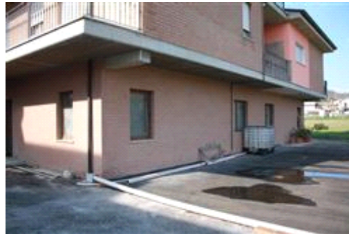
vista corte esclusiva sprovvista di pavimentazione
