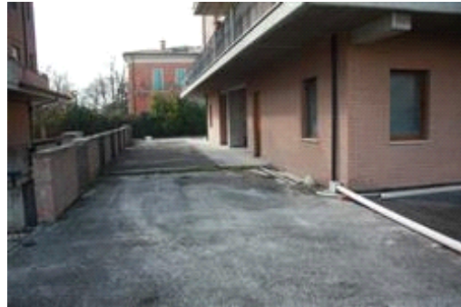
vista corte esclusiva sprovvista di pavimentazione
