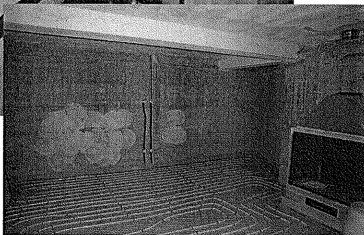
Foto 4 – interno locale di fianco al locale garage
