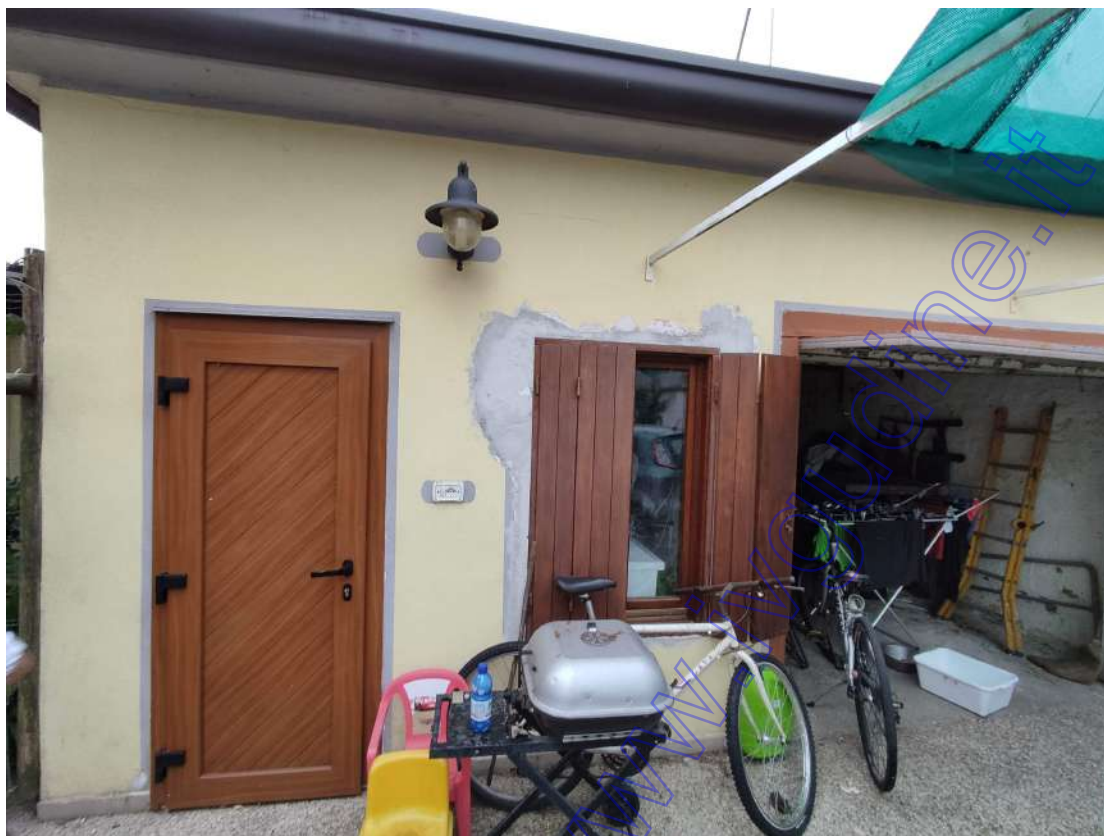
veduta del ripostiglio esterno e dell' autorimessa
