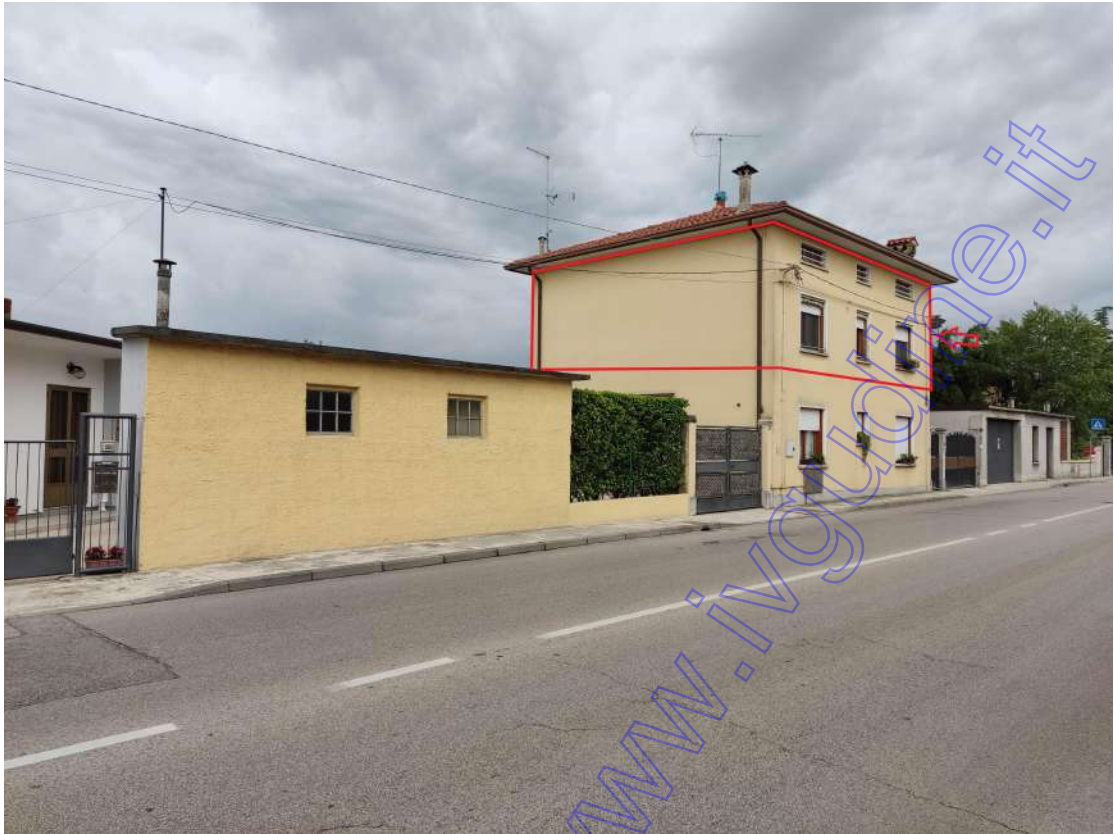
veduta esterna accesso da Via Circonvallazione Sud
