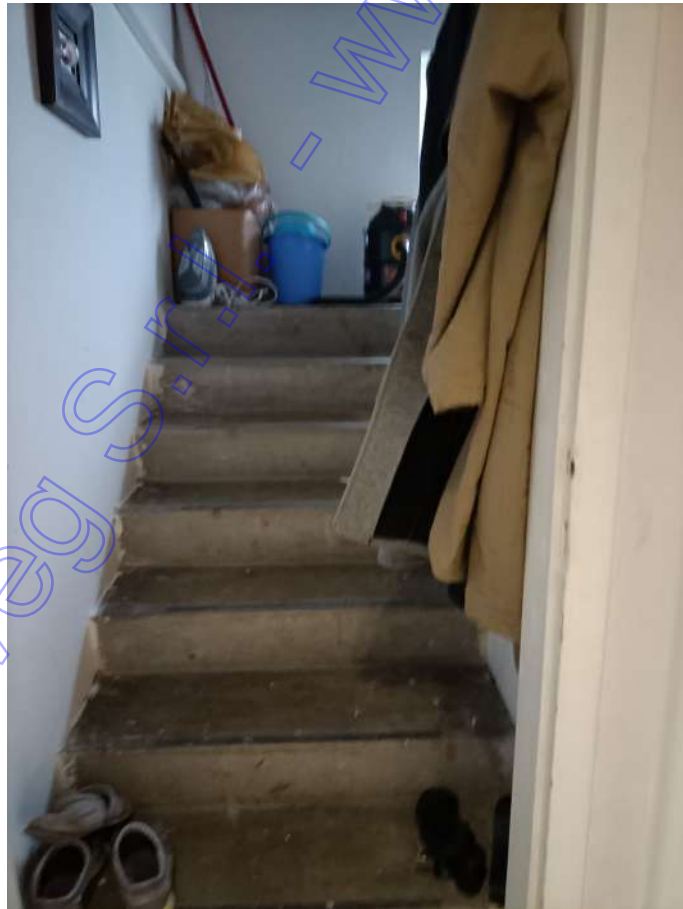
scala di accesso alla soffitta
