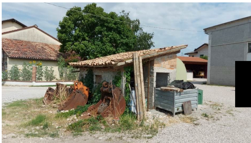
Fabbricato Secondario mn. 404 sub. 3
