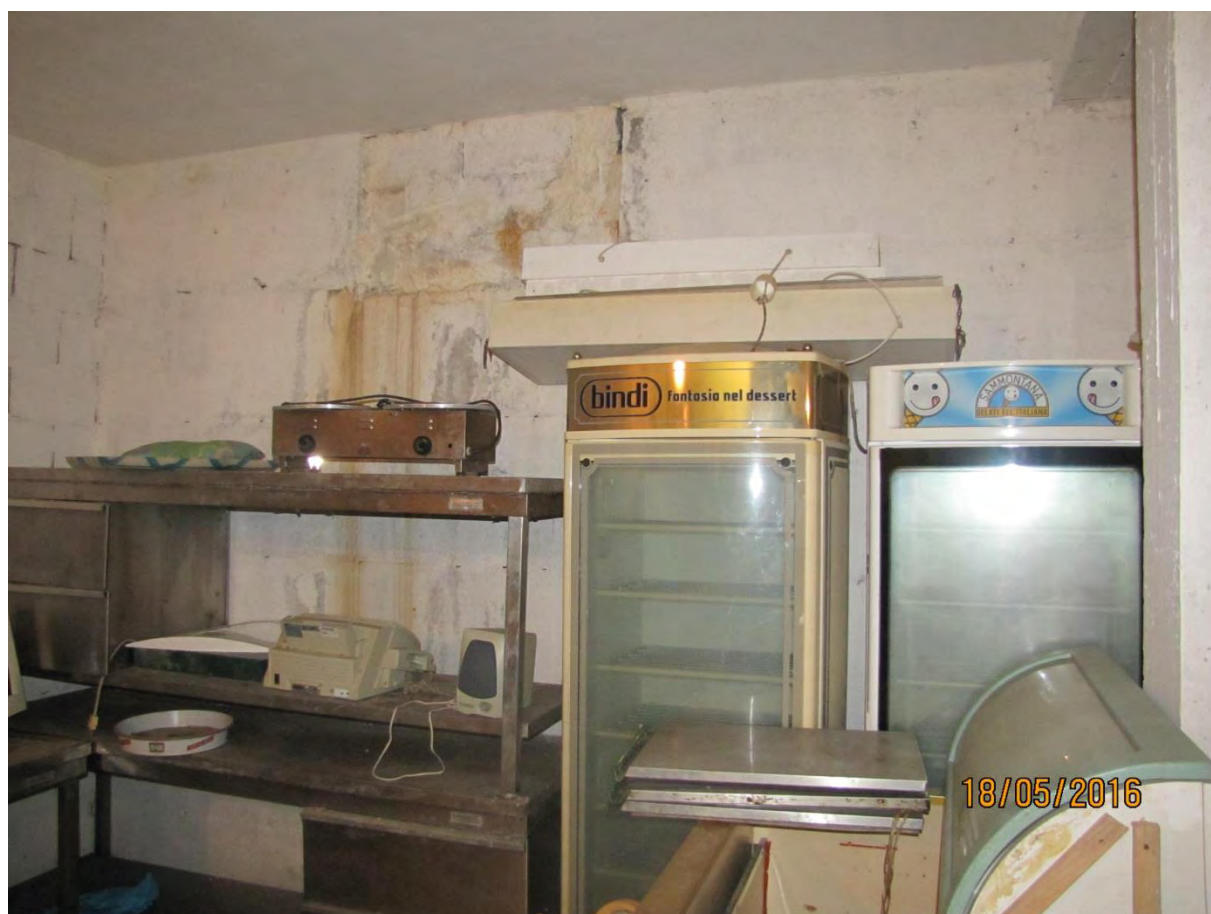
FOTO N°16 MAGAZZINO VISTA INTERNA
