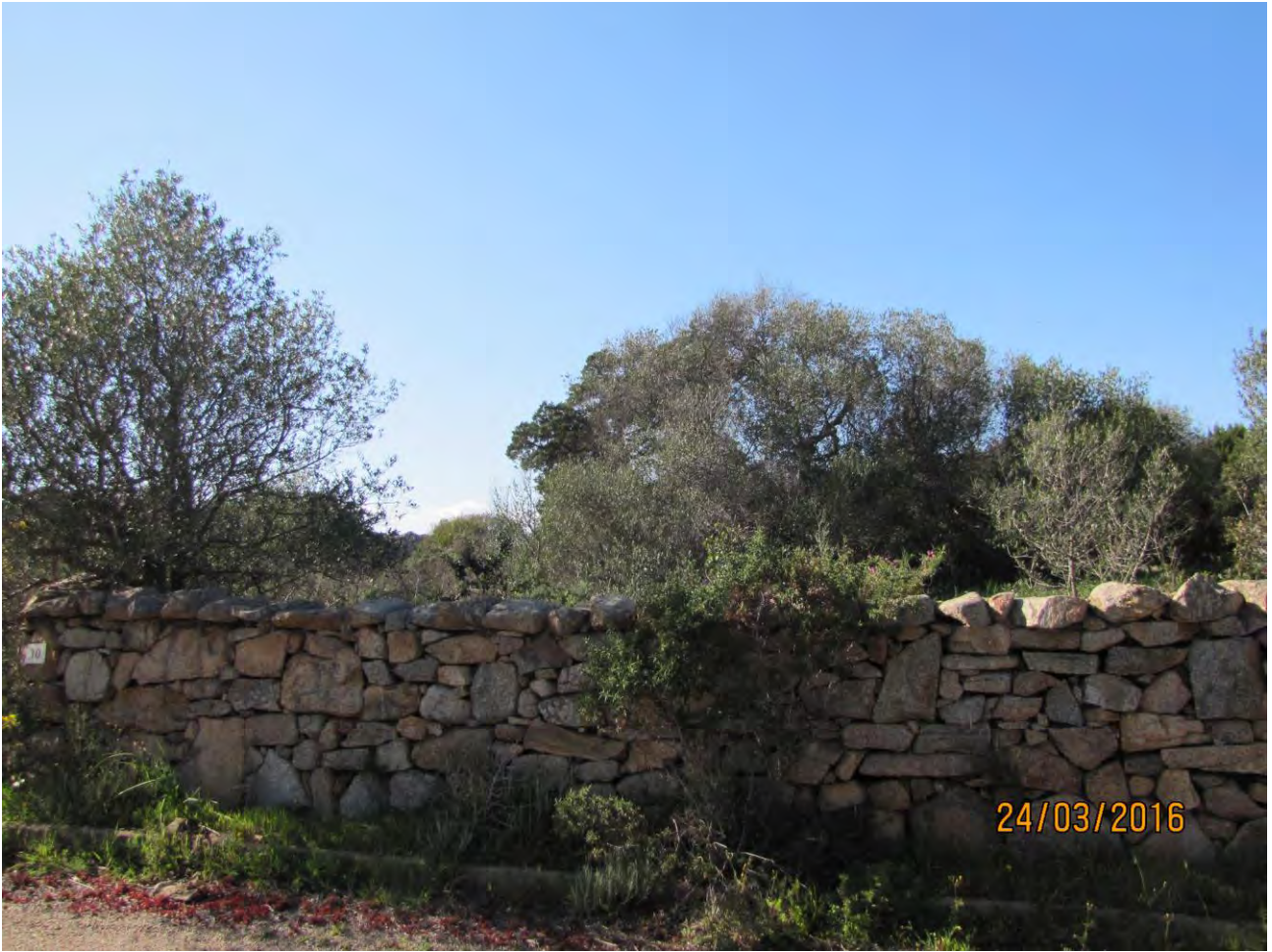
FOTO 3 VISTA MURO DI CONFINE
