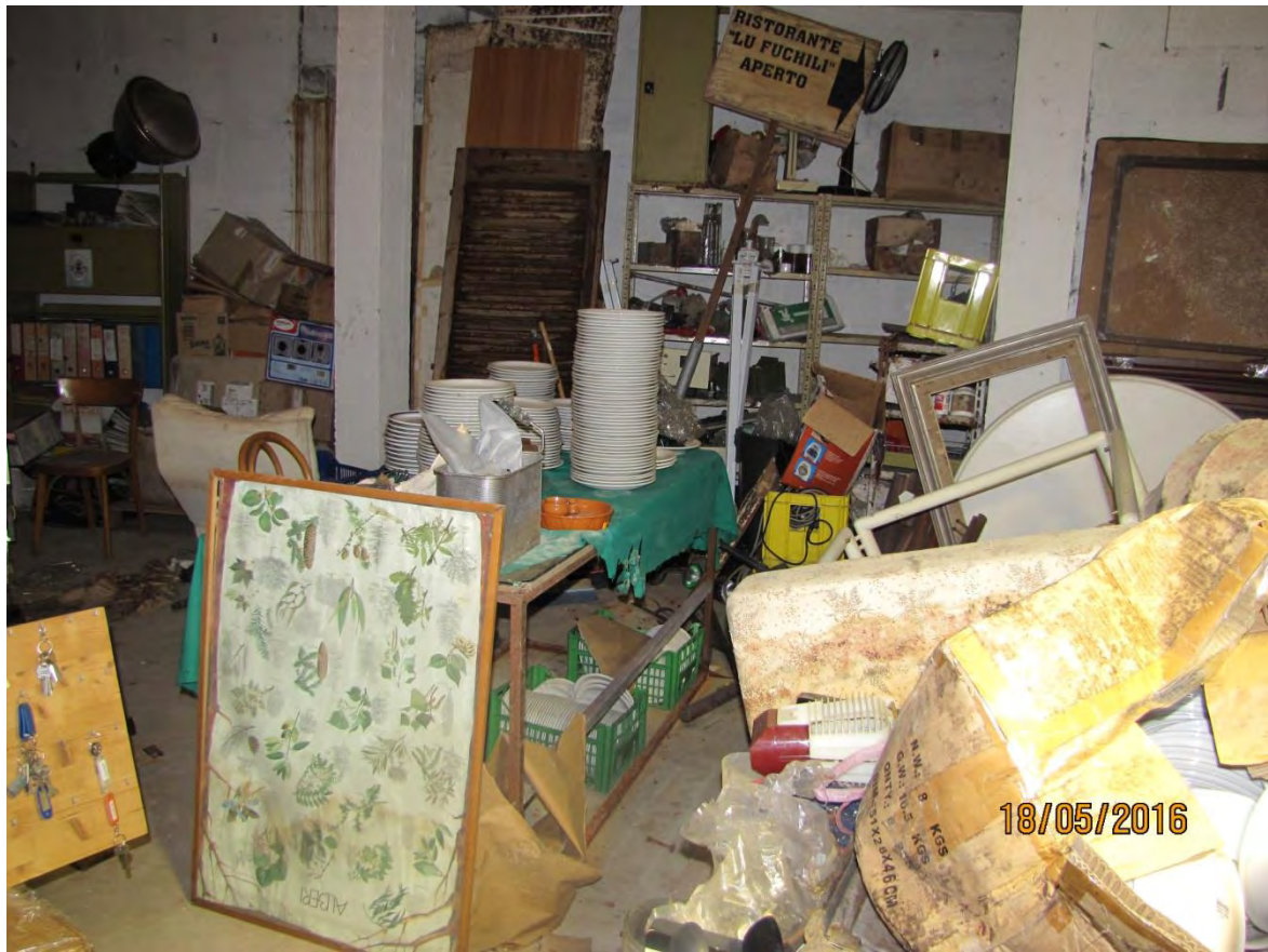
FOTO N°13 MAGAZZINO VISTA INTERNA
