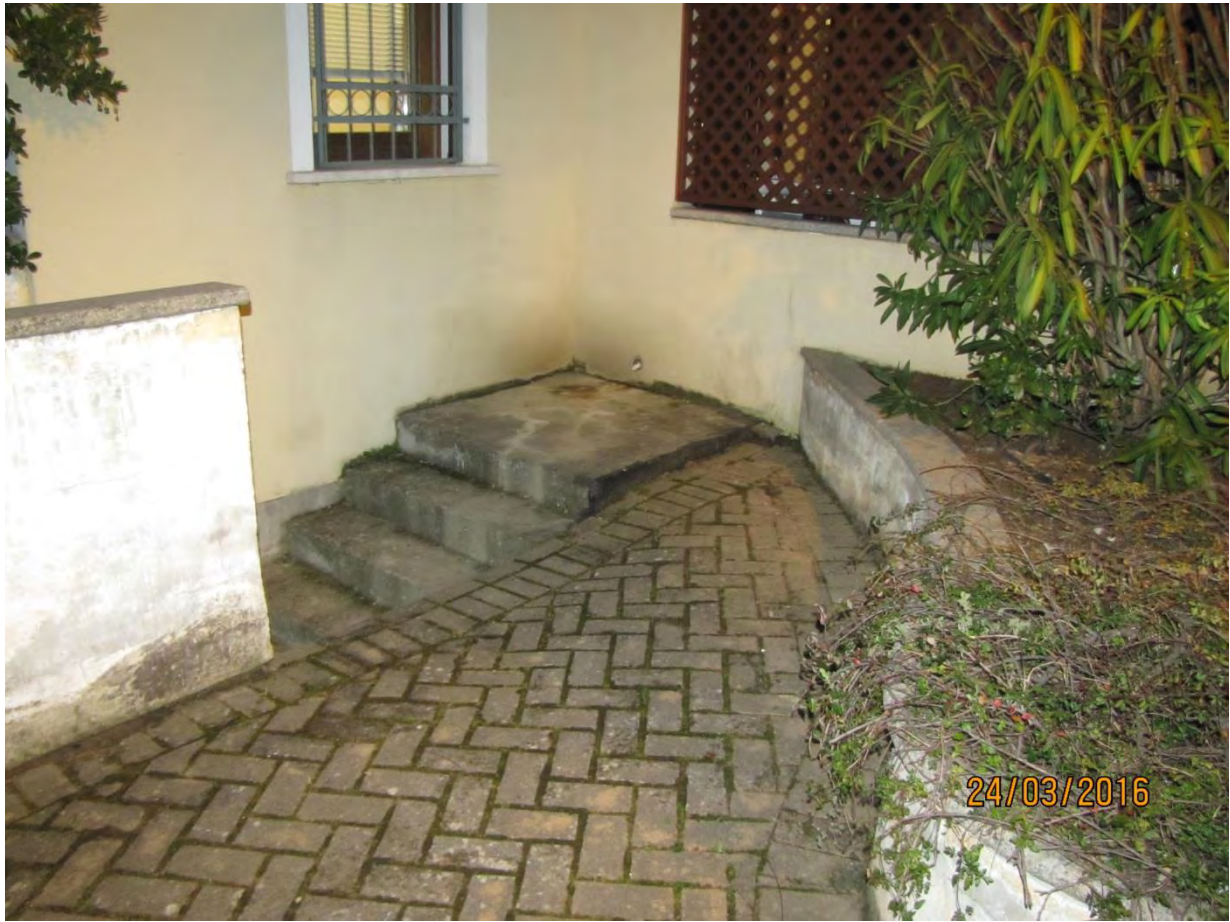
FOTO N°5 INGRESSO PEDONALE COMUNE
