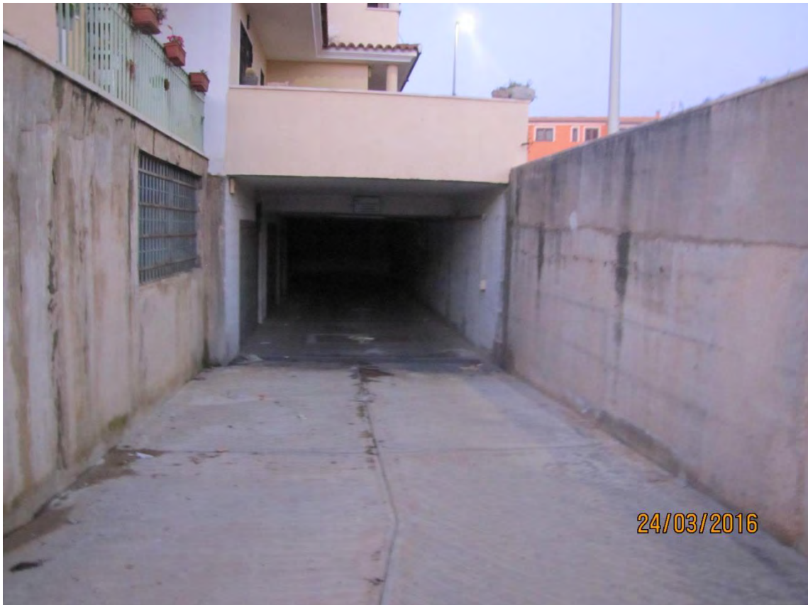
FOTO N°2 PARTICOLARE INGRESSO COMUNE
