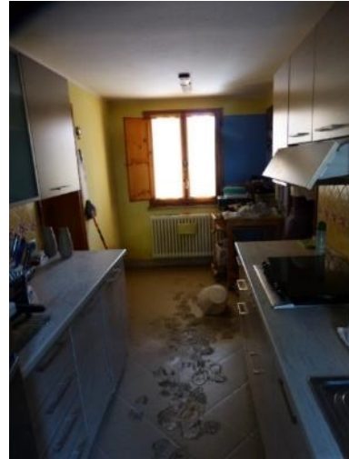
Vano lavanderia arredato a cucina
