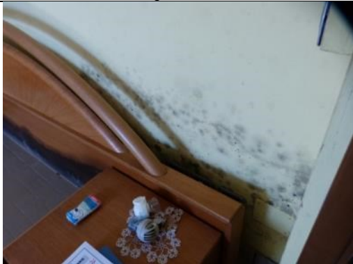
Particolare colonizzazione muffe
