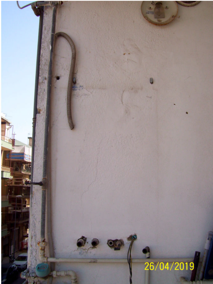
FOTO N. 18 PARETE DOVE ERA UBICATA LA CALDAIA
