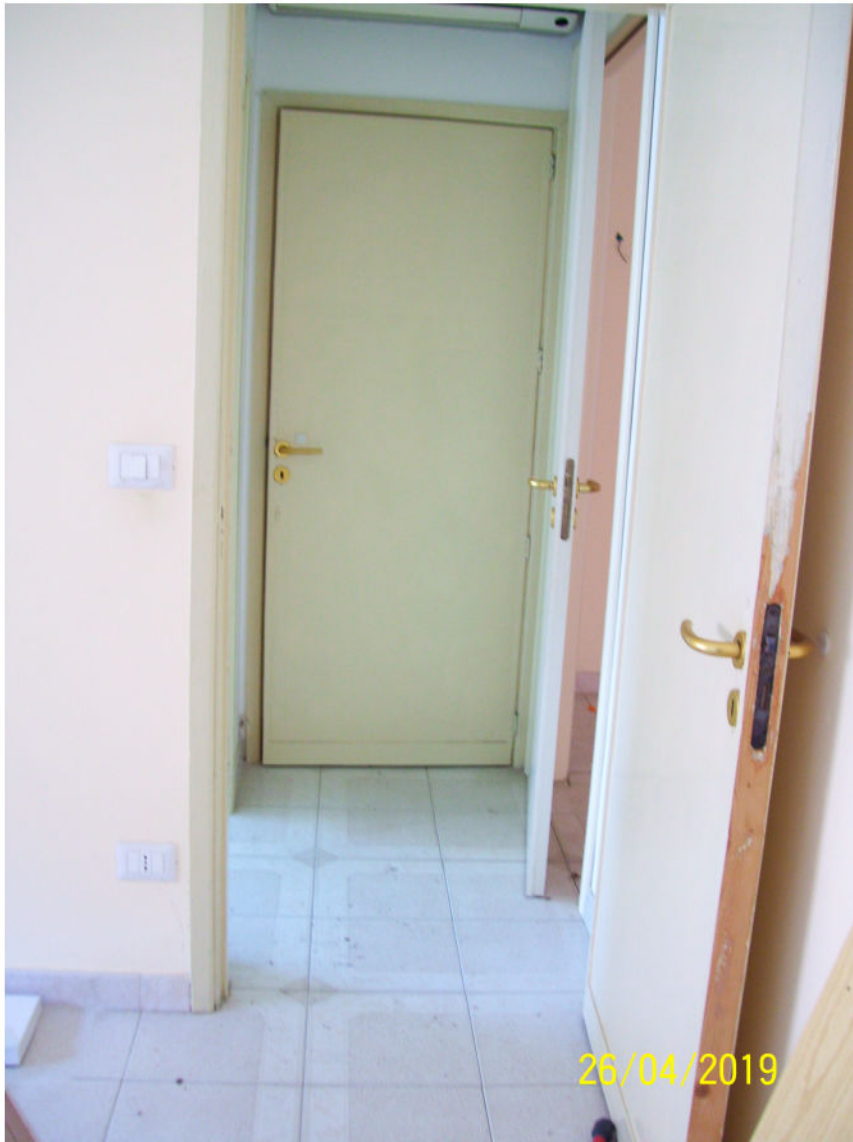
FOTO N. 33 INGRESSO CAMERA VISTA PORTA RIPOSTIGLIO
