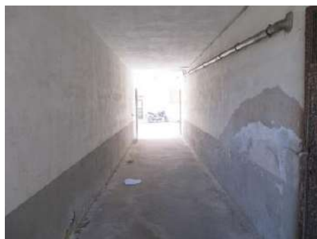
TUNNEL DI PASSAGGIO
