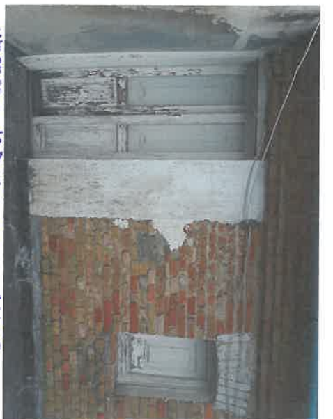
INGRESSO 1° PIANO DALLA TERRAZZA
