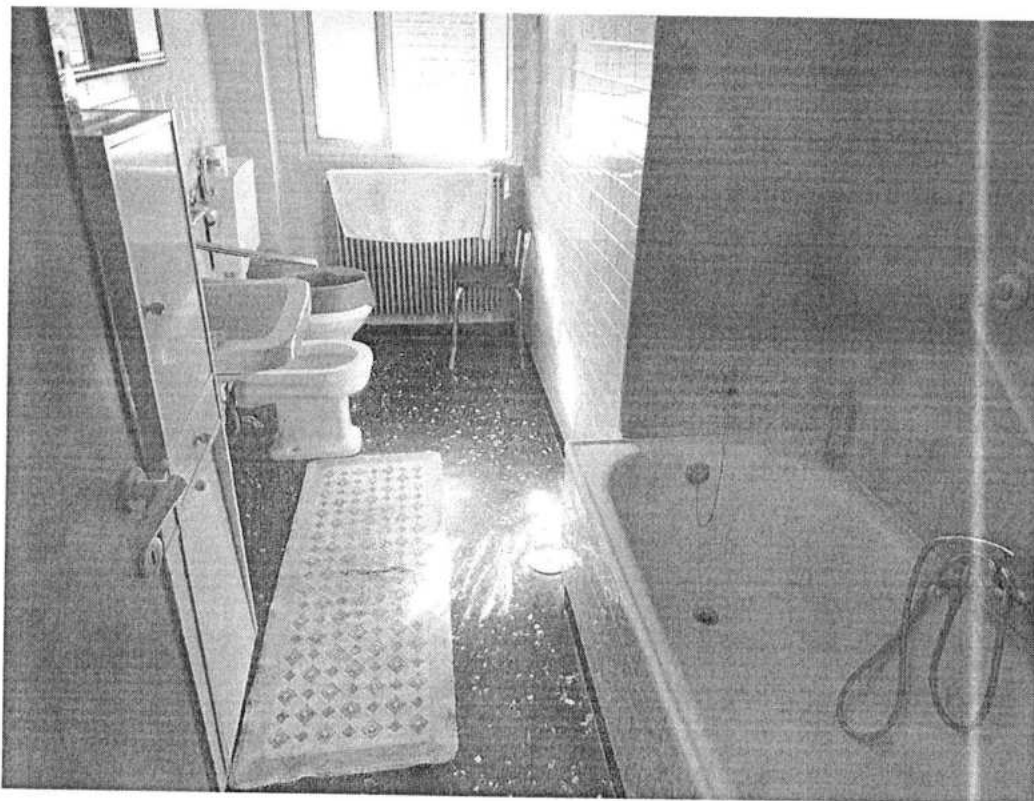
Foto 11 Scorcio del bagno.
