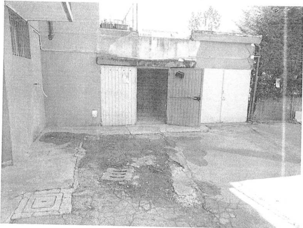
Foto 14 Vista del garage.
