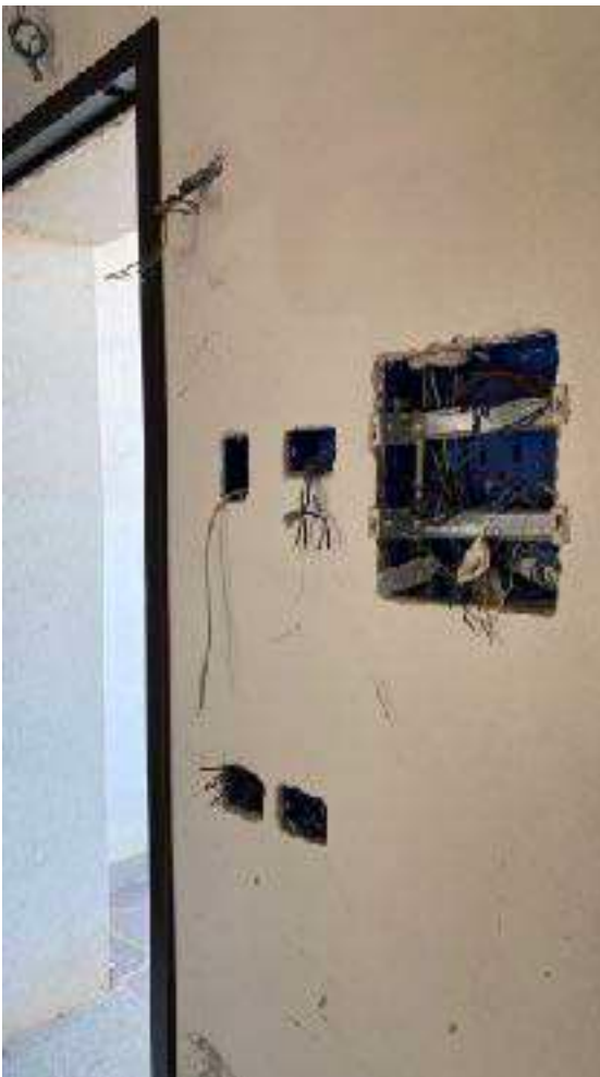
Villino bifamiliare sub 296 _ Ingresso
