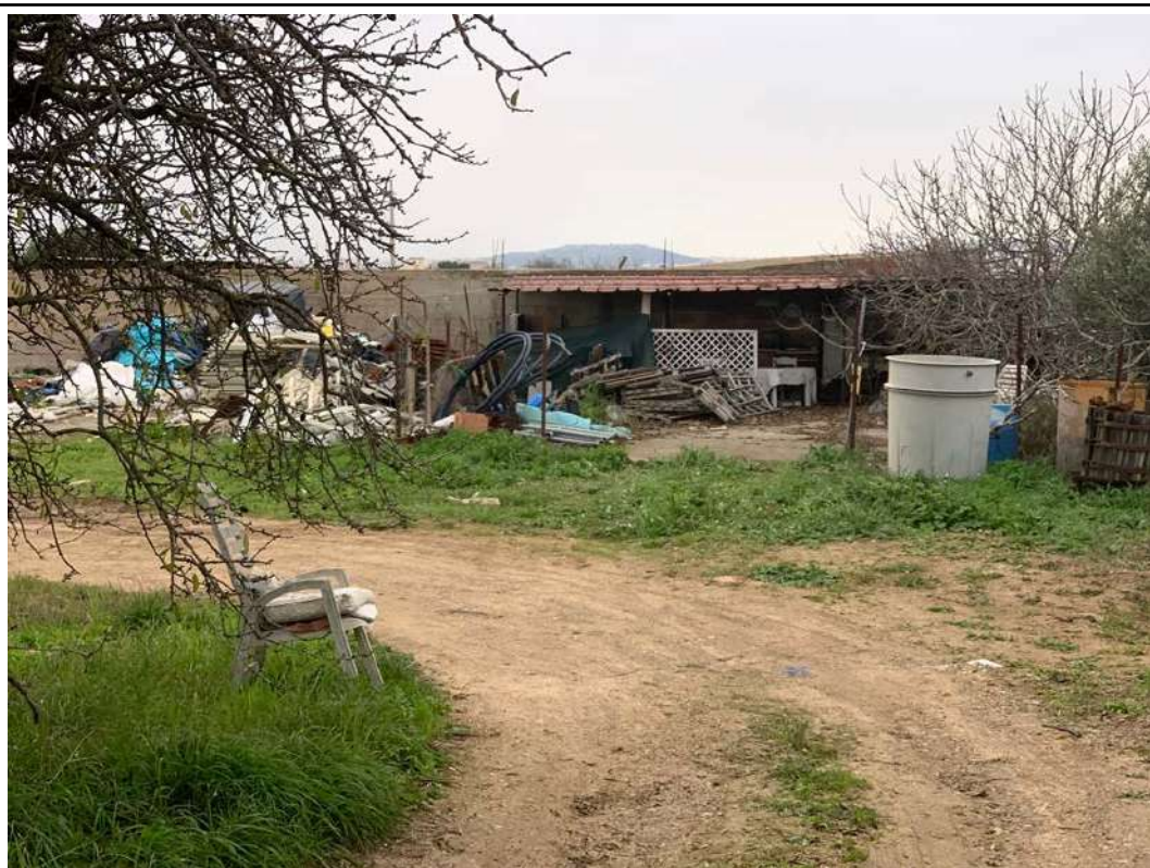
Figura 17 veduta dell'immobile in prossimità del confine col lotto rif. 3, nel dettaglio tettoie per ricovero attrezzi e accumulo materiali.
