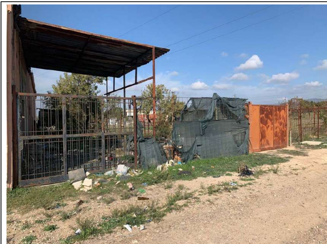
Figura 15 veduta dell'ingresso del lotto rif. 4 sul lato di via Puxeddu - tratto del comune di Quartu - (particella n. 557), nonché veduta di una copertura realizzata abusivamente
