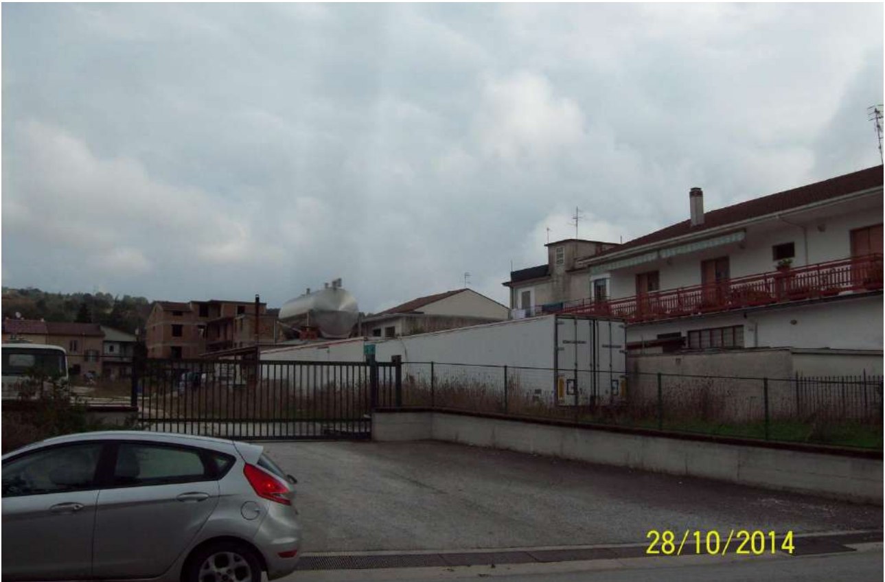
Autorimesse pertinenti al caseificio prefabbricate su area F.28 part.la 812(da accatastare) ed accesso part.la 815. Lotto n.3
