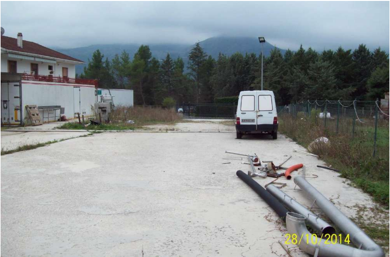
Vista dell'accesso al caseificio F.28,part.la 815. Lotto n.3
