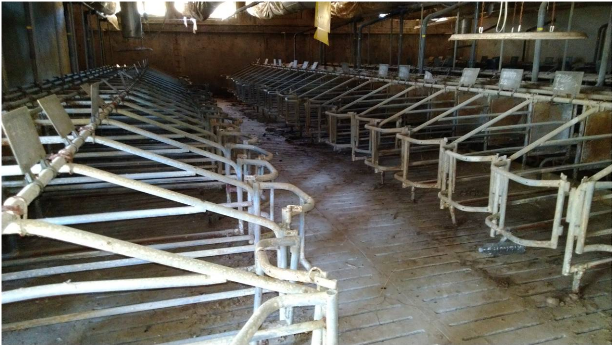
20 - BOX SCROFE- Strutture di copertura (Fabbricato Particella 145)
