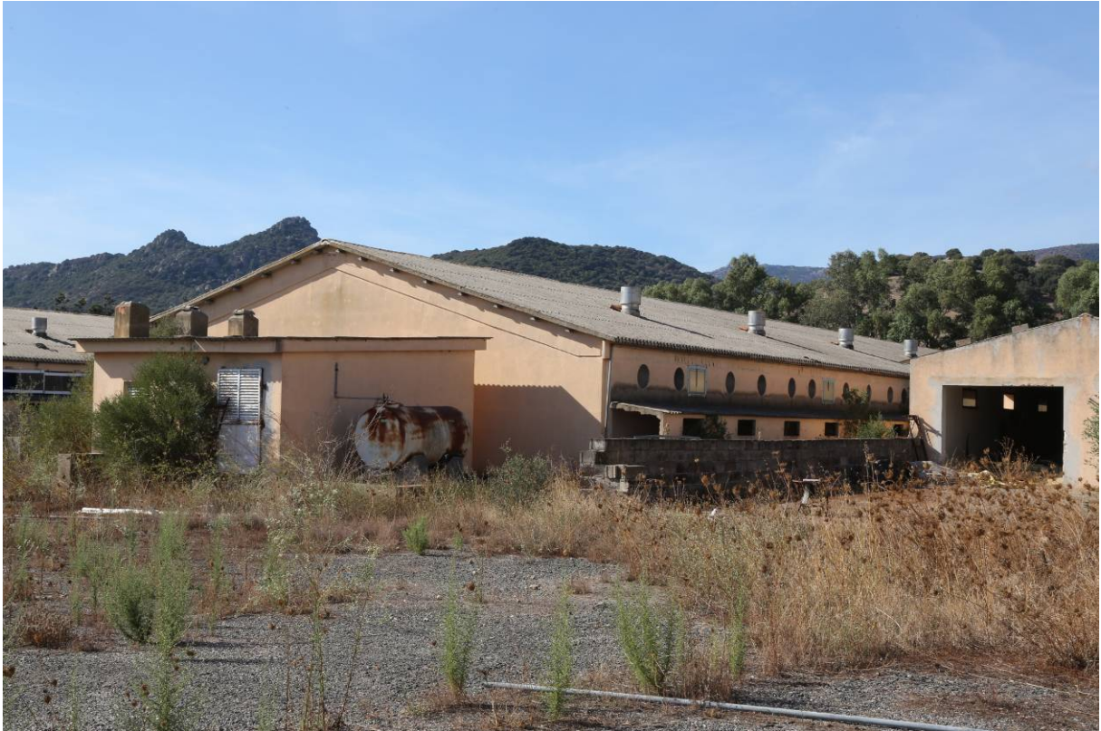
5 – BOX INGRASSO (Fabbricato Partic. 143 con antistante centrale termica Partic. 199)
