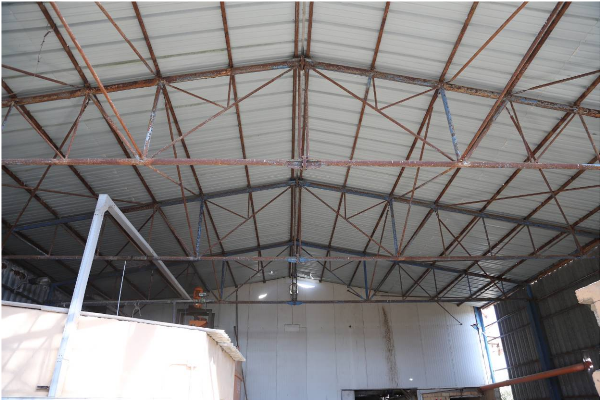
10 - VISTA INTERNA DEPOSITO MANGIMI (Fabbricato Particella 144)
