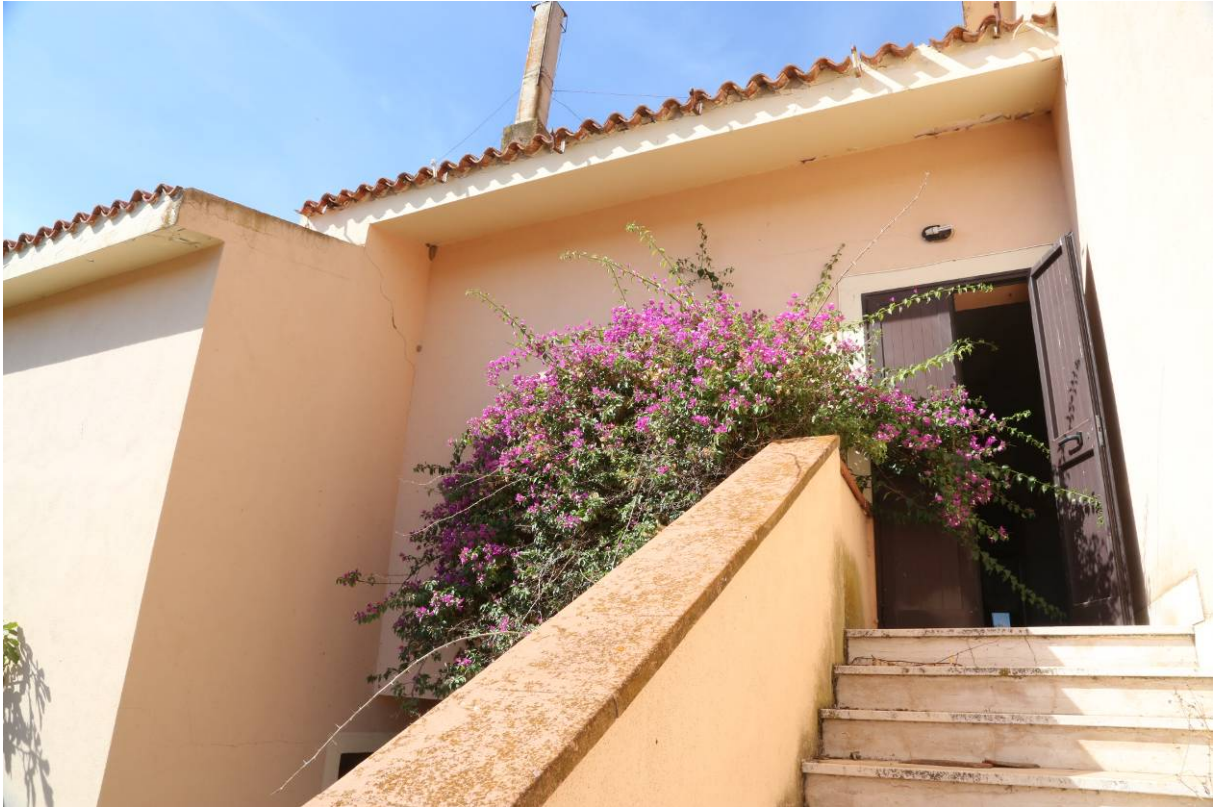
35 - APPARTAMENTO- Scala d'accesso (Fabbricato Particella 147 sub 3 piano 1°)
