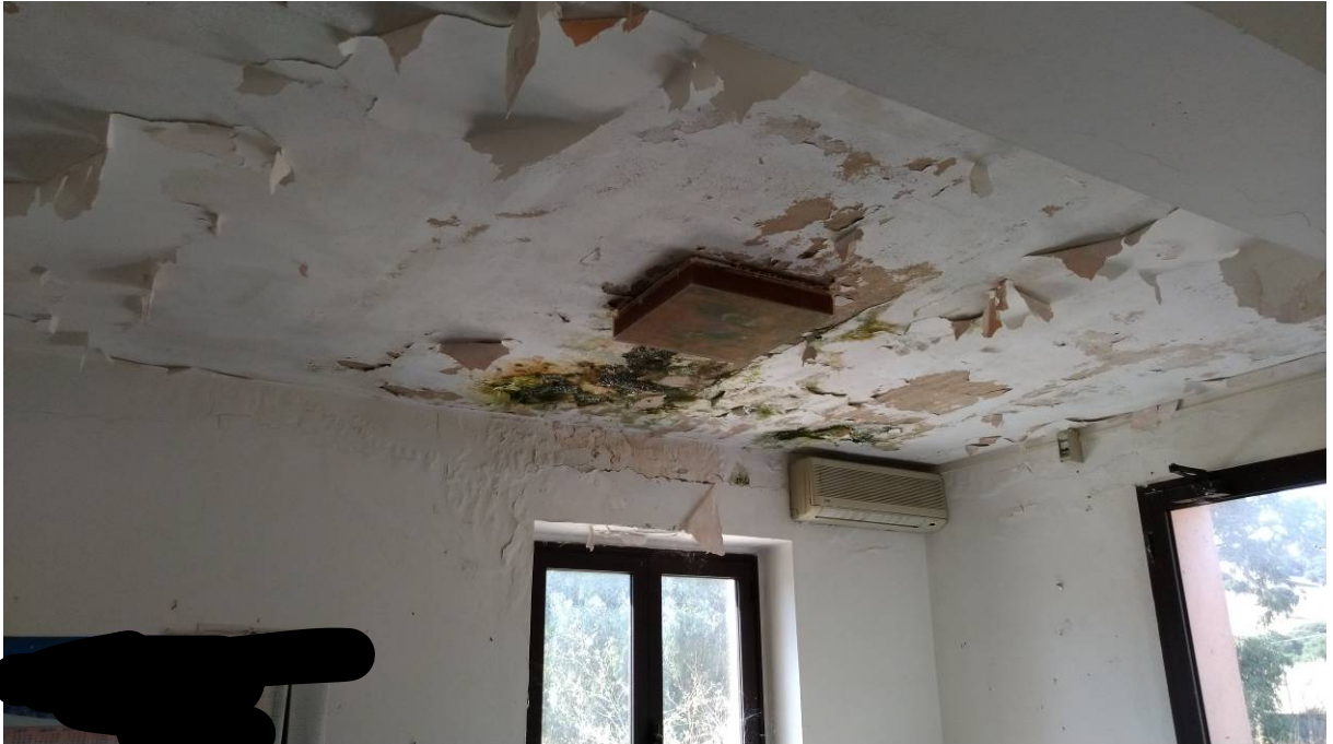
28 – UFFICI - (Fabbricato Particella 147 sub 1 piano terra)
