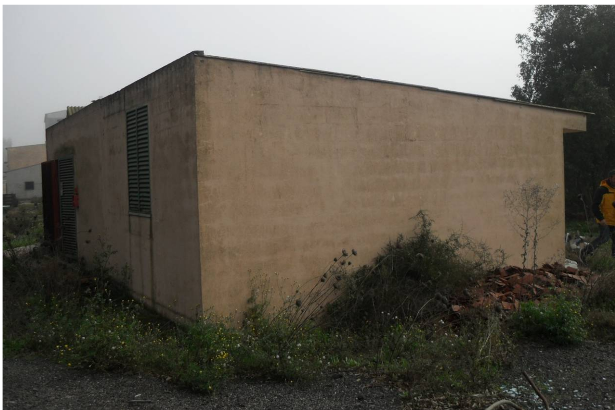
55 – LOCALE QUADRI (Particella 196)
