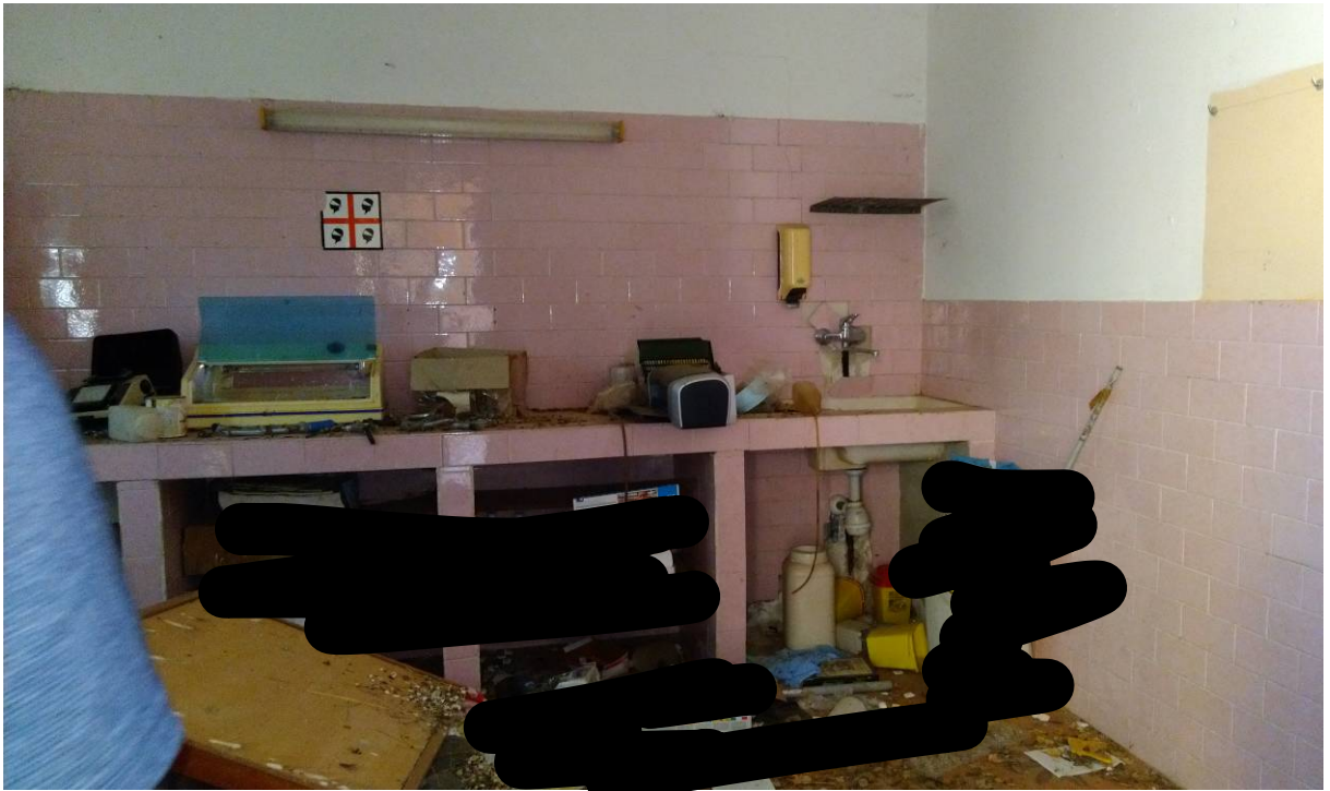
30 – LABORATORIO - (Fabbricato Particella 147 sub 1 piano terra)
