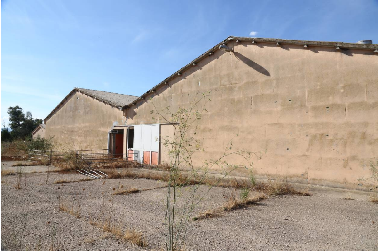
15 - BOX SCROFE (Fabbricato Particella 145)
