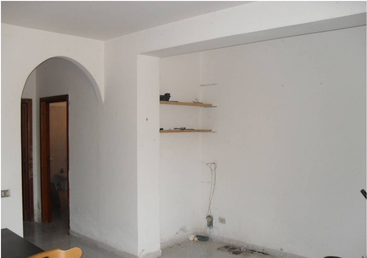
32 – CASA CUSTODE - (Fabbricato Particella 147 sub 2 piano terra) 1
