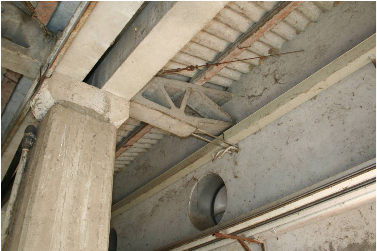
17 - BOX SCROFE- Strutture di copertura (Fabbricato Particella 145)
