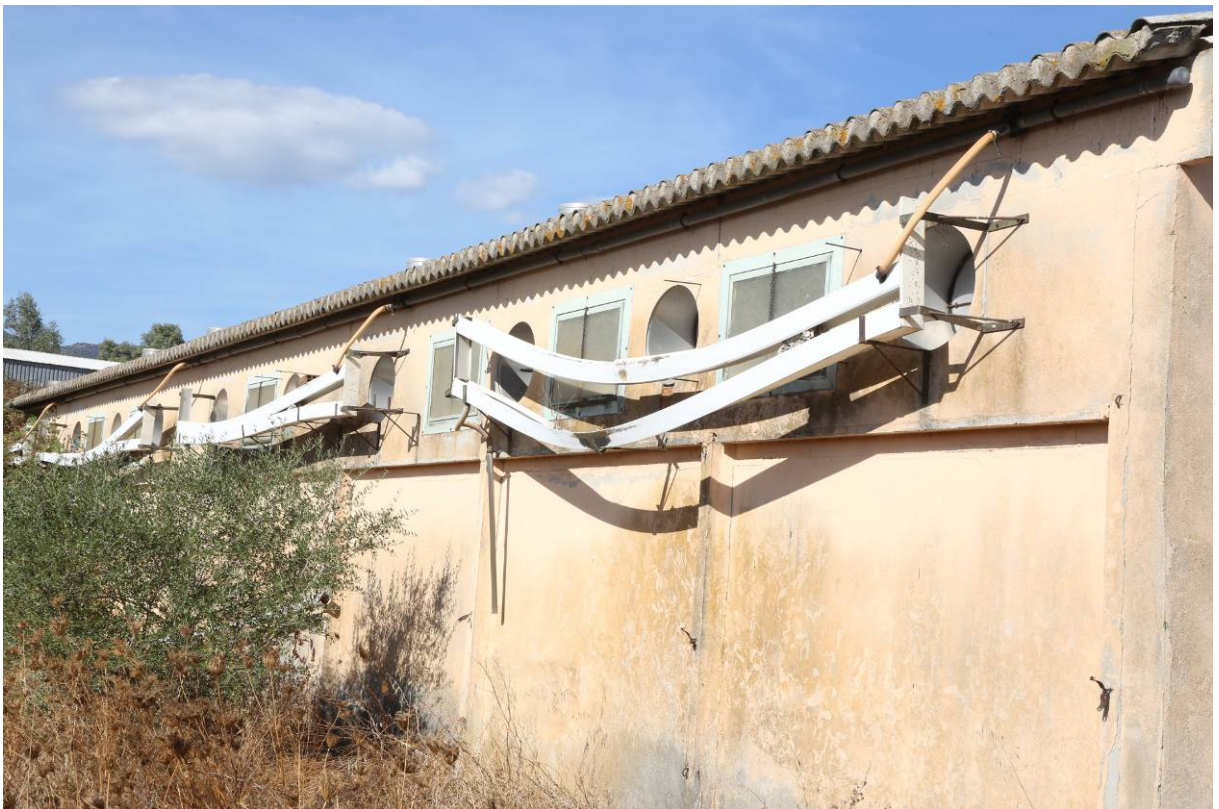
16 - BOX SCROFE (Fabbricato Particella 145)
