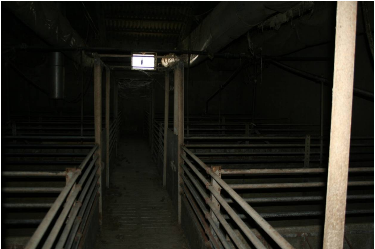
6 – BOX INGRASSO (Fabbricato Particella 143 vista interna dei box)
