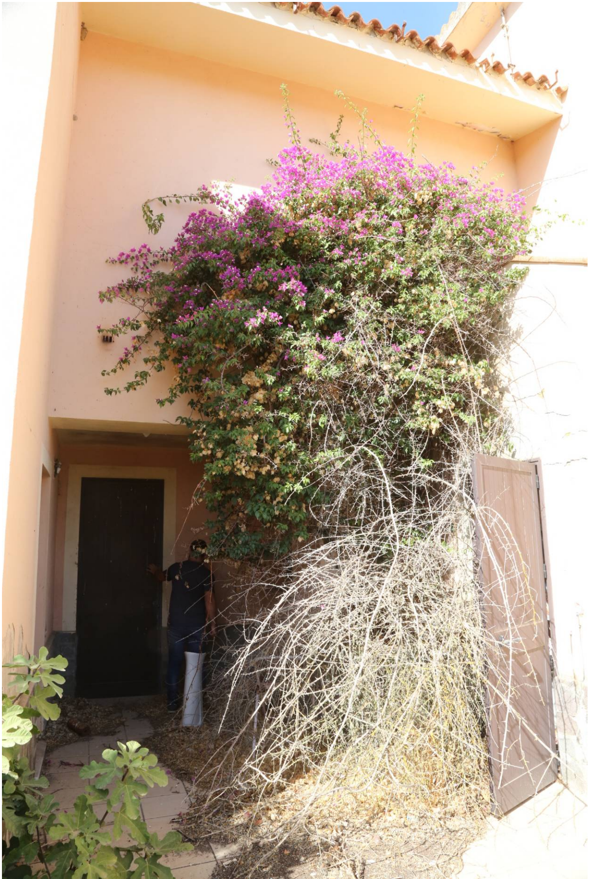
27 – UFFICI – Ingresso posteriore (Fabbricato Particella 147 sub 1 piano terra)
