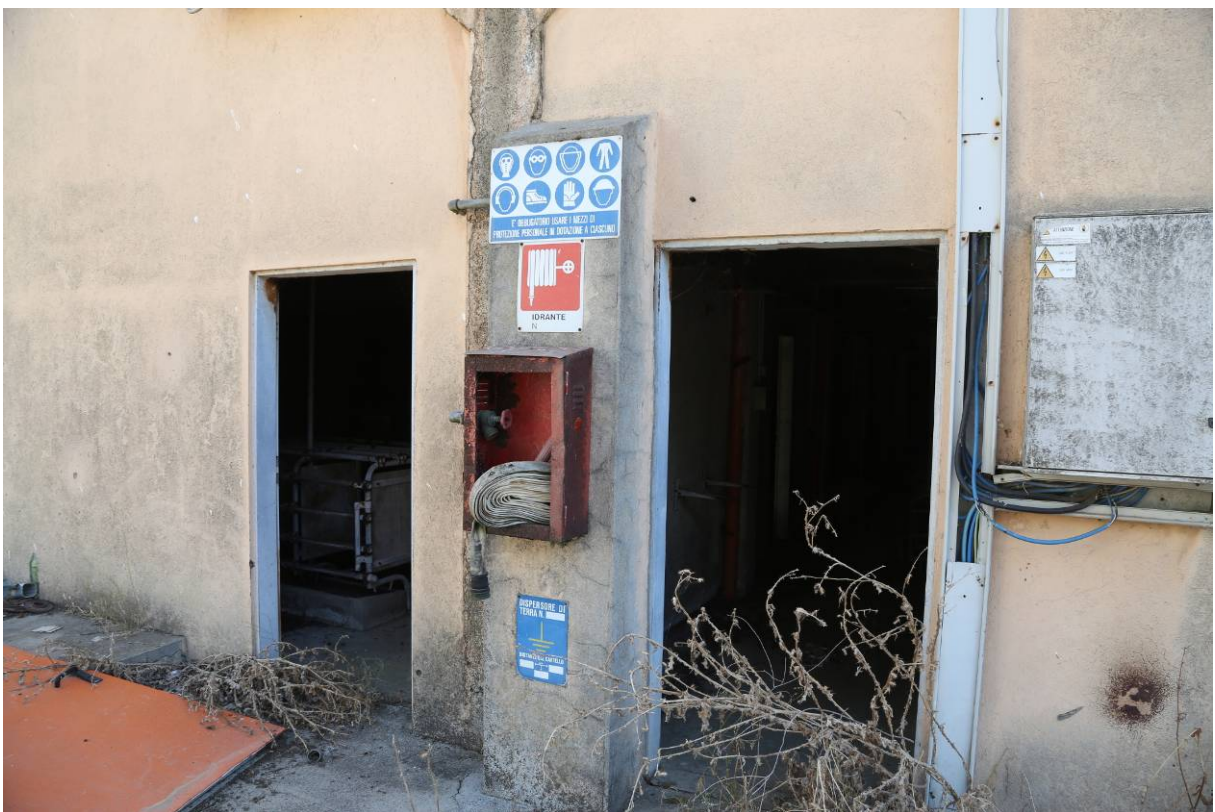
14 - BOX SCROFE (Fabbricato Particella 145)
