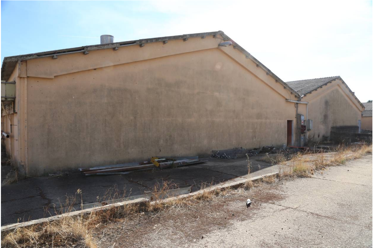
13 - BOX SCROFE (Fabbricato Particella 145)
