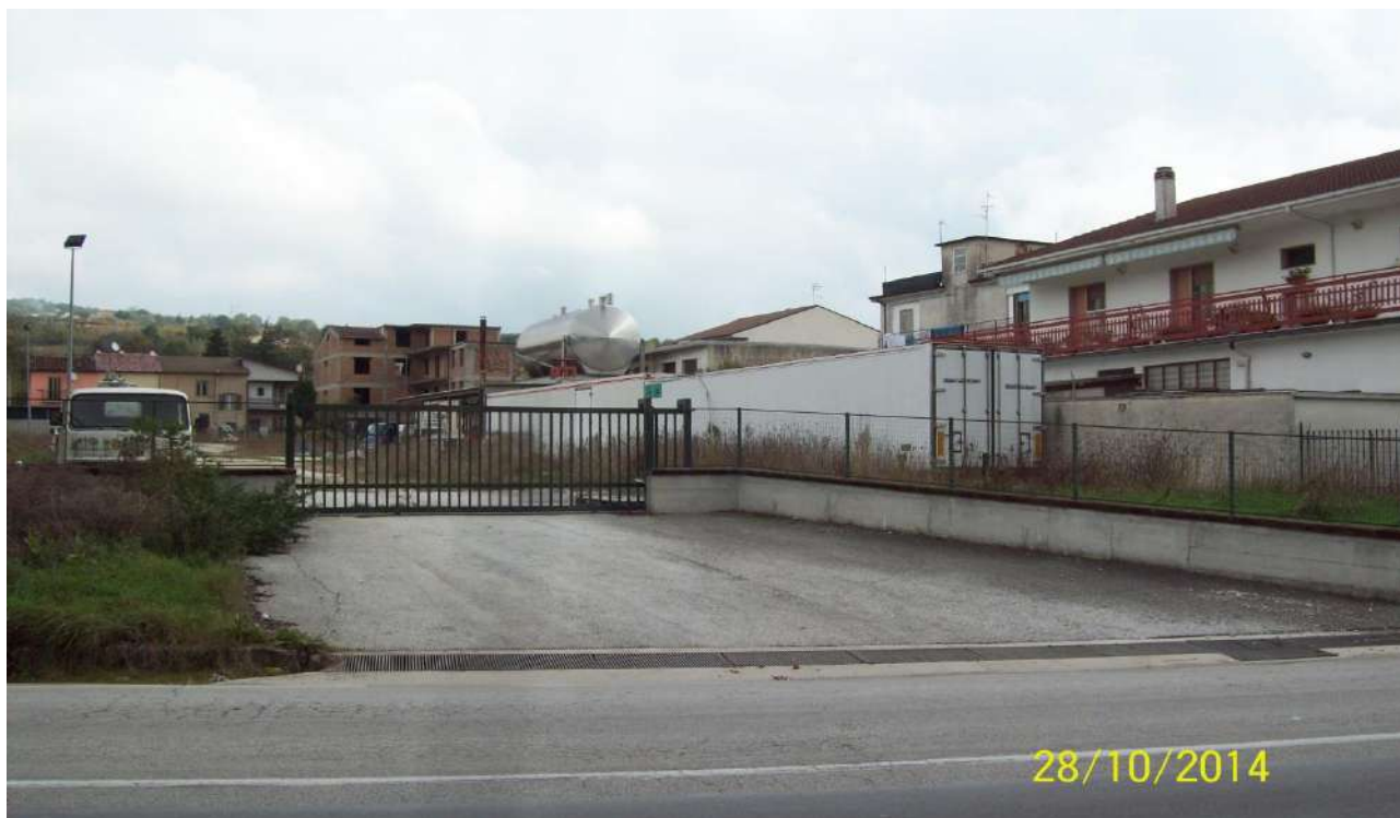
Accesso al caseificio con area pertinente ed autorimesse Lotto n.3
