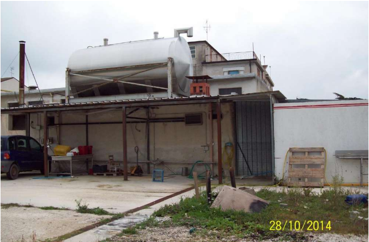
Vista esterna del caseificio con le autorimesse da accatastare area part.la 812 del F.28. Lotto n.3
