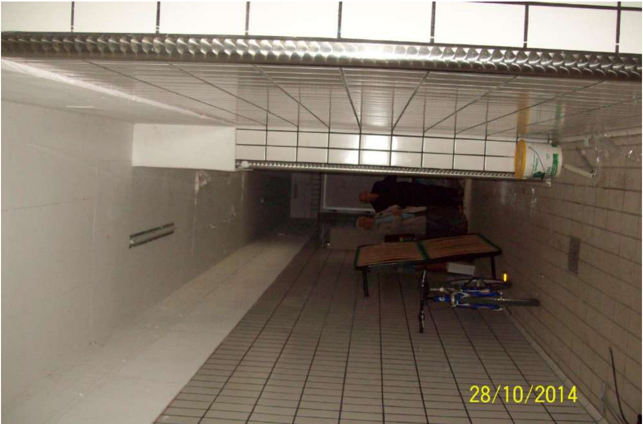
Corridoio caseificio piano terra Lotto n.3
