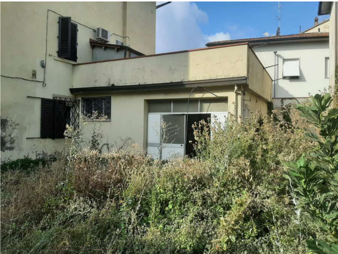
FACCIATA MAGAZZINO ESTERNO
