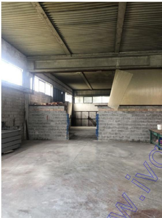
Fotografia A.27 - Corpo A - Capannone angolo sud-est - muratura con varco
