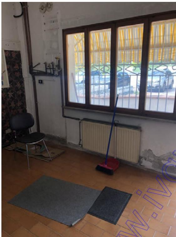
Fotografia A.45 - Corpo B - Particolare collegamenti caldaia murale rimossa - pranzo
