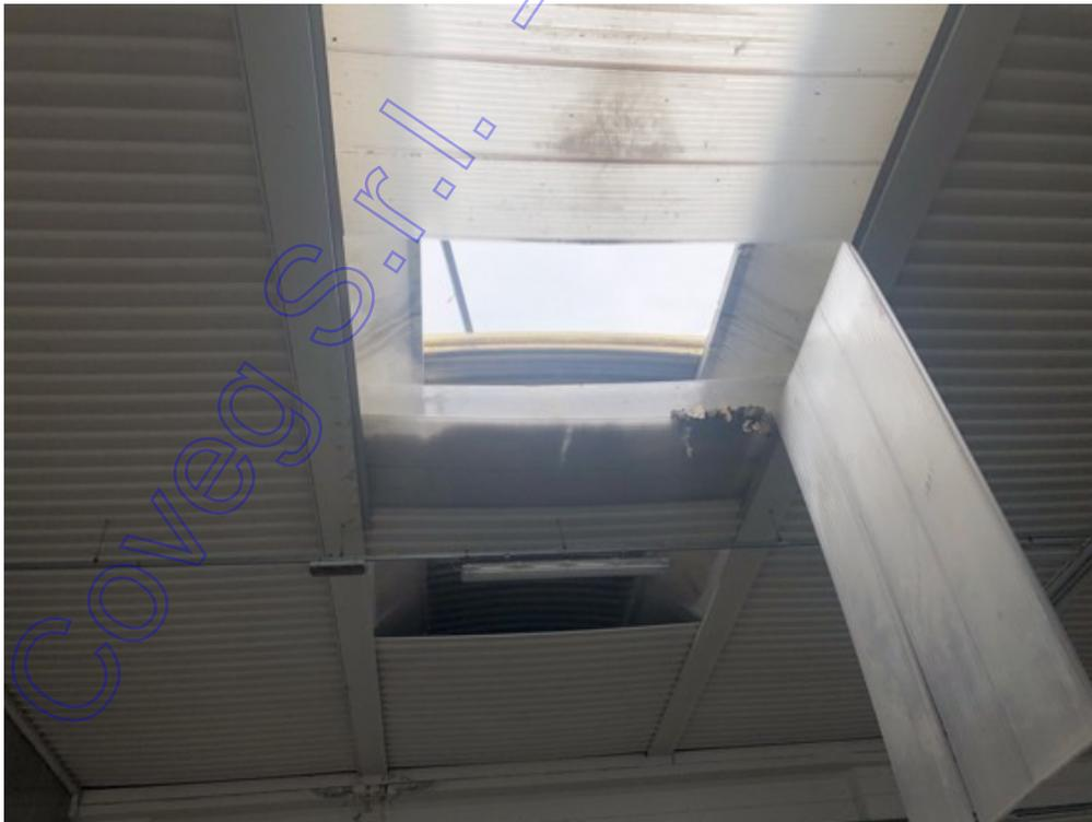
Fotografia A.30 - Corpo A - Capannone particolare danni copertura
