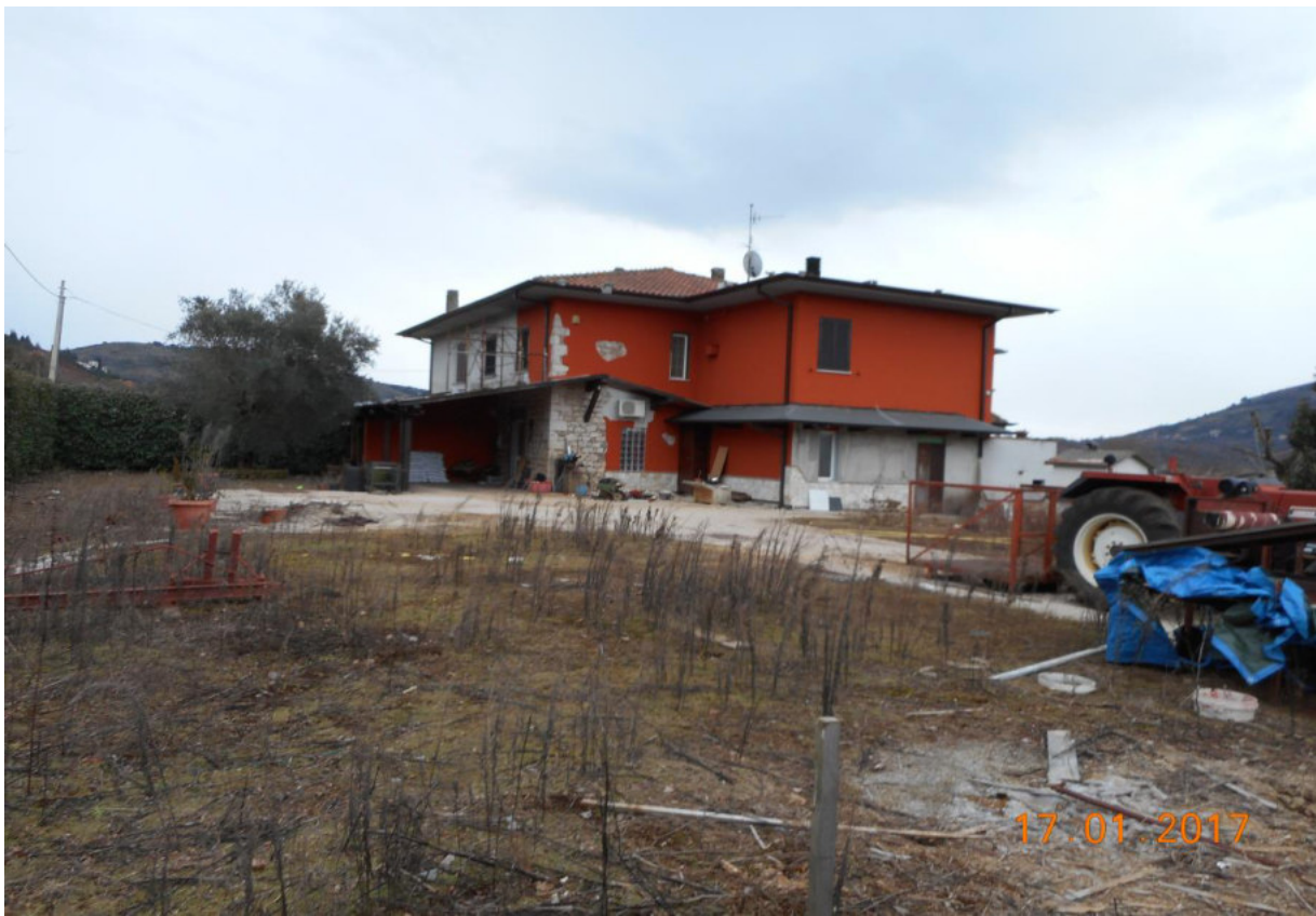
ABITAZIONE - VIA CARIZIA N. 36 – Foglio 14, Particella 951 e Corte
