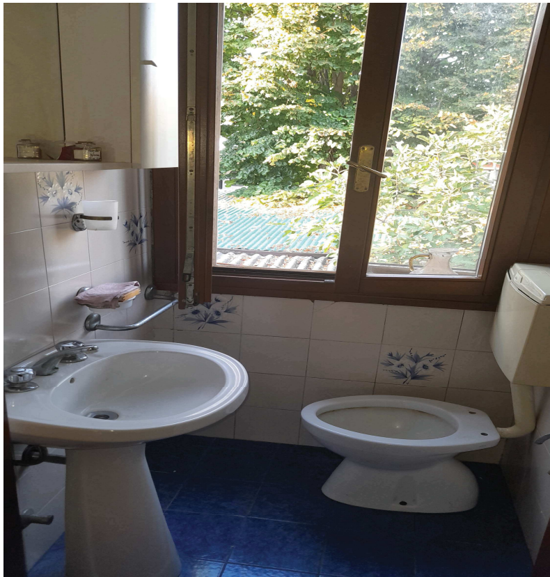
Foto 11 wc piano primo
