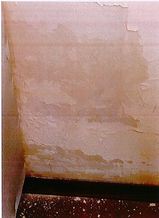
FOTO N.5 - CUCINA APPARTAMENTO AL PIANO SECONDO (ARGENTERA sez. BER F.5 N.229 SUB.9)
