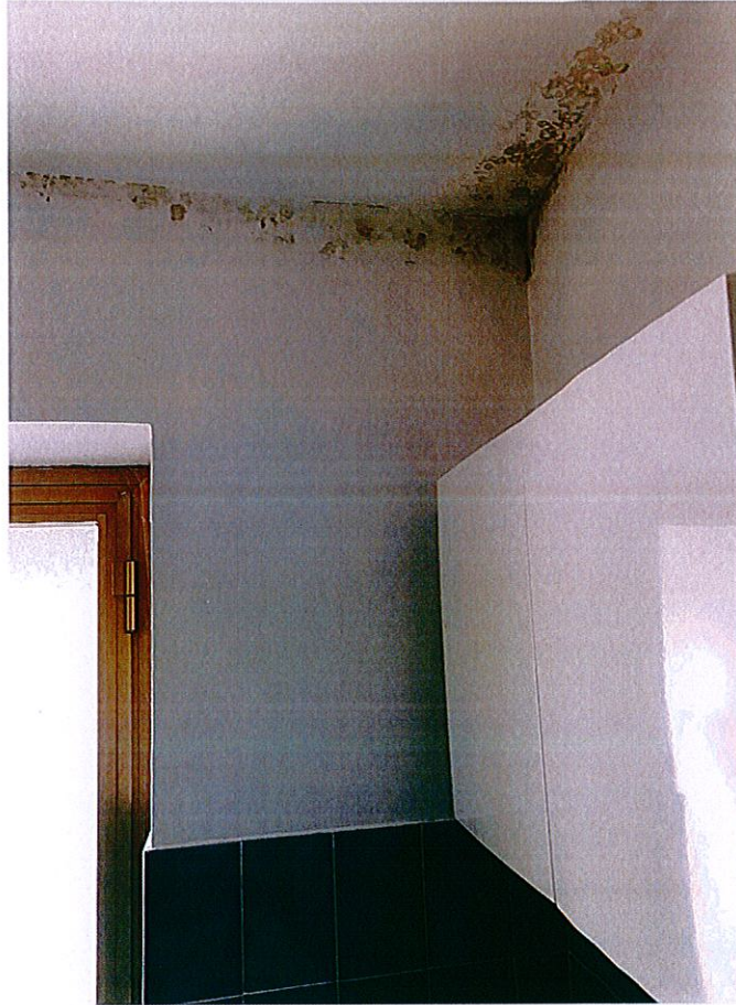
FOTO N.7 - BAGNO APPARTAMENTO AL PIANO SECONDO (ARGENTERA sez. BER F.5 N.229 SUB.9)
