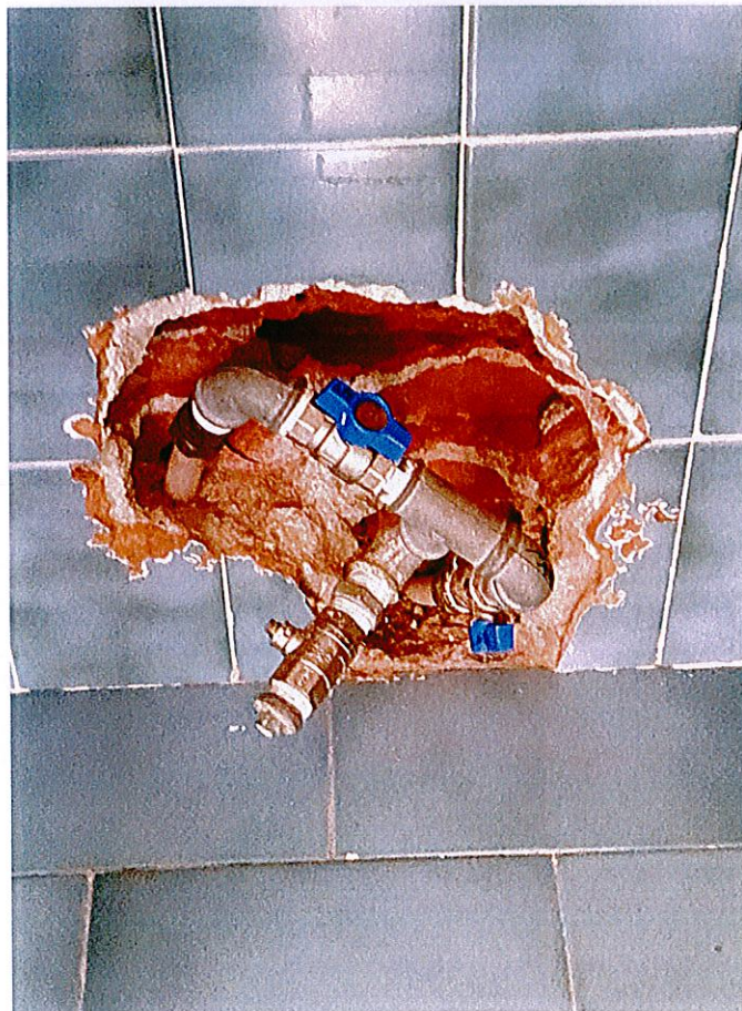
FOTO N.8 - BAGNO APPARTAMENTO AL PIANO SECONDO (ARGENTERA sez. BER F.5 N.229 SUB.9)
