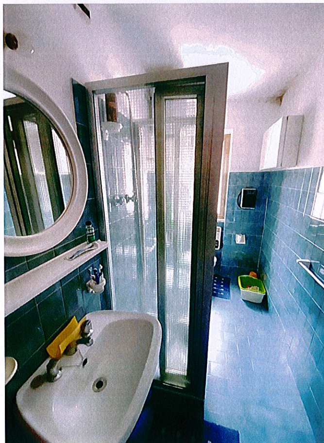
FOTO N.6 - BAGNO APPARTAMENTO AL PIANO SECONDO (ARGENTERA sez. BER F.5 N.229 SUB.9)
