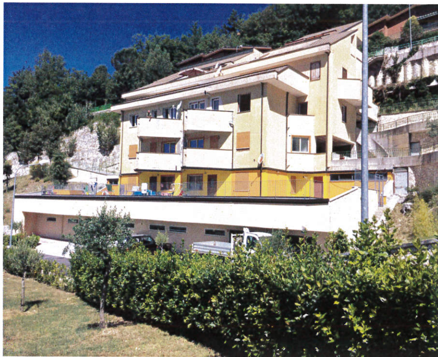
FOTO N. 01- Vista dell'edificio sito in Comune di Ascrea con vista sul lago del Turano, individuato al foglio n. 7 part 280
