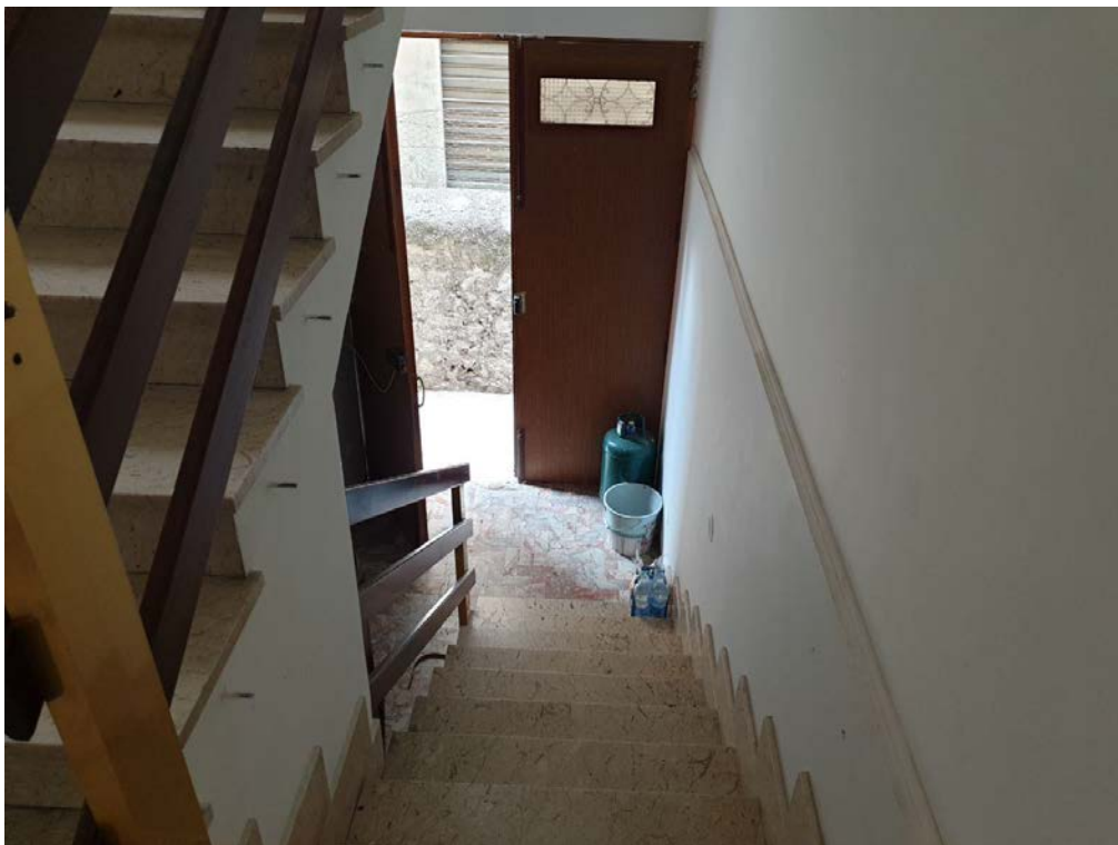
FOTO N. 7 – SCALA AL PIANO PRIMO – VISTA OPPOSTA
