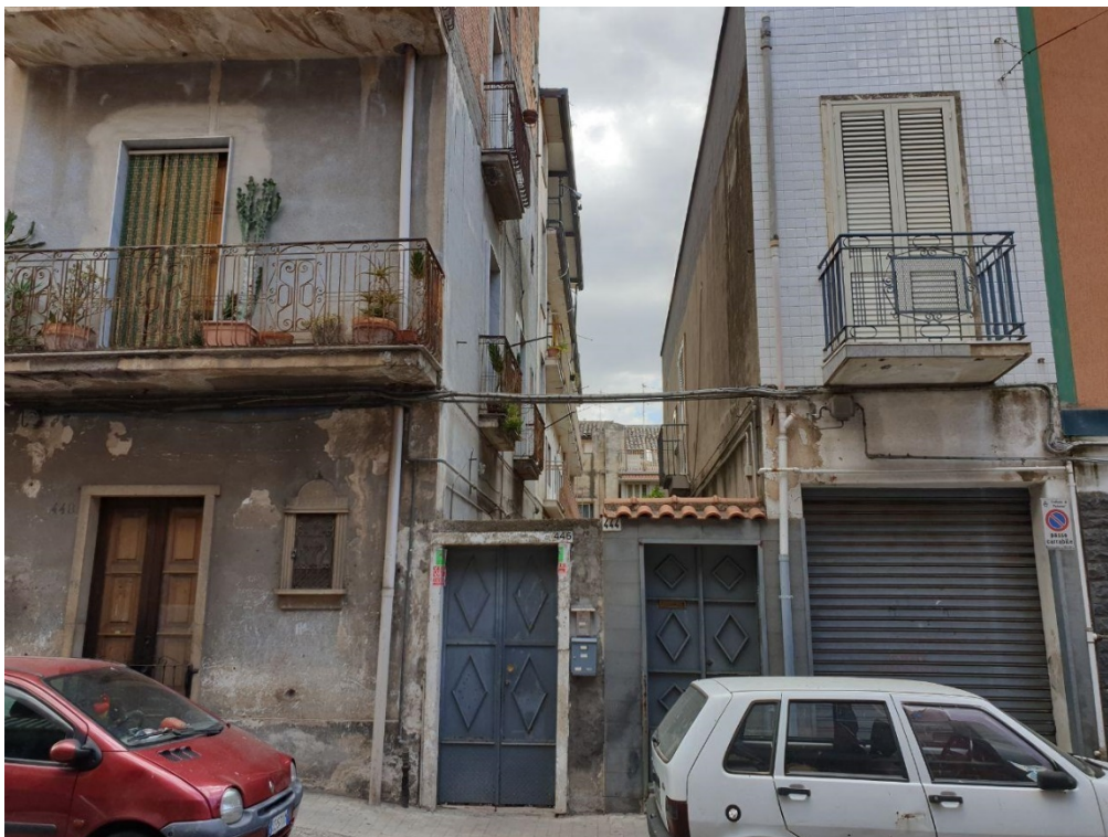
FOTO N. 3 – ACCESSO IMMOBILE IN VIA CIRCUMVALLAZIONE N. 446
