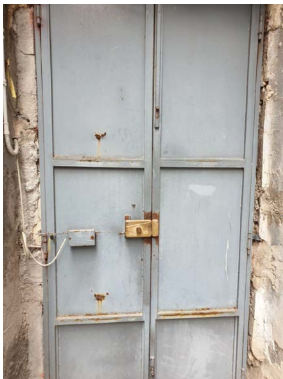
FOTO N. 3 – INTERNO PORTONE CONDOMINIALE
