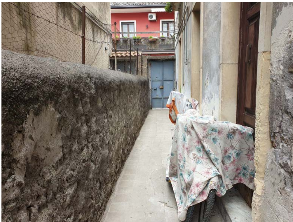
FOTO N. 3 – CORTILE INGRESSO CONDOMINIALE
