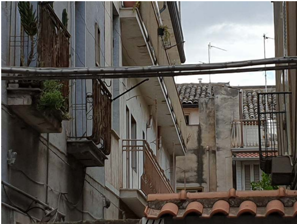
FOTO N. 33 – PROSPETTO LATO OVEST PRIMO PIANO - VISTA DA STRADA
