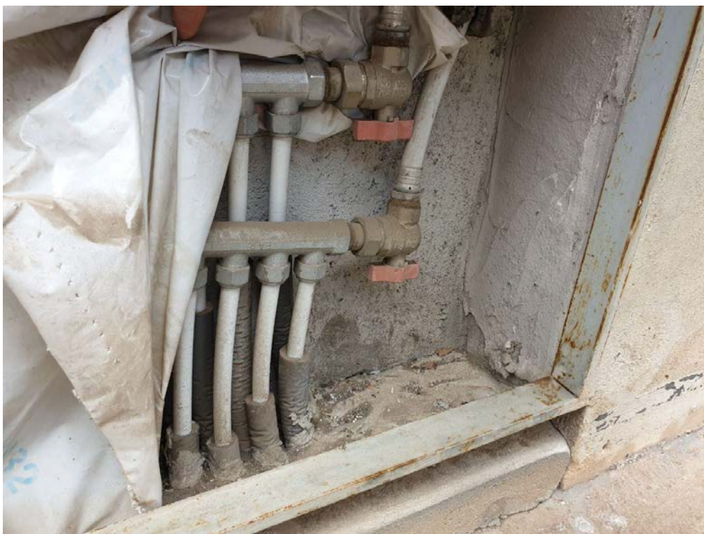
FOTO N. 30 – RIPARTITORE IDRICO A COLLETTORI SINGOLI - BALCONE
