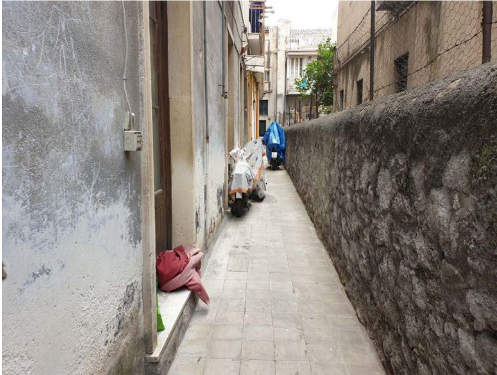
FOTO N. 4 – CORTILE INGRESSO CONDOMINIALE LATO OPPOSTO
