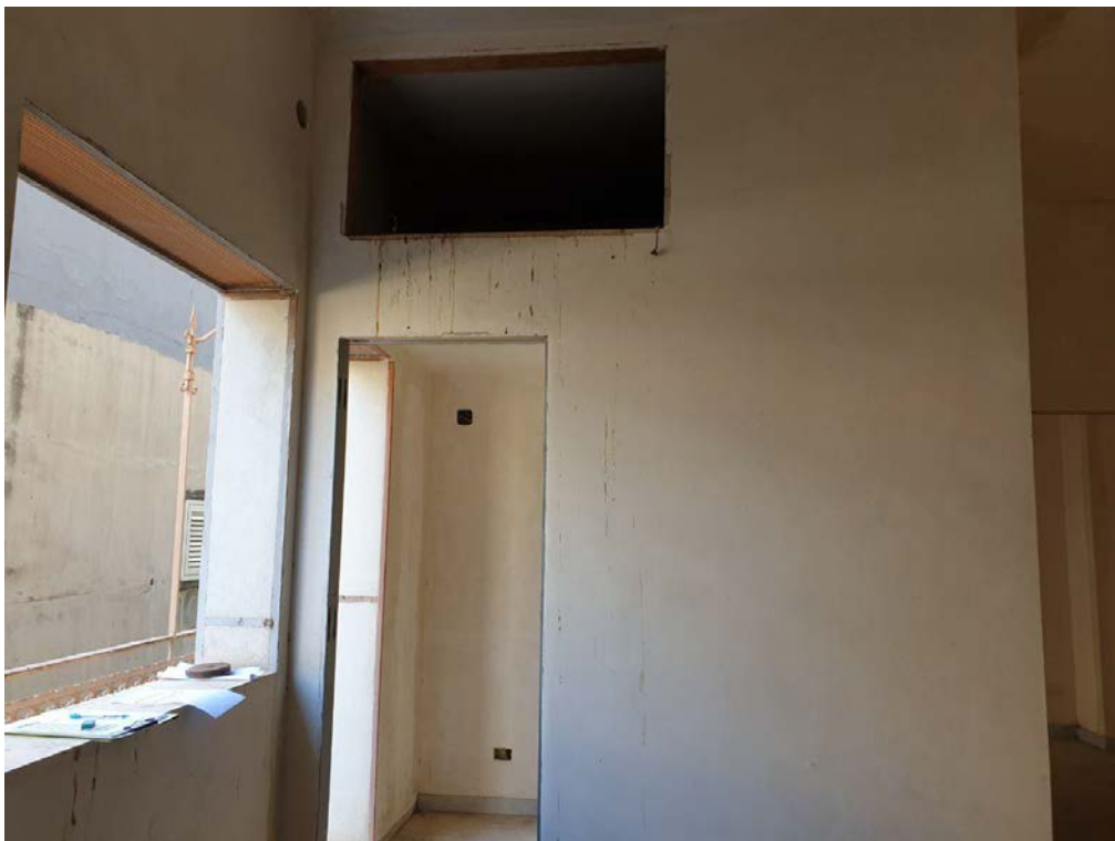
FOTO N. 15 – DAL SOGGIORNO - TINELLO CON RIPOSTIGLIO SOPRASTANTE
