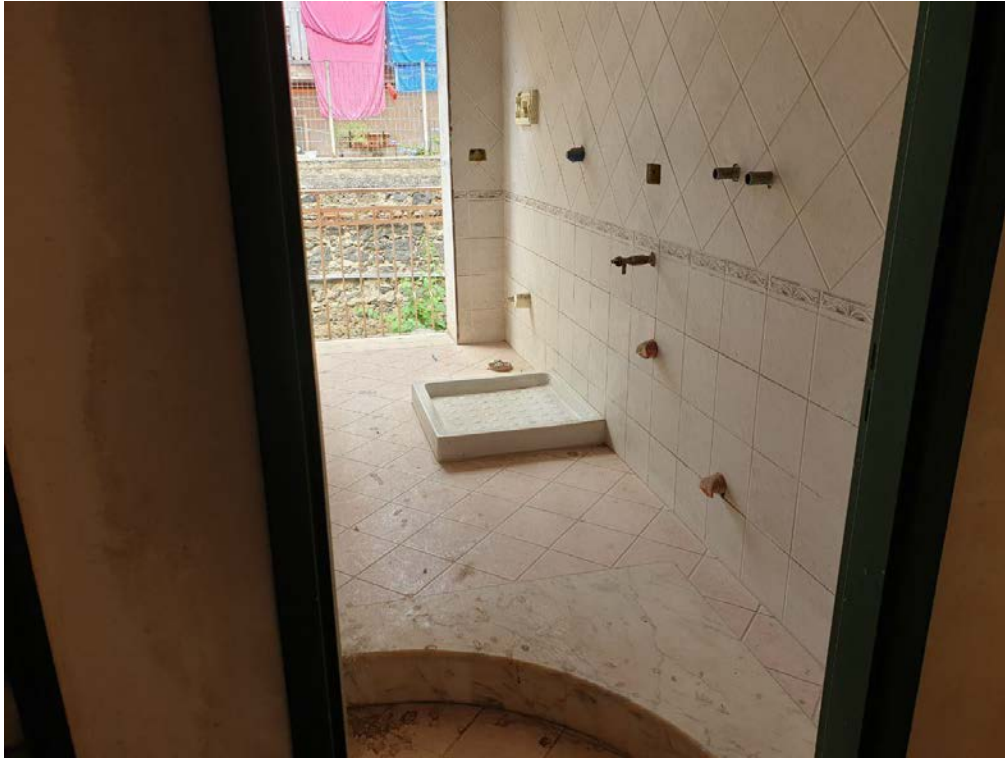
FOTO N. 20 – LAVANDERIA CON BOX DOCCIA E SANITARI DA INSERIRE
