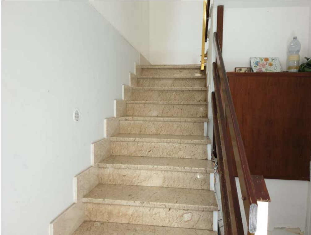
FOTO N. 6 – SCALA AL PIANO PRIMO
