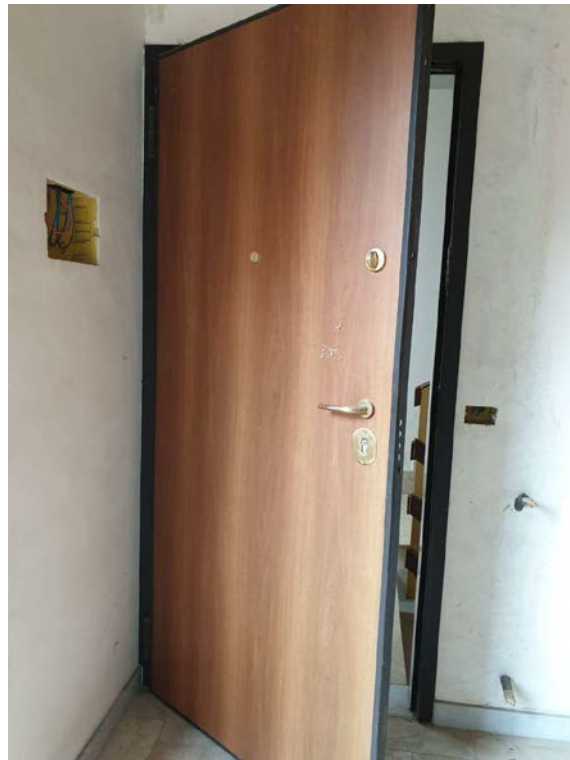
FOTO N. 9 – PORTA BLINDATA D'ACCESSO ALL'IMMOBILE
