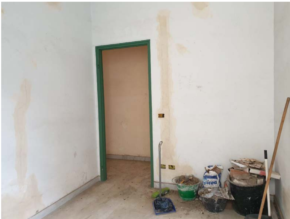
FOTO N. 25 – CAMERETTA 2 – VISTA OPPOSTA
