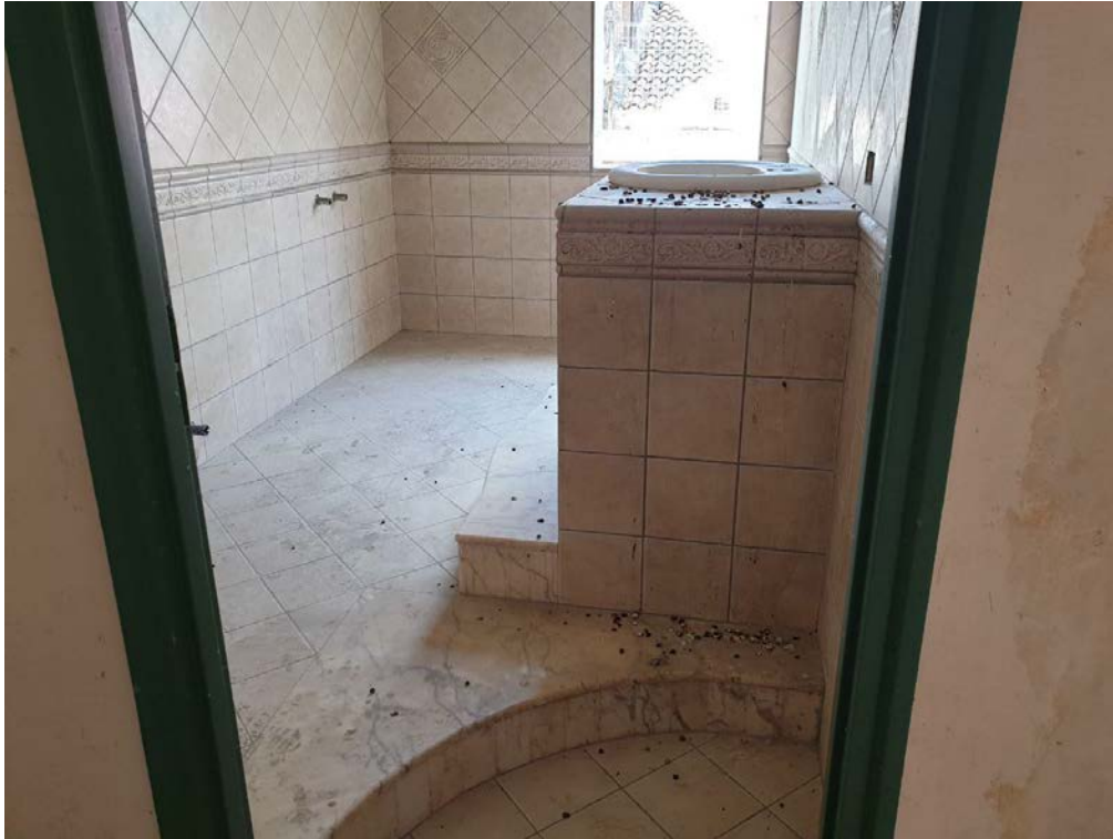
FOTO N. 22 – BAGNO CON LAVABO- DA INSERIRE SANITARI E VASCA
