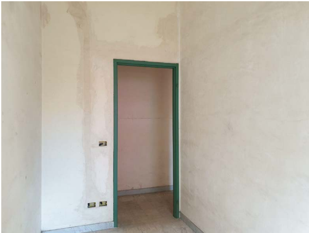
FOTO N. 19 - CAMERETTA 1 - VISTA OPPOSTA
