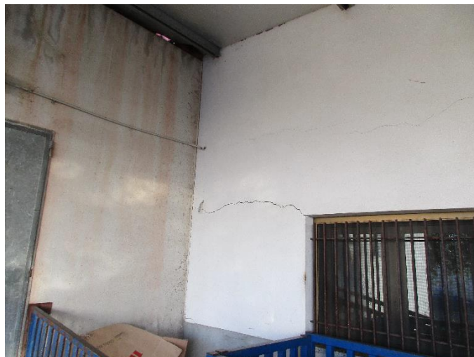
Foto n.11 – Locale ufficio – Parte alta parete ovest – Lato esterno
