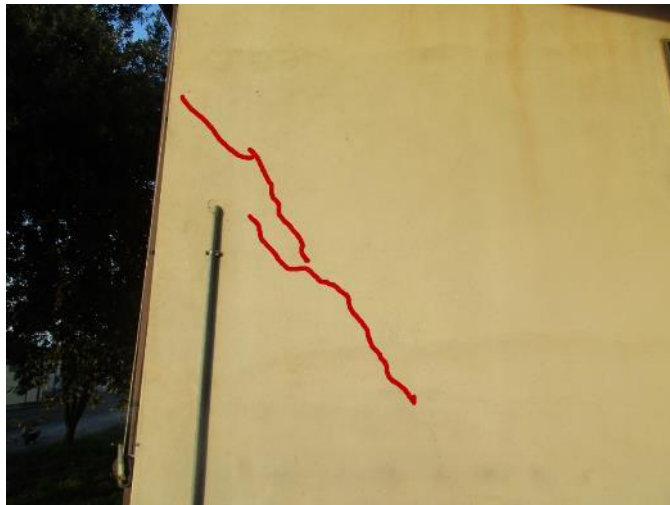
Foto n.1 – Stalla - Parete esterna – Lato sud
