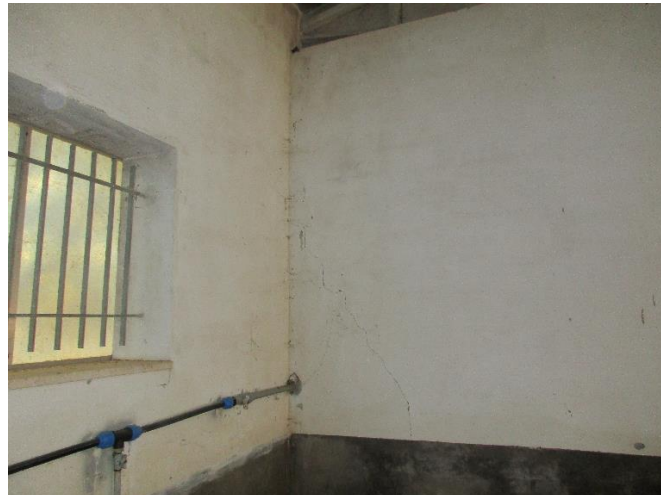
Foto n.13 – Stalla – Box 7 – Parete nord – Lato interno
