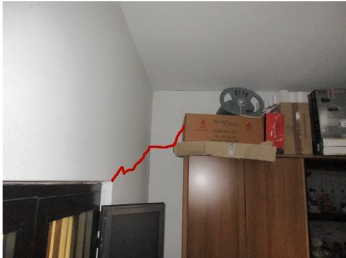
Foto n.3 – Locale ufficio - Pareti ovest e nord – Lato interno
