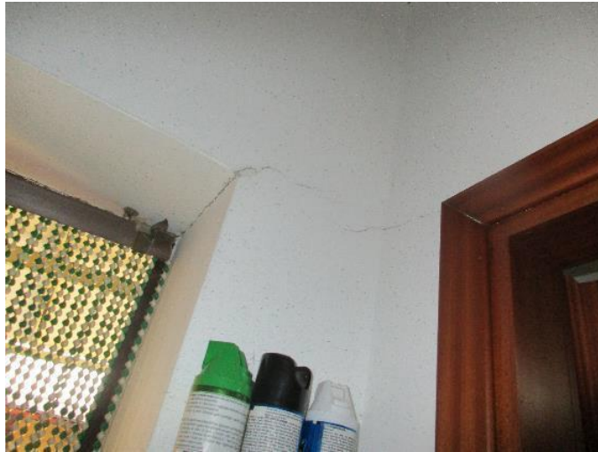
Foto n.9 – Disimpegno – Parte alta parete ovest – Lato interno
