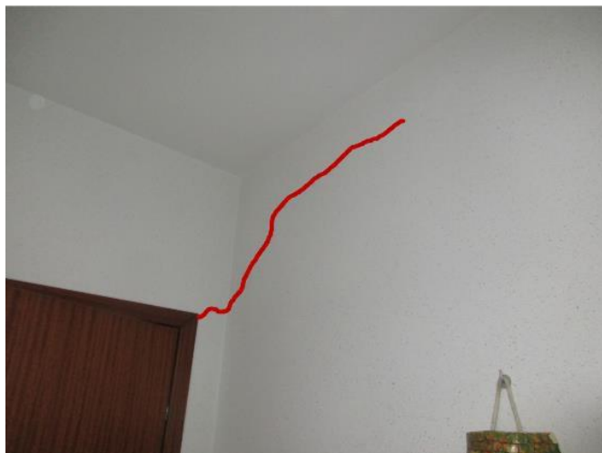
Foto n.8 – Locale ufficio – Parte alta parete ovest – Lato interno
