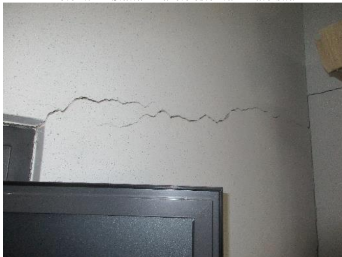
Foto n.2 – Locale ufficio - Parete ovest – Lato interno
