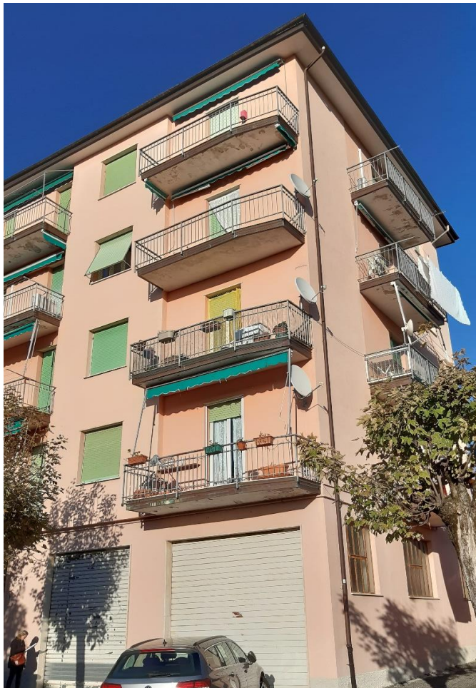
Angolo del fabbricato su cui insiste l'alloggio oggetto di esecuzione al P1
