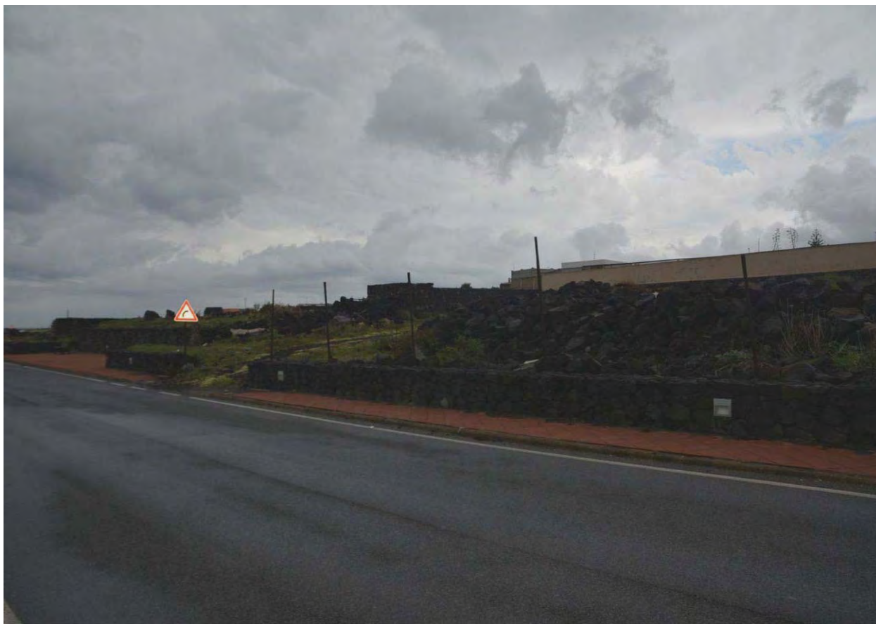
FOTO 09 - VISTA ESTERNA DA VIA S.P. N. 54 AREA SCOPERTA
