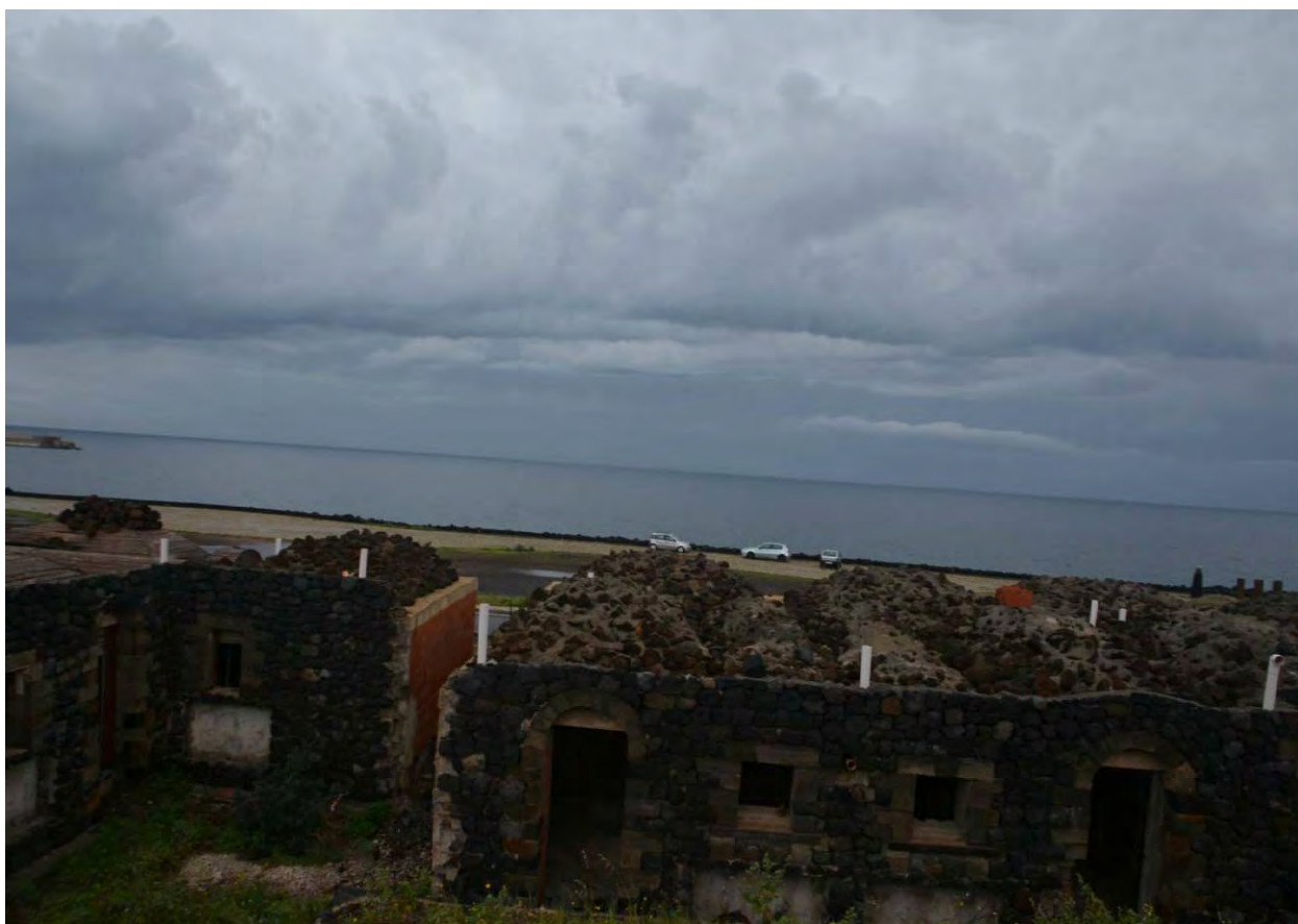
FOTO 18 - UNITA' ABITATIVE LATO MARE - CORPO C
