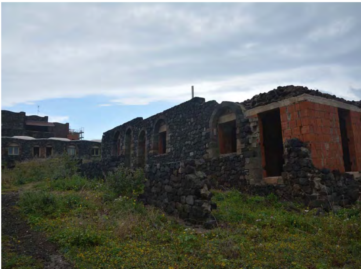
FOTO 34 - UNITA' ABITATIVE CORPO A - LATO STRADA
