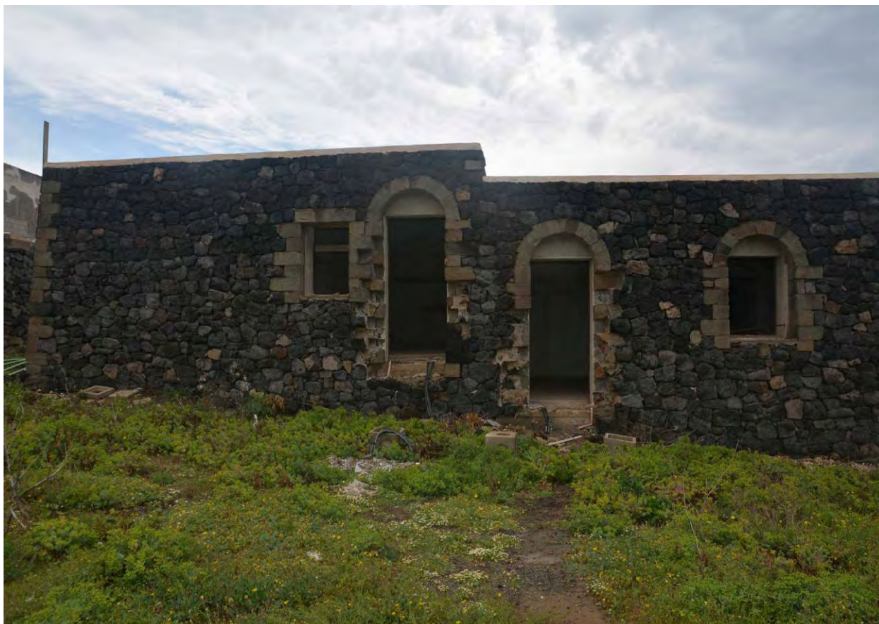
FOTO 22 - UNITA' ABITATIVE LATO MARE - CORPO C
