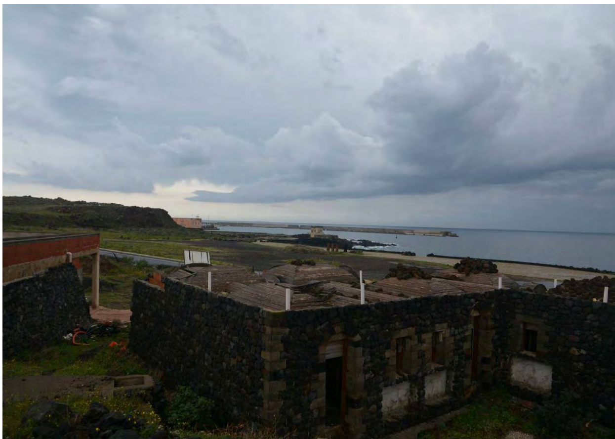
FOTO 17 - UNITA' ABITATIVE LATO MARE - CORPO C
