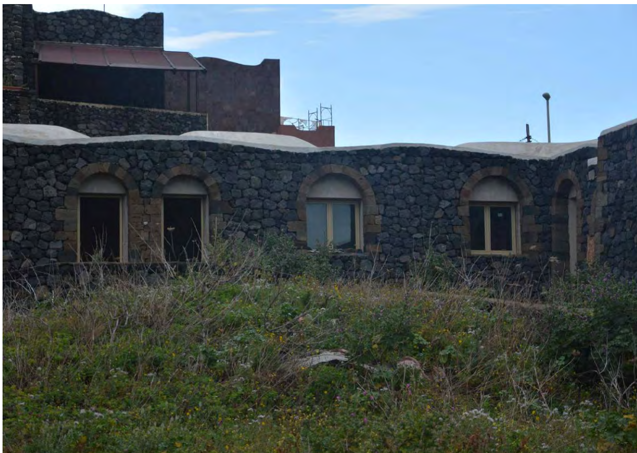
FOTO 29 - UNITA' ABITATIVE LATO SUPERIORE- CORPO A
