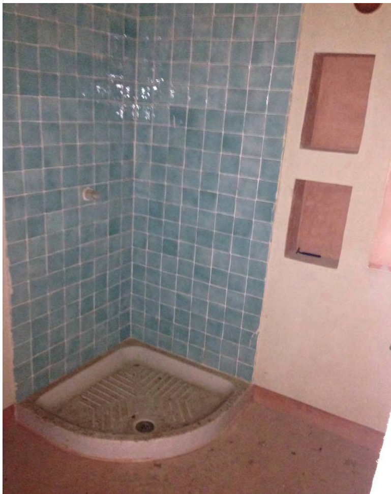
FOTO 37 - UNITA' ABITATIVE CORPO B - INTERNI (BAGNO 1)
