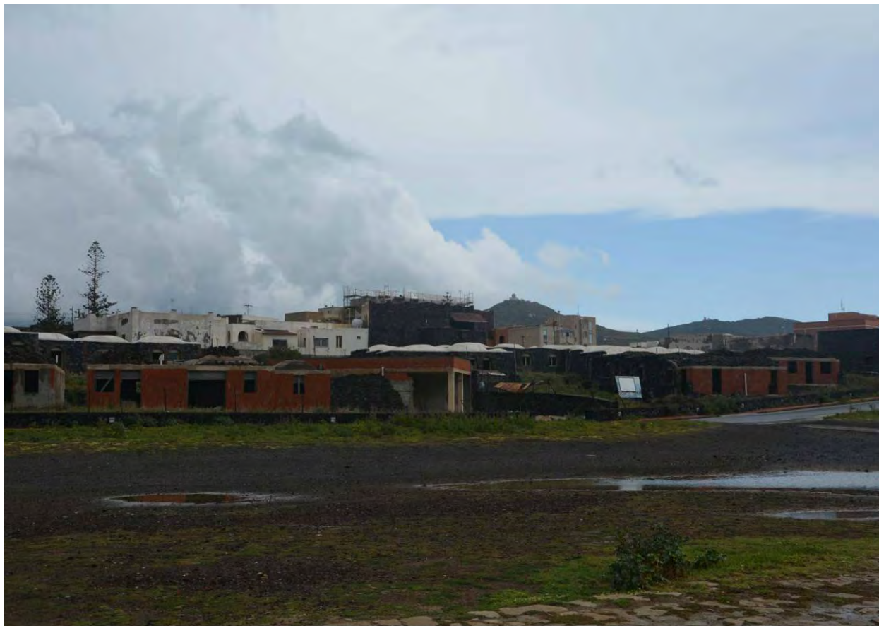
FOTO 03 - VISTA D'INSIEME DA VIA S.P. N. 54
