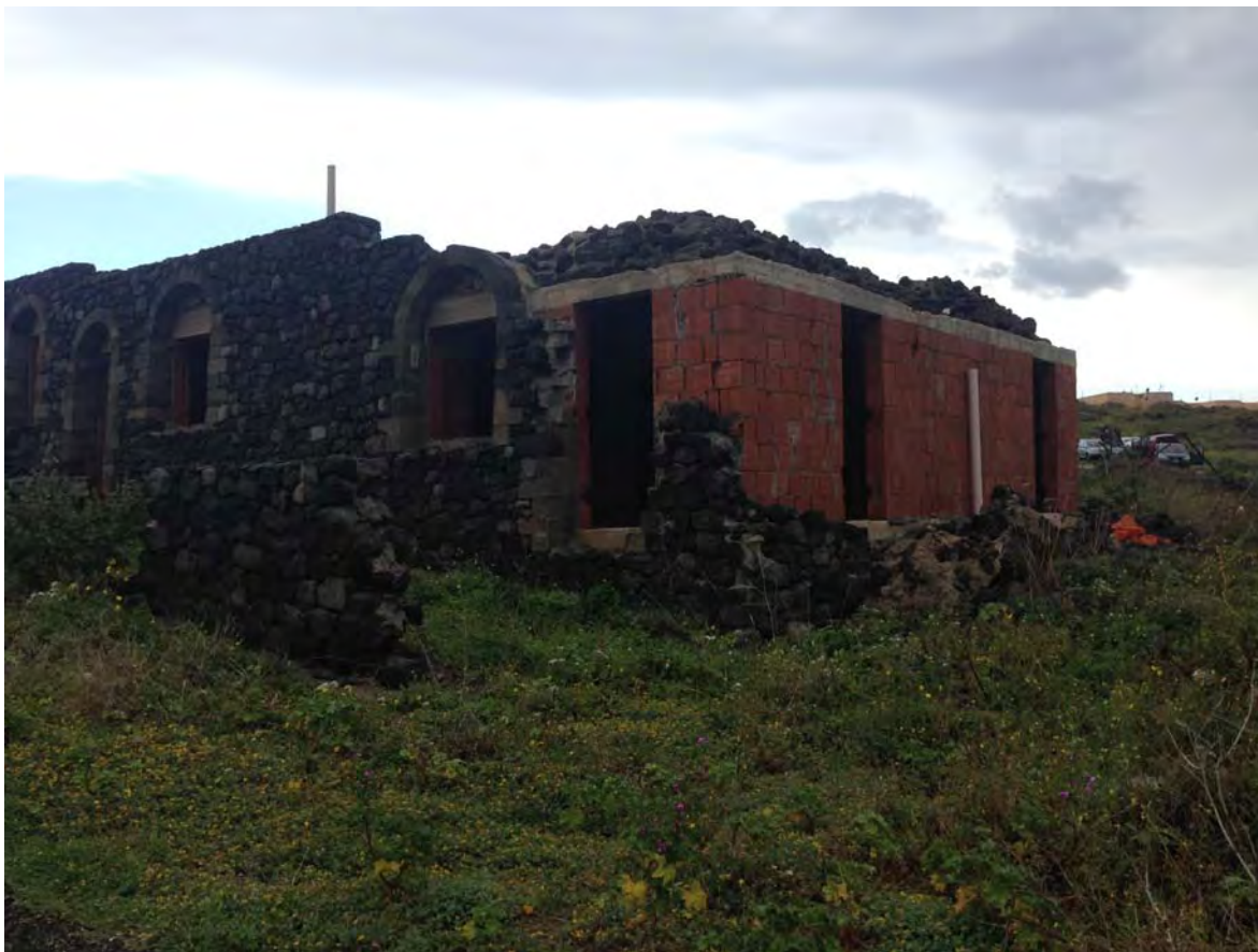
FOTO 33 - UNITA' ABITATIVE CORPO A - LATO STRADA
