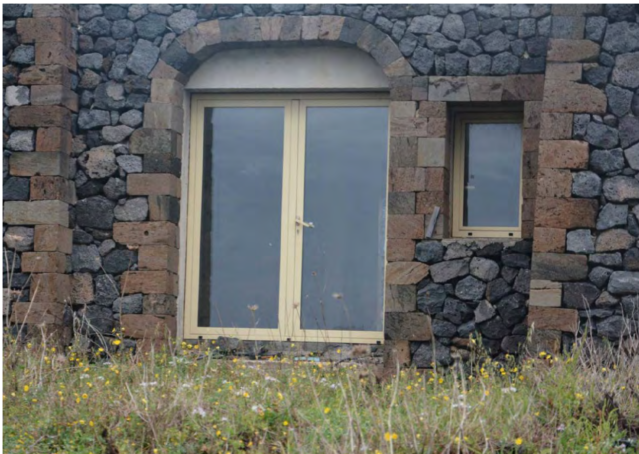
FOTO 32 - UNITA' ABITATIVE LATO SUPERIORE- CORPO A
