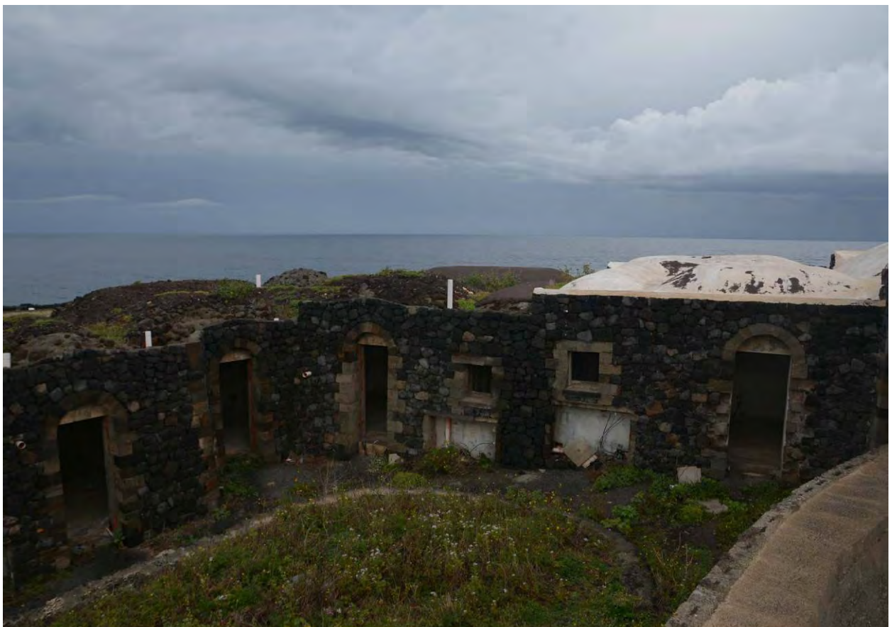
FOTO 20 - UNITA' ABITATIVE LATO MARE - CORPO C
