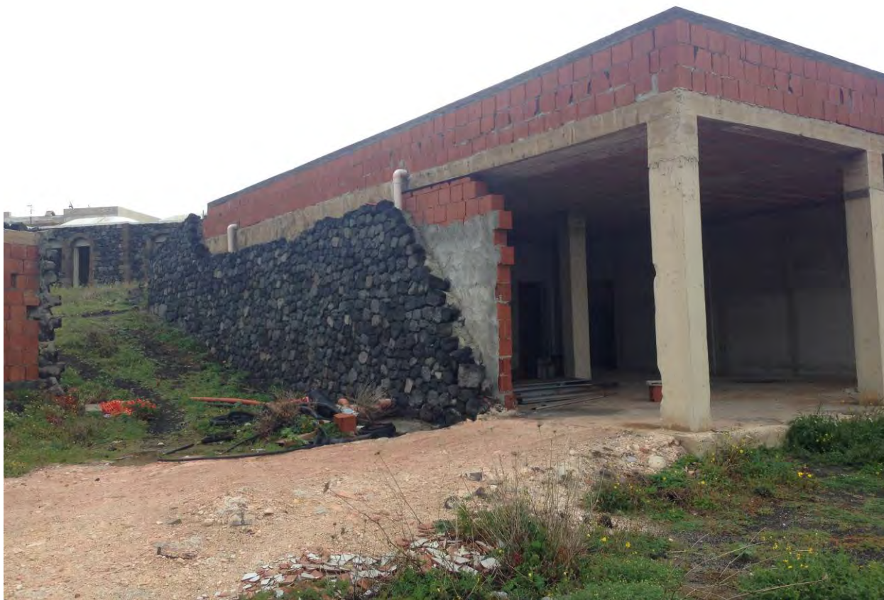
FOTO 14 - CENTRO SERVIZI - CORPO D
