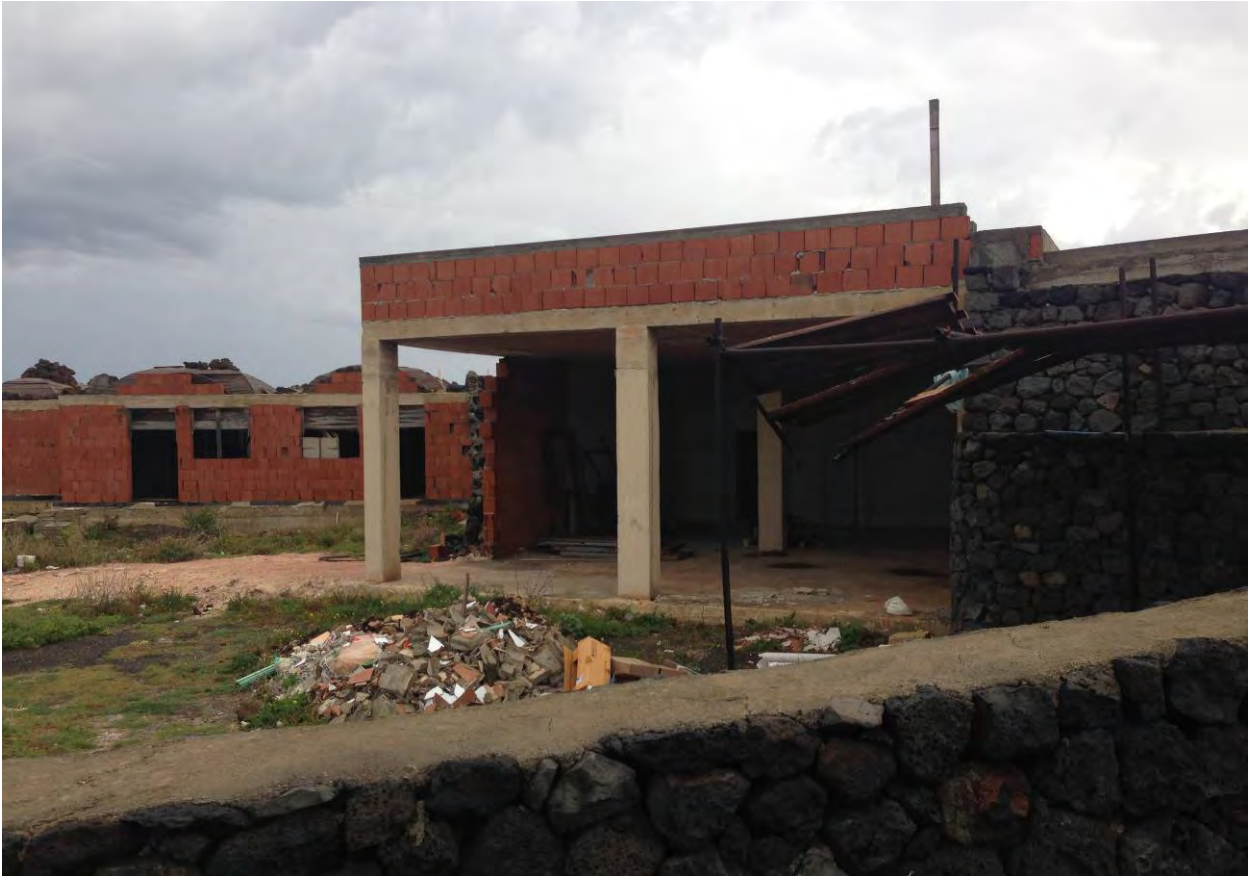
FOTO 15 - CENTRO SERVIZI- CORPO D
