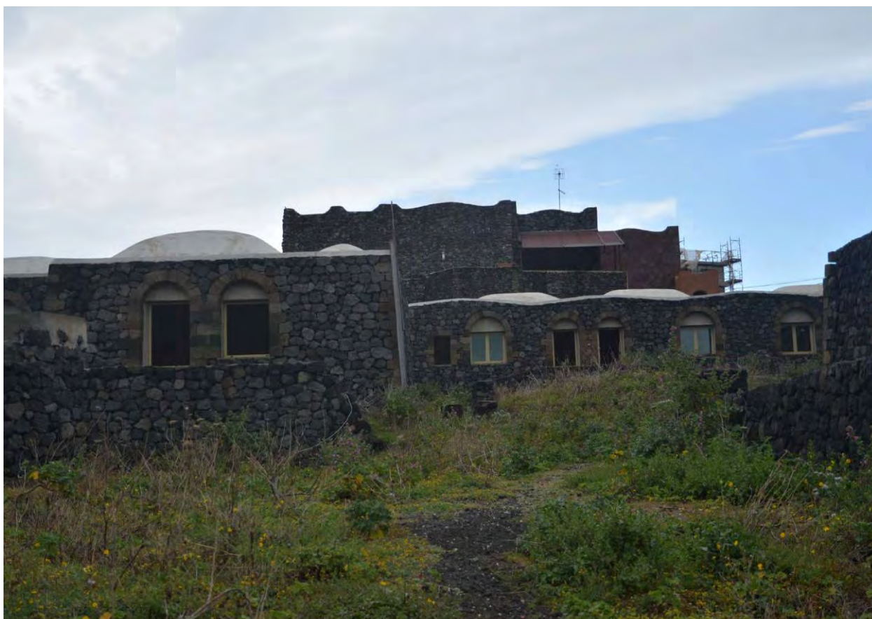
FOTO 28 - UNITA' ABITATIVE LATO SUPERIORE- CORPO A
