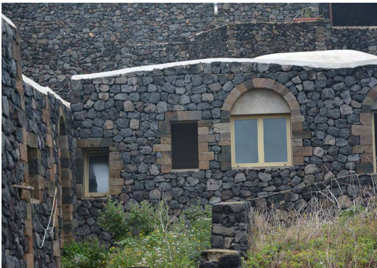
FOTO 30 - UNITA' ABITATIVE LATO SUPERIORE- CORPO A
