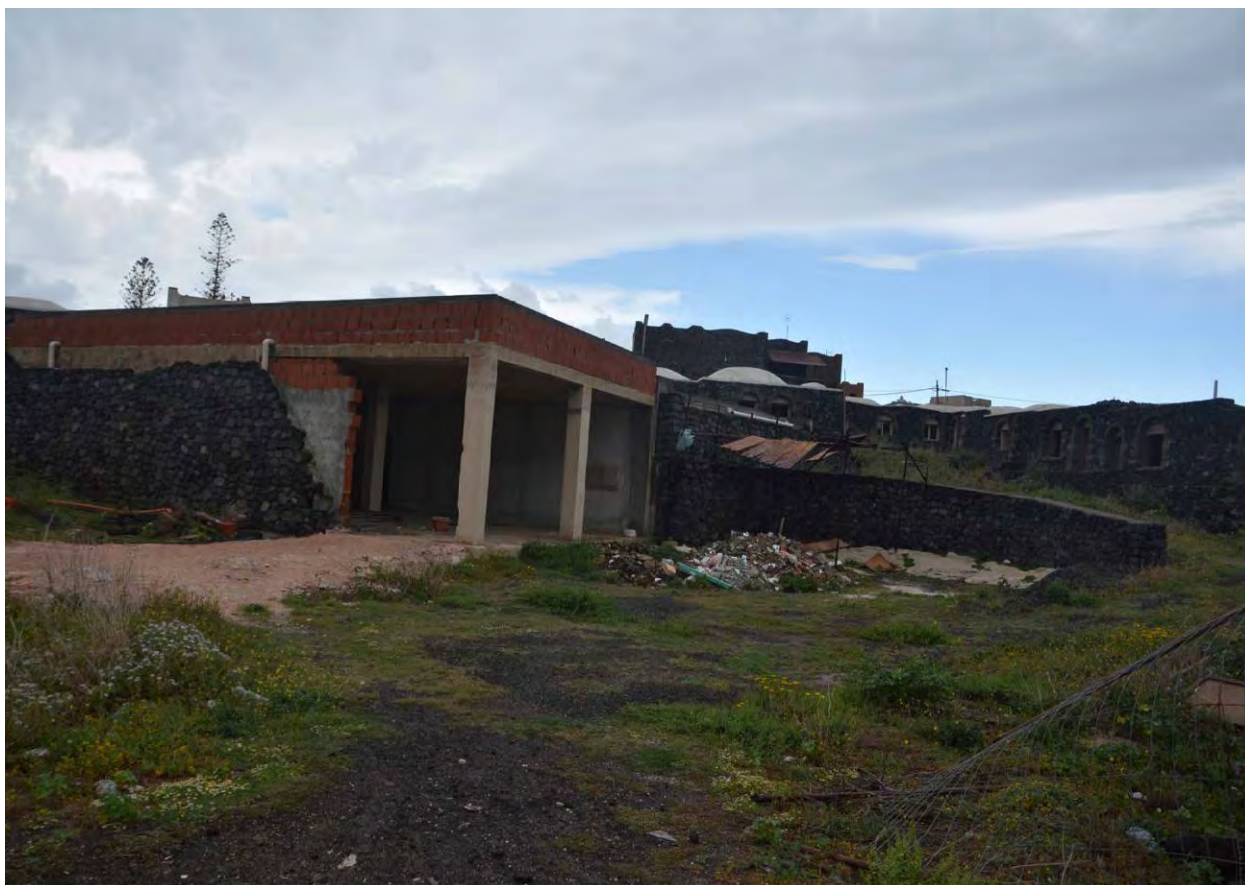
FOTO 13 - CENTRO SERVIZI - CORPO D
