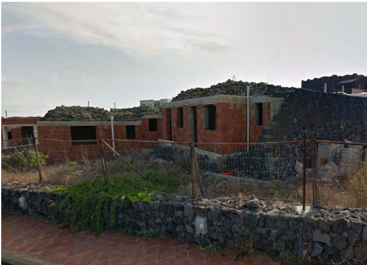
FOTO 35 - UNITA' ABITATIVE CORPO A - LATO STRADA
