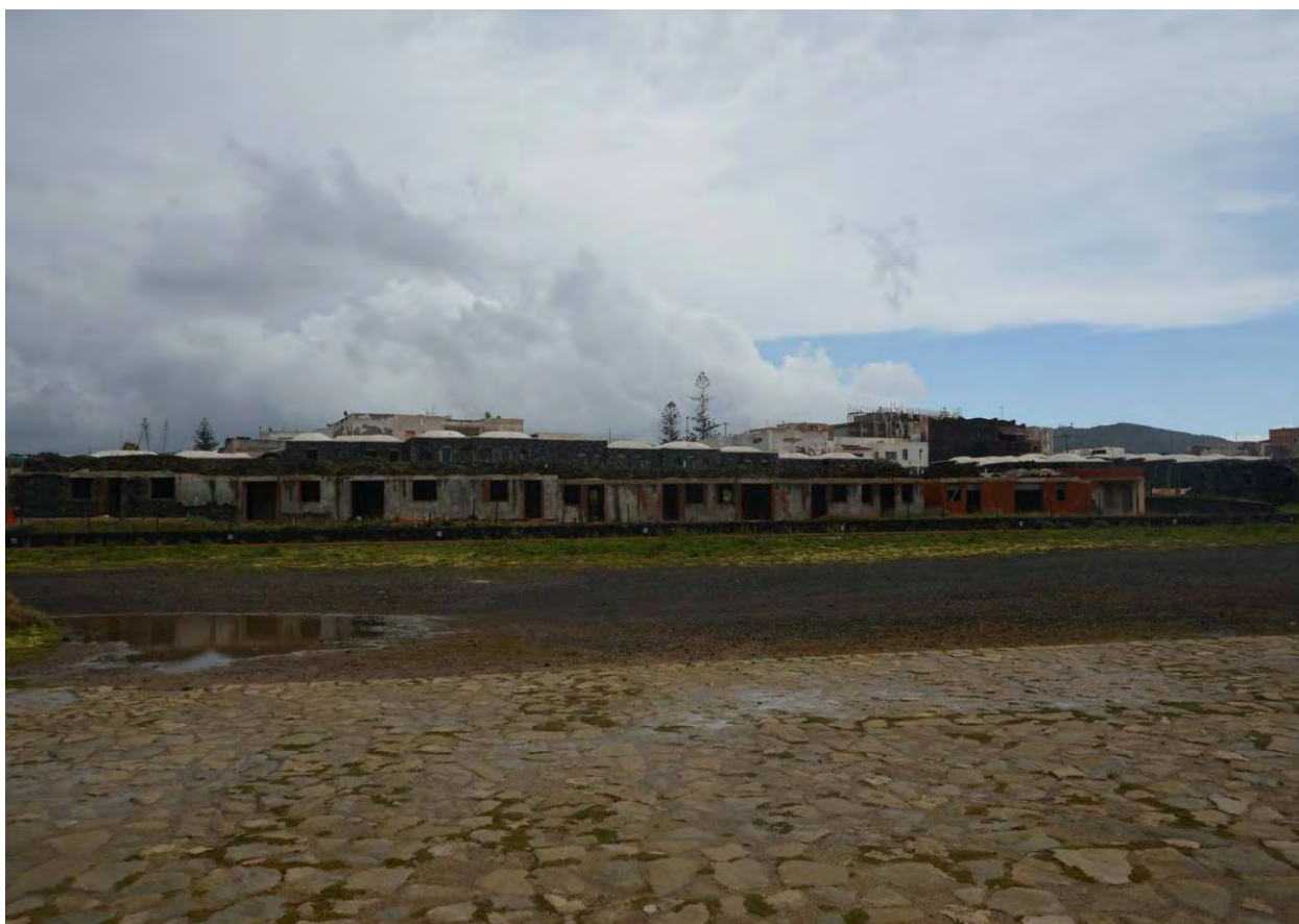
FOTO 02 - VISTA D'INSIEME DA VIA S.P. N. 54
