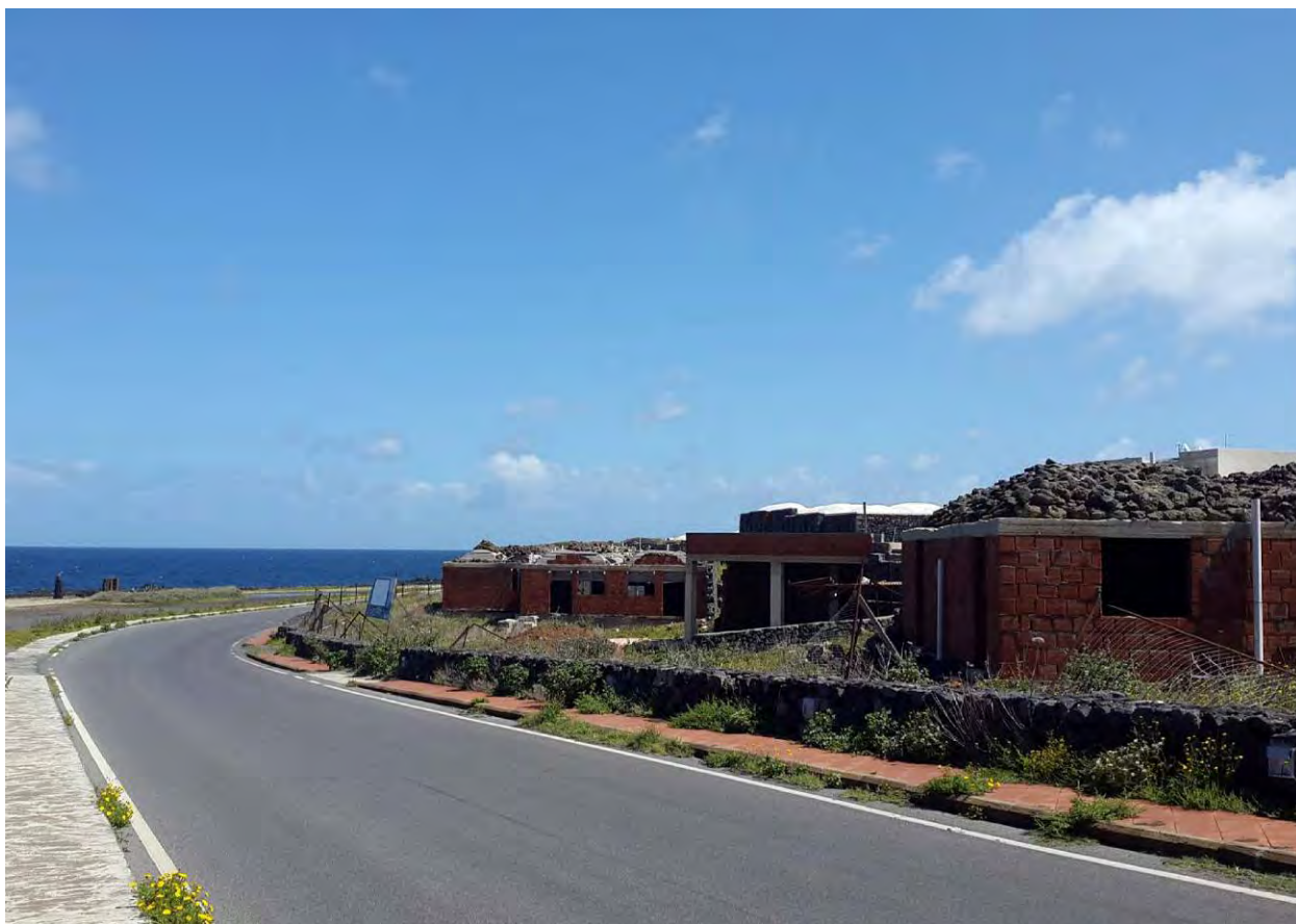
FOTO 01 - VISTA D'INSIEME DA VIA S.P. N. 54
