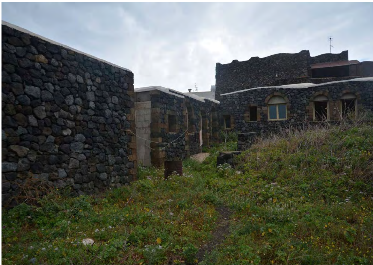
FOTO 31 - UNITA' ABITATIVE LATO SUPERIORE- CORPO A
