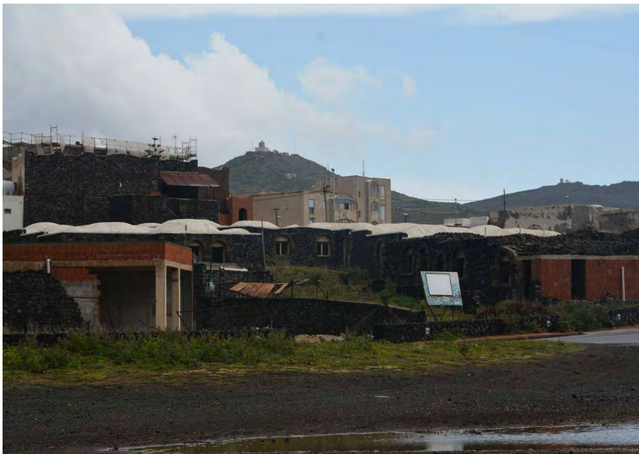
FOTO 04 - VISTA D'INSIEME DA VIA S.P. N. 54
