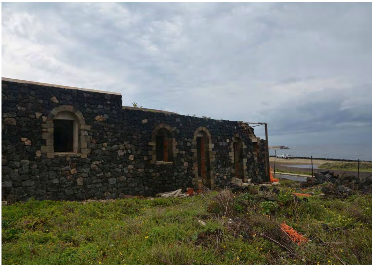
FOTO 21 - UNITA' ABITATIVE LATO MARE - CORPO C
