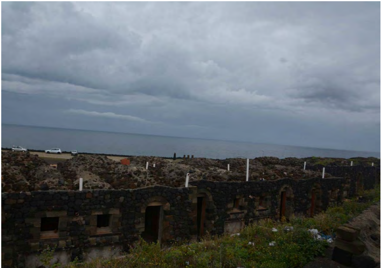
FOTO 19 - UNITA' ABITATIVE LATO MARE - CORPO C
