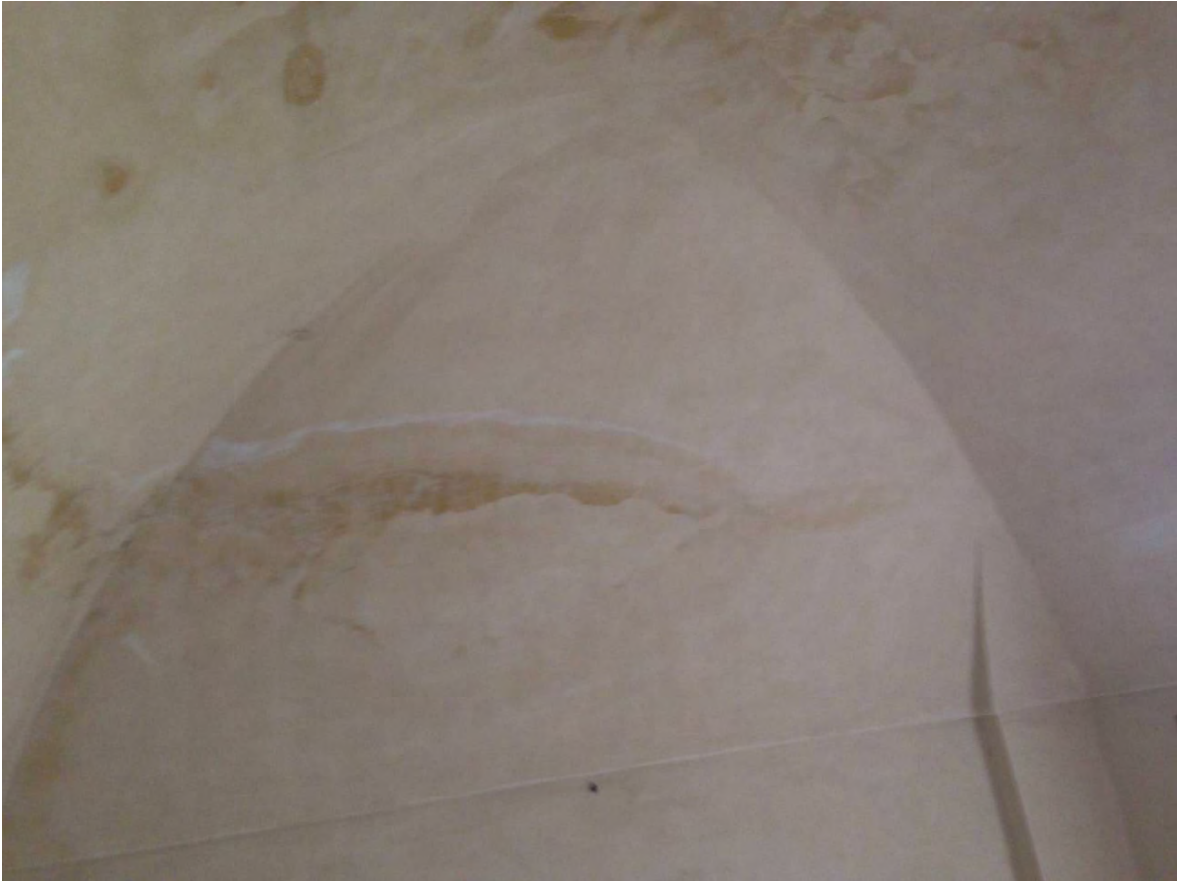
FOTO 41 - UNITA' ABITATIVE CORPO B - INTERNI (PARTICOLARE COPERTURA A VOLTA)
