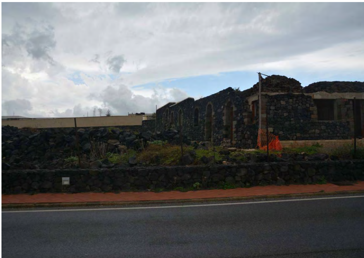
FOTO 08 - VISTA ESTERNA DA VIA S.P. N. 54 CORPO C
