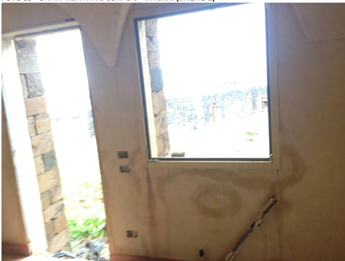
FOTO 40 - UNITA' ABITATIVE CORPO B - INTERNI (BAGNO 2)
