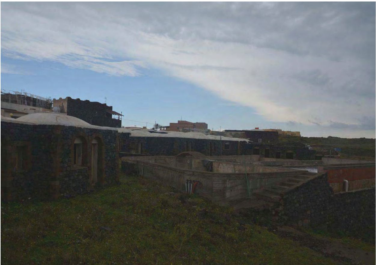
FOTO 16 - CENTRO SERVIZI- CORPO D
