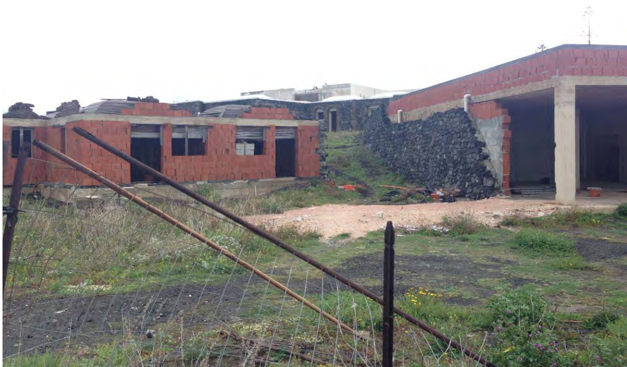
FOTO 12 - VISTA ESTERNA DA VIA S.P. N. 54 CORPO D - CORPO C
