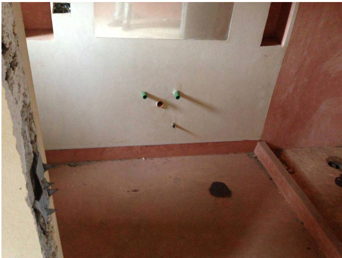
FOTO 39 - UNITA' ABITATIVE CORPO B - INTERNI (BAGNO 2)
