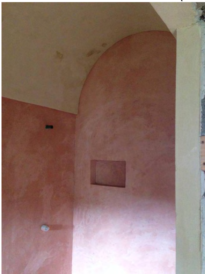
FOTO 38 - UNITA' ABITATIVE CORPO B - INTERNI (BAGNO 1)
