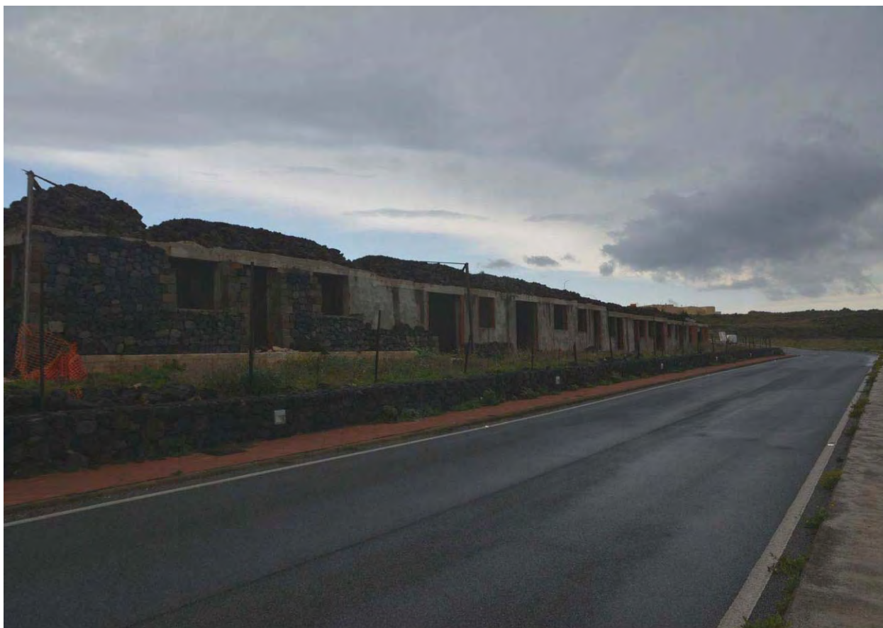
FOTO 06 - VISTA ESTERNA DA VIA S.P. N. 54 CORPO C
