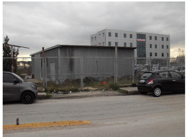
Foto 3 – P.lla 5262 manufatto metallico
