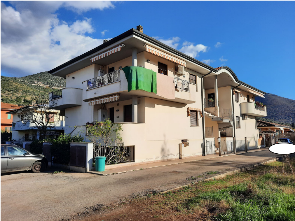
Foto 3 – Vista fabbricato dall'angolo nord-ovest
