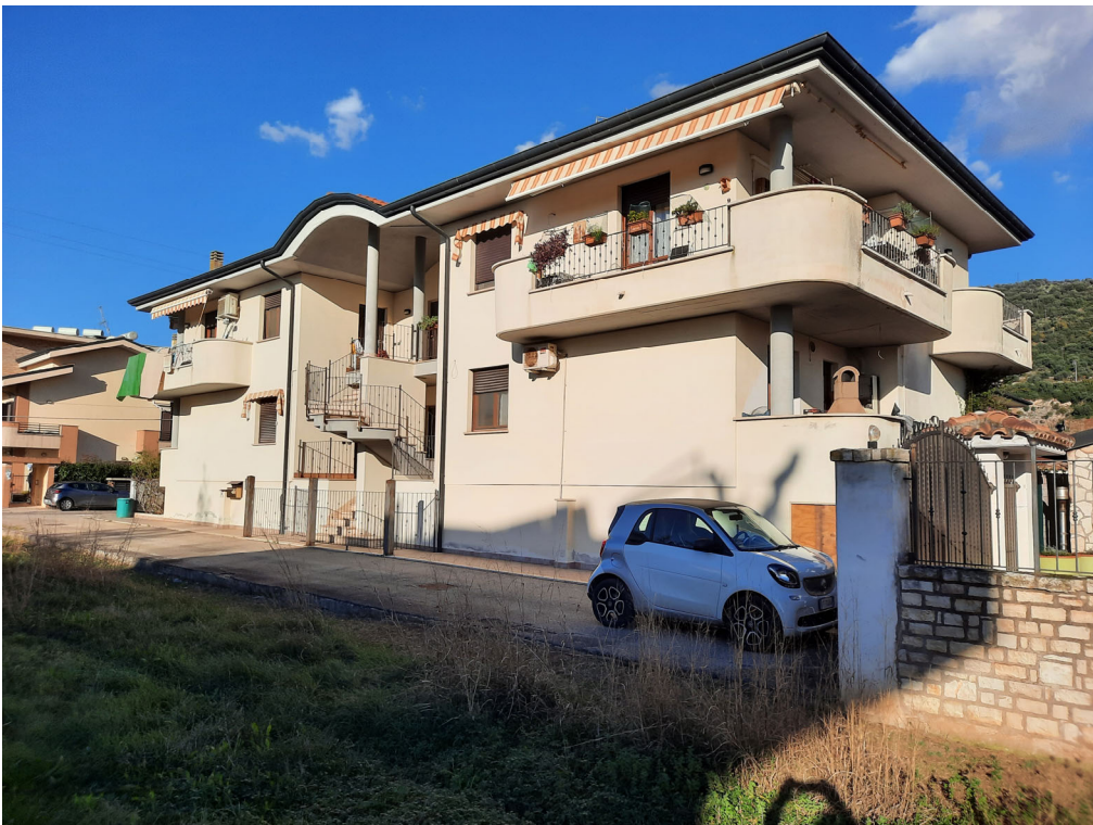
Foto 4 – Vista fabbricato dall'angolo sud-ovest
