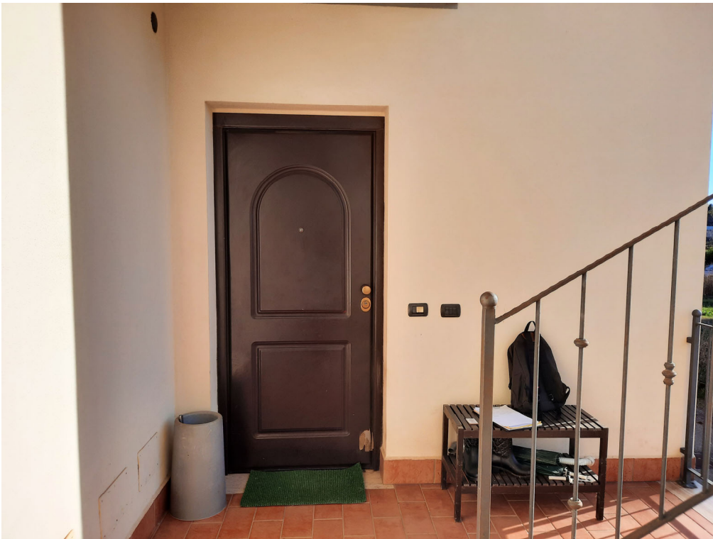
Foto 23 – Portoncino ingresso appartamento
