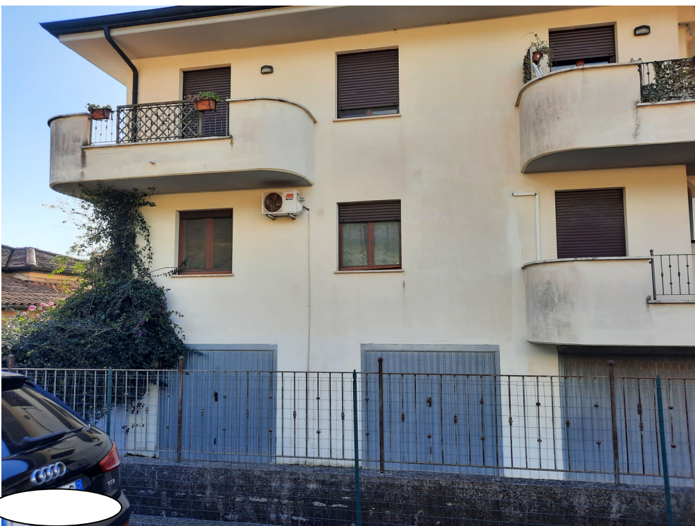
Foto 8 – Esterno est appartamento esecutato
