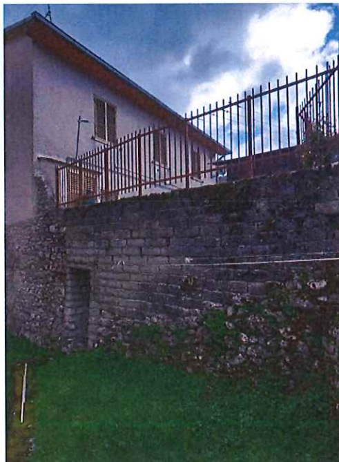
Foto 6 – locale di sgombero esterno
