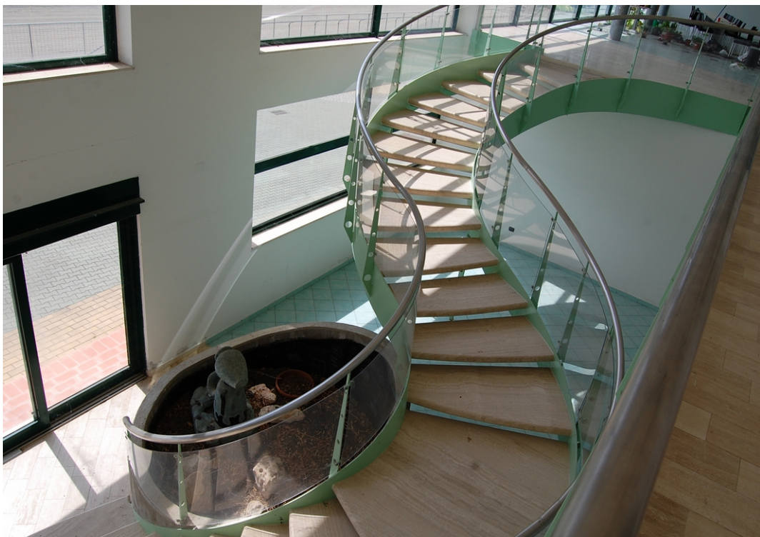
scala di collegamento tra il P.T. e 1° piano
