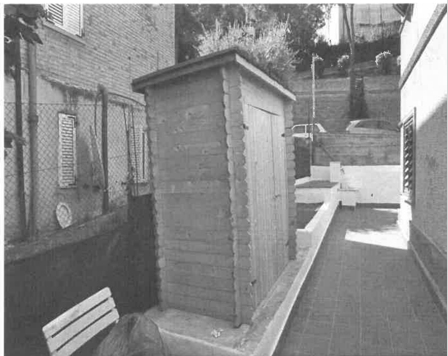
4 marciapiede perimetrale est e accessorio 1
