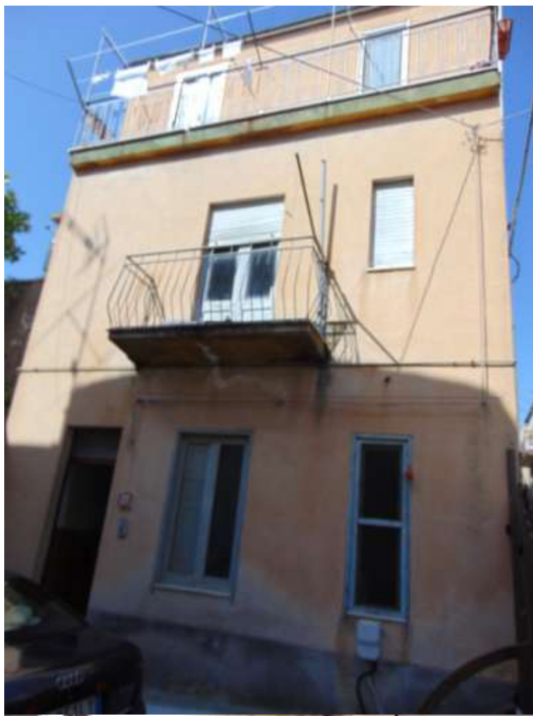
FOTO 03 - VISTA PROSPETTO DALL'AREA COMUNE
