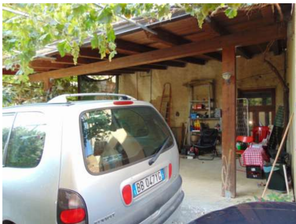
FOTO 04 - VISTA TETTOIA DI PERTINENZA DEL GARAGE
