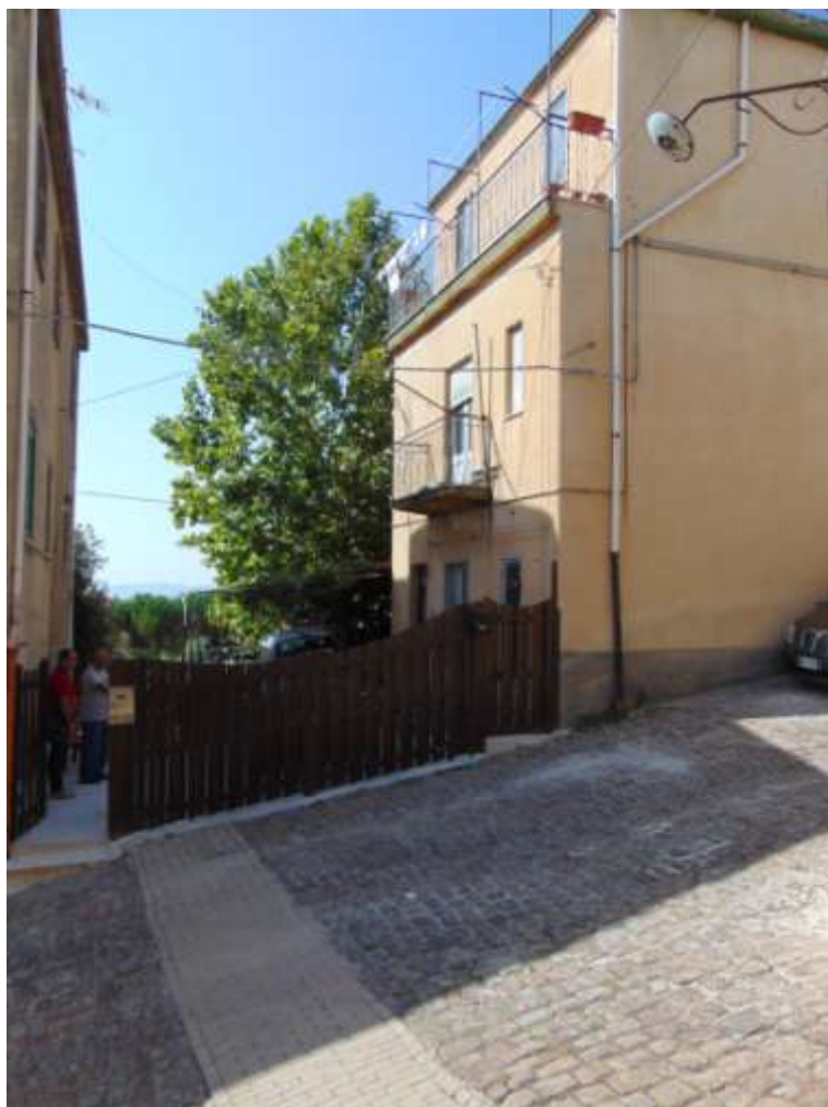
FOTO 01 - VISTA DALLA VIA DANTE ALIGHIERI
