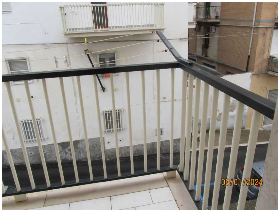
FOTO N.14 - Balcone su via Brindisi.
