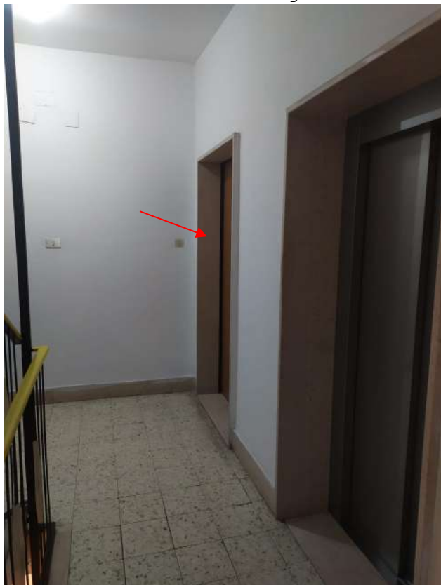
FOTO N.3 - Porta d'ingresso dell'abitazione.
