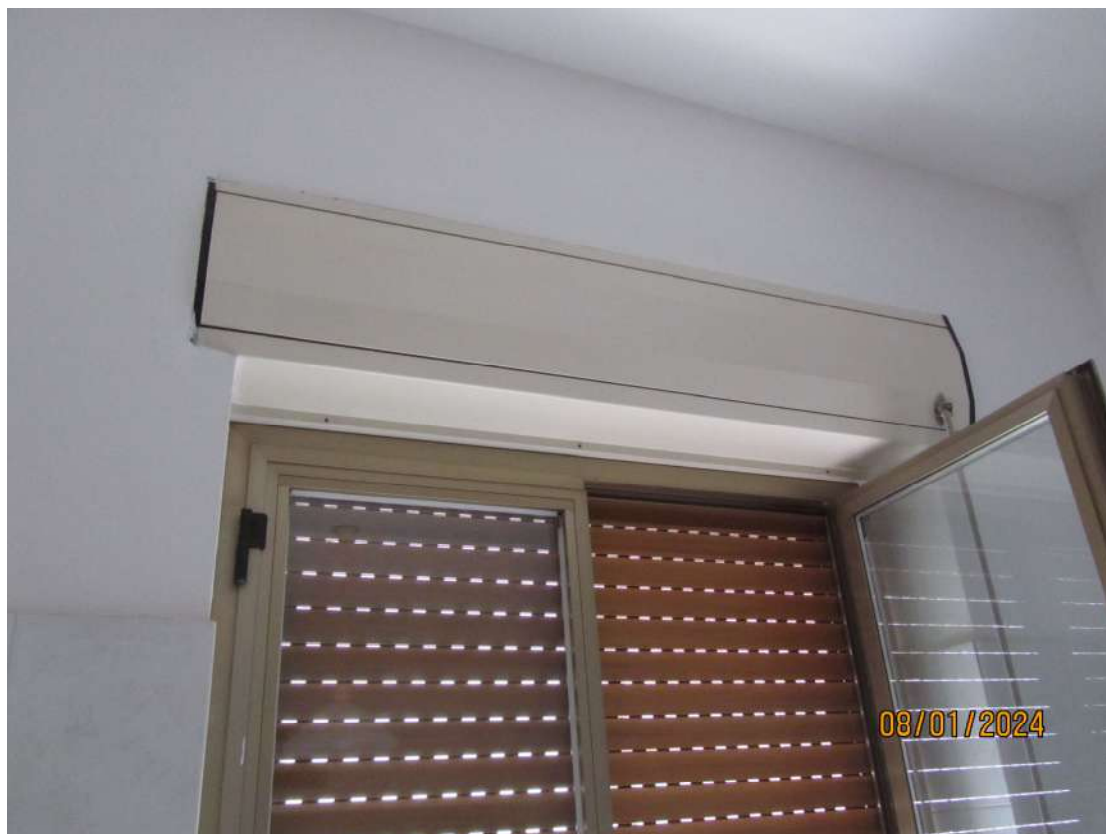
FOTO N.15 - Particolare infissi in anticorodal.
