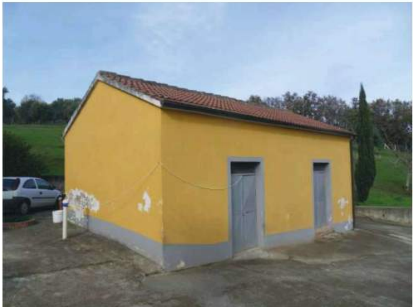
FOTO N. 118: Prospetto SUD - EST Bene N. 2
