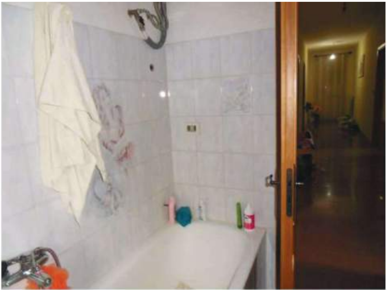
FOTO N. 91: Interni Bene N. 1 (PIANO PRIMO)
