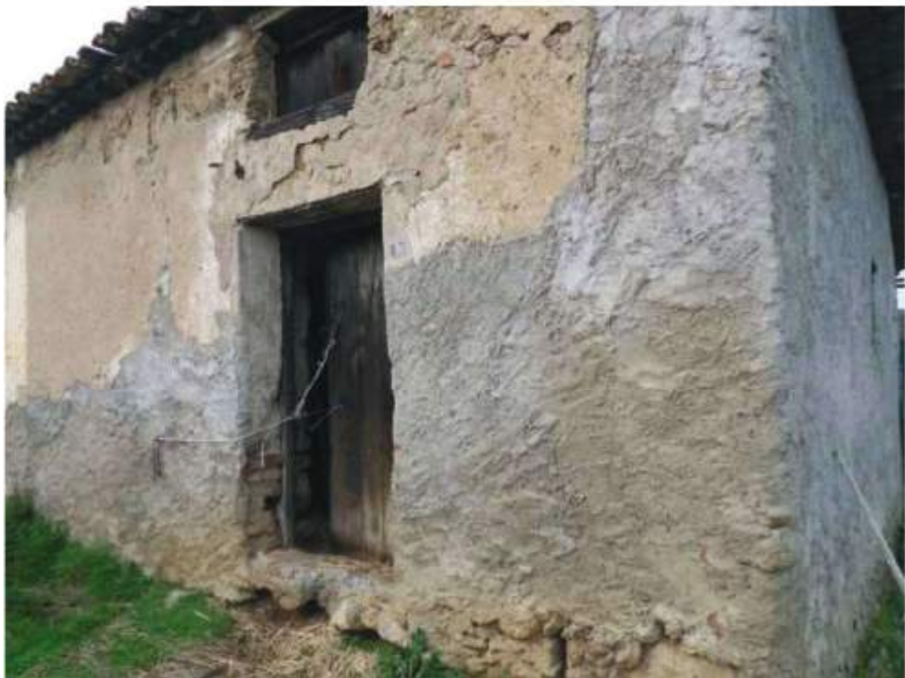
FOTO N. 138: Prospetto SUD – EST Bene N. 3
