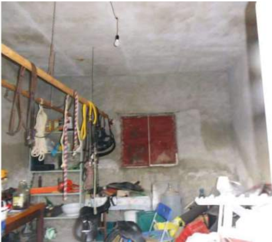
FOTO N. 130: Interni Bene N. 2
