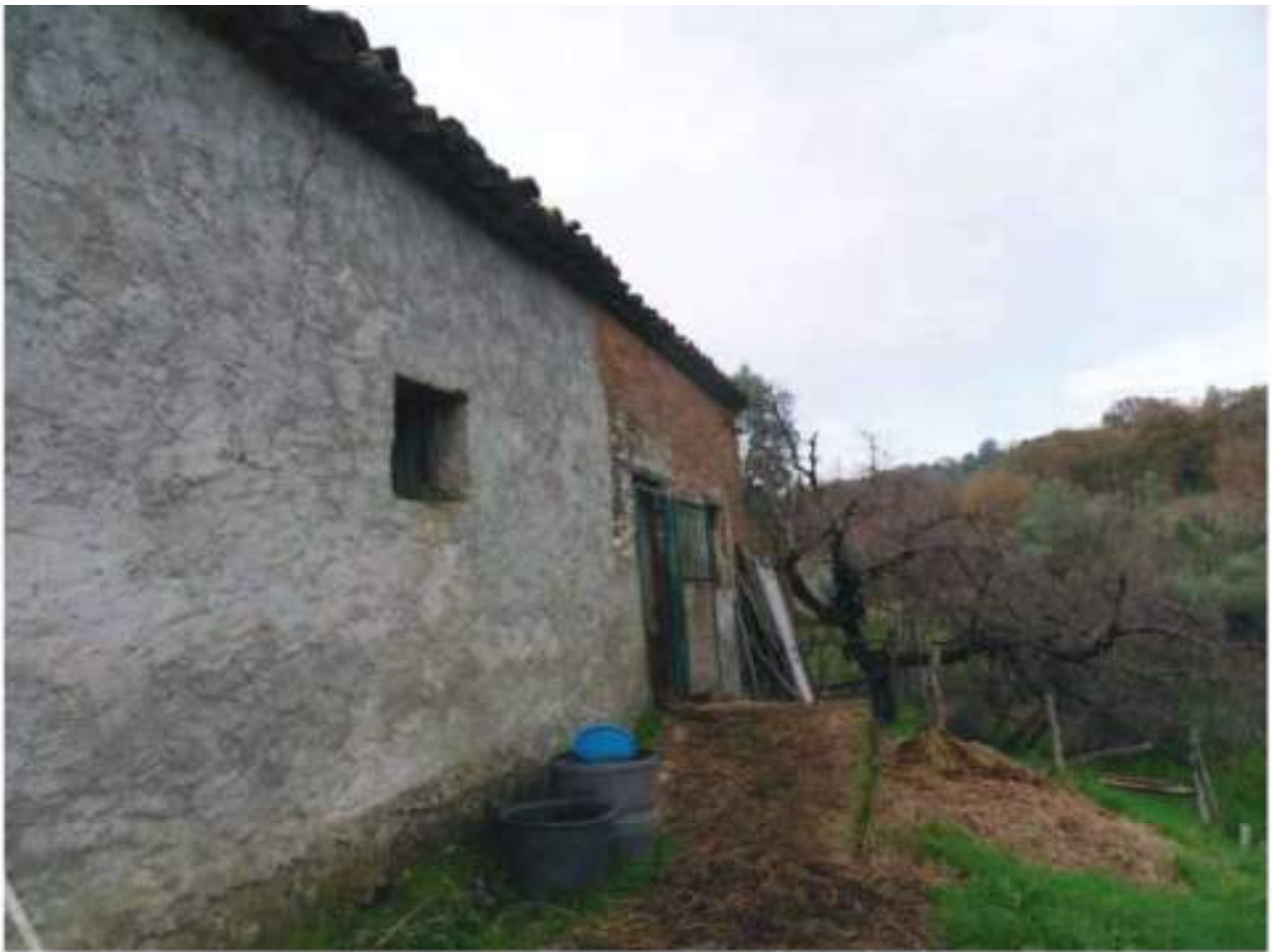
FOTO N. 139: Prospetto NORD – EST Bene N. 3
