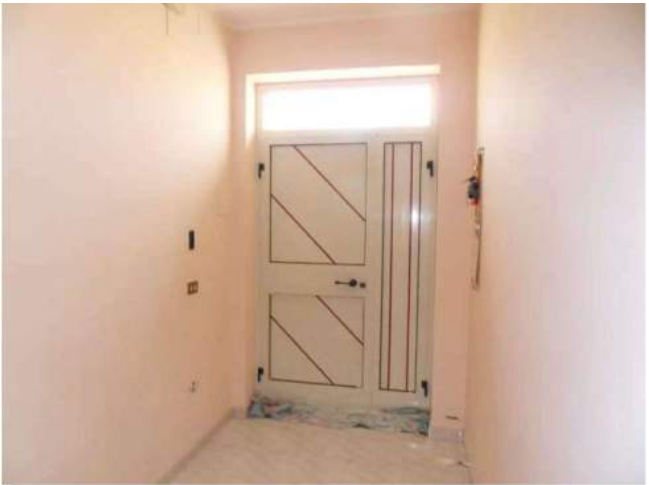
FOTO N. 27: Interni Bene N. 1 (PIANO TERRA)
