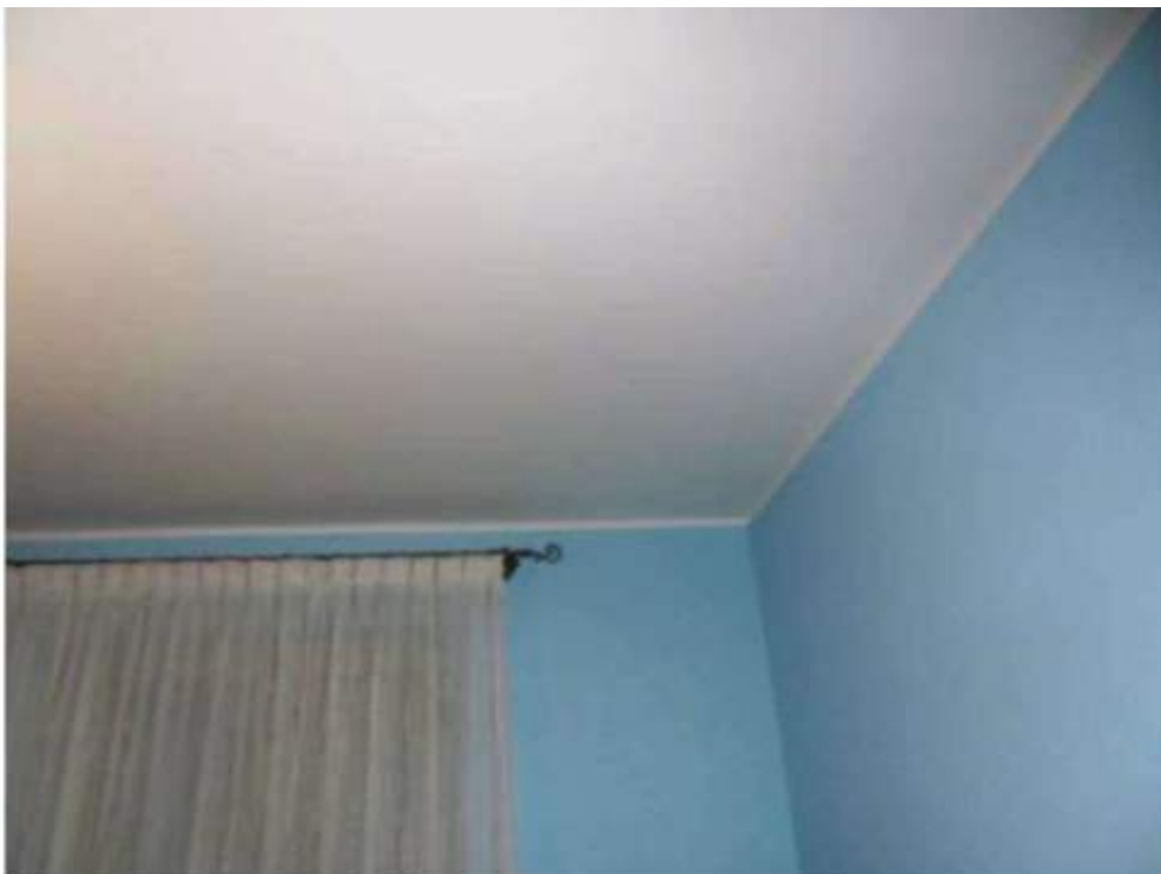
FOTO N. 63: Interni Bene N. 1 (PIANO TERRA)
