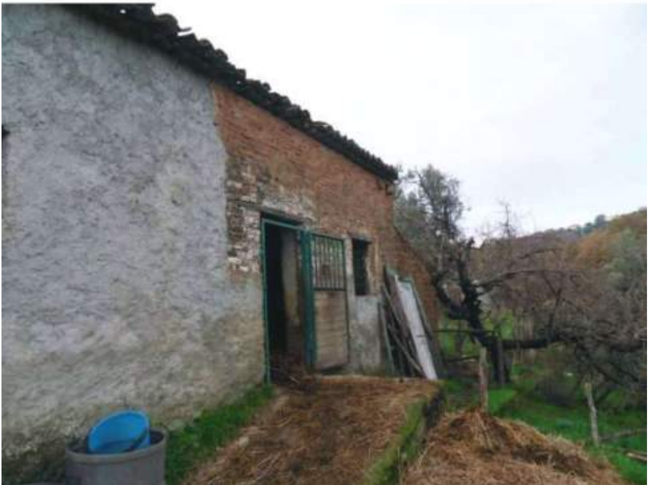
FOTO N. 140: Prospetto NORD – EST Bene N. 3
