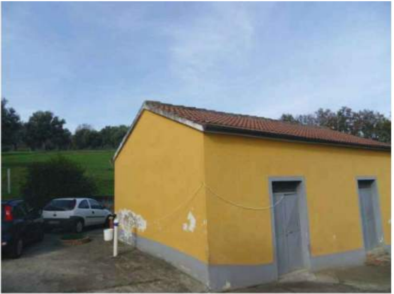
FOTO N. 119: Prospetto SUD - EST Bene N. 2
