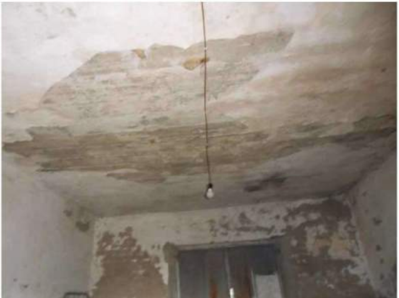
FOTO N. 128: Interni Bene N. 2
