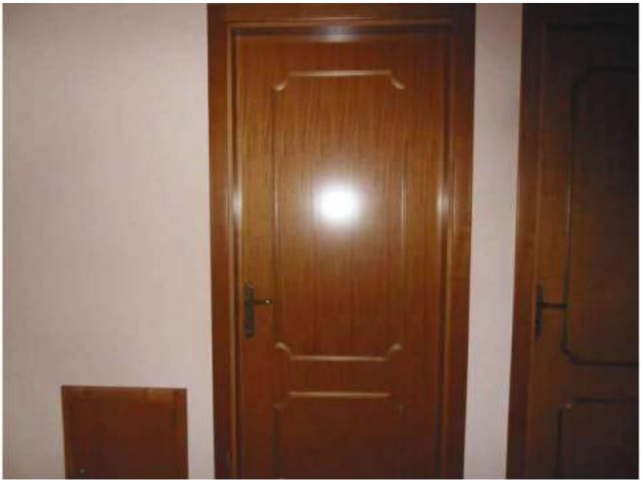
FOTO N. 41: Interni Bene N. 1 (PIANO TERRA)
