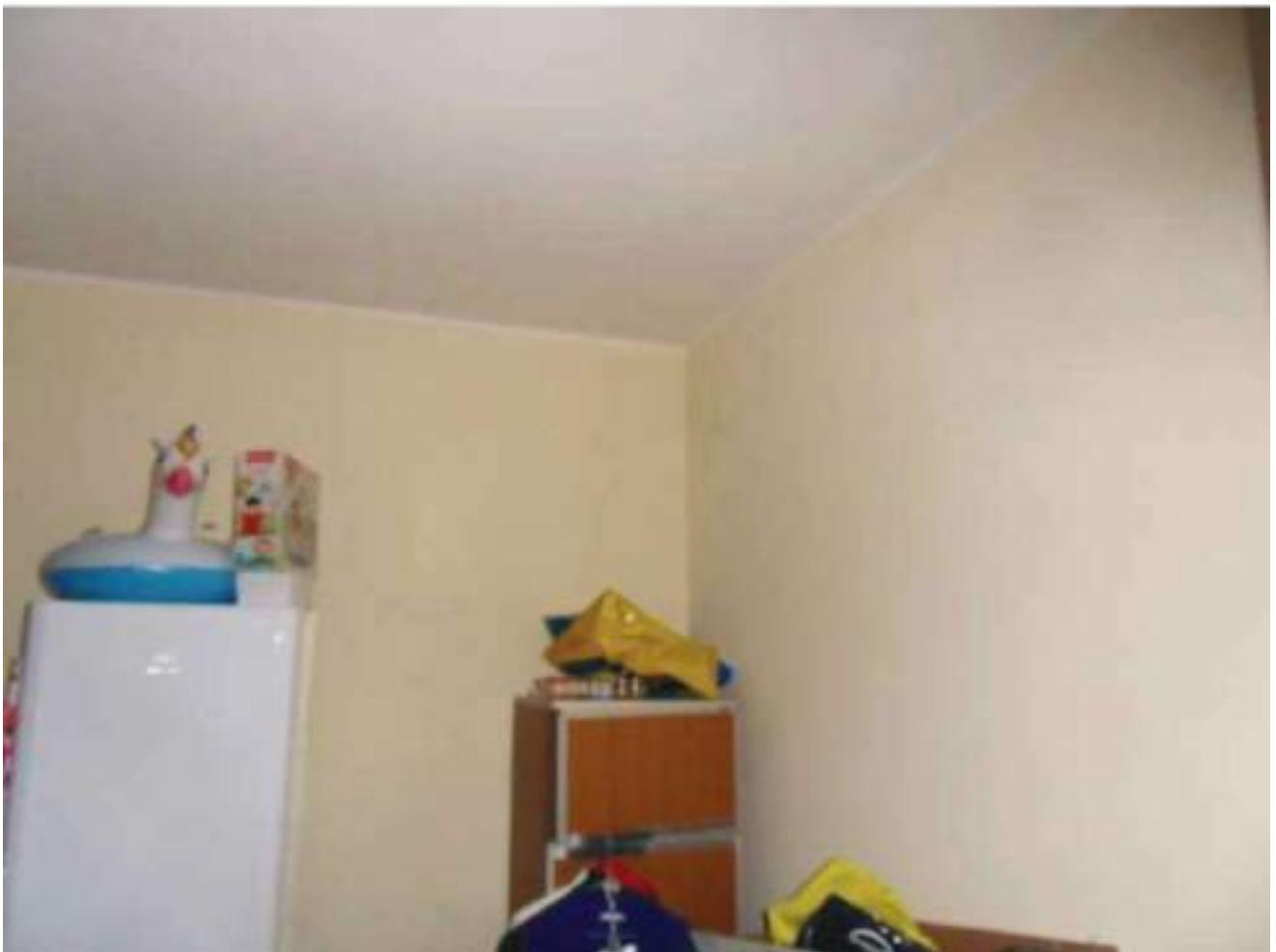
FOTO N. 32: Interni Bene N. 1 (PIANO TERRA)
