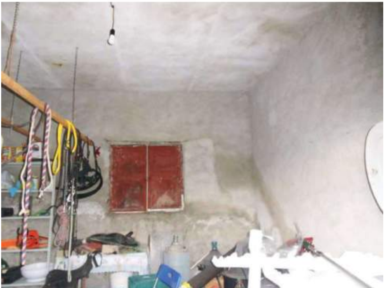
FOTO N. 134: Interni Bene N. 2
