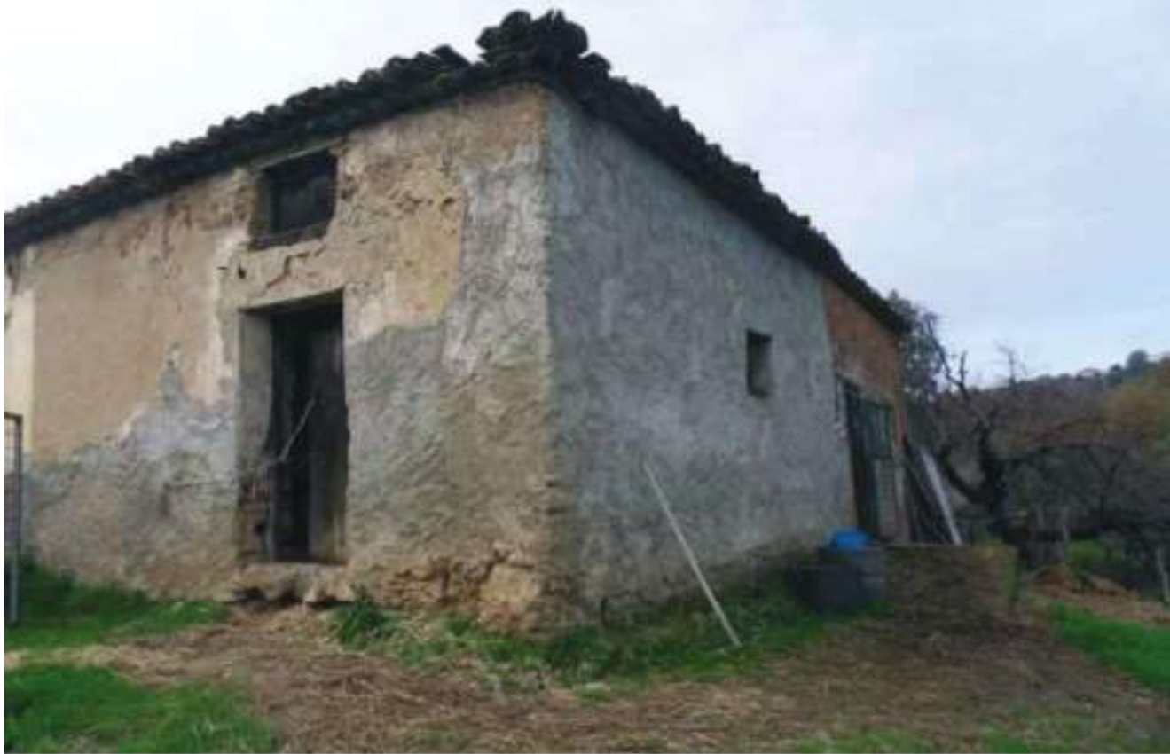
FOTO N. 137: Prospetto SUD – EST Bene N. 3
