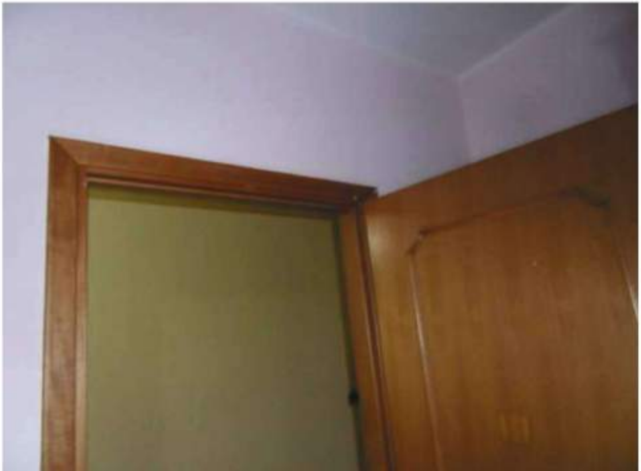
FOTO N. 116: Interni Bene N. 1 (PIANO PRIMO)
