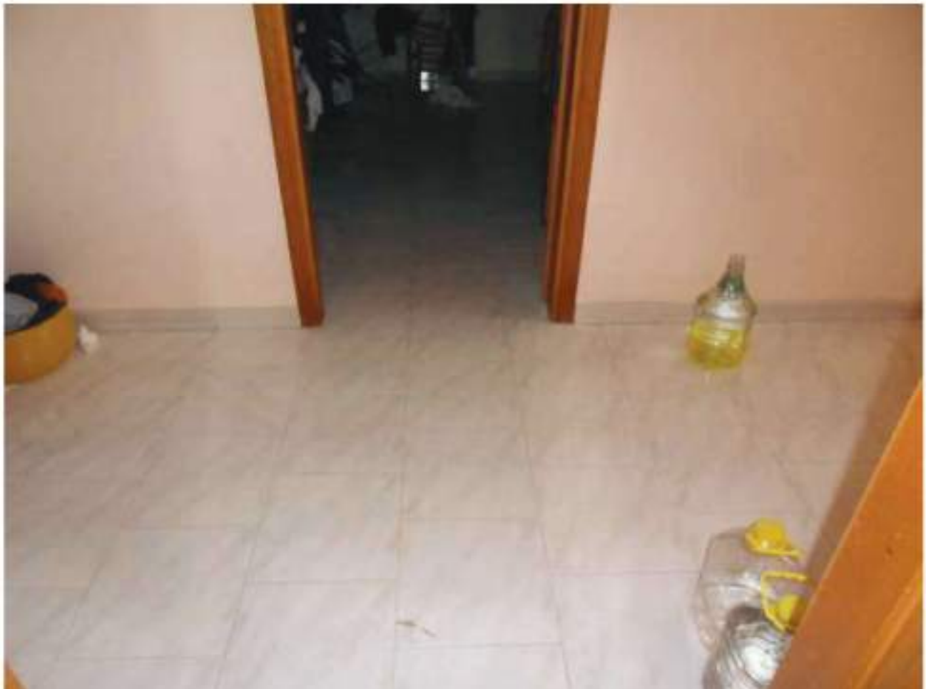
FOTO N. 26: Interni Bene N. 1 (PIANO TERRA)
