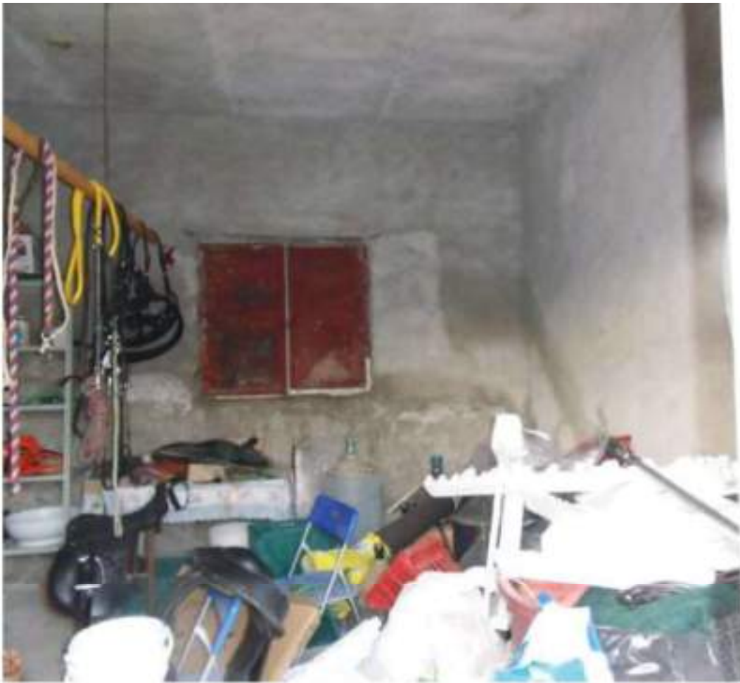
FOTO N. 133: Interni Bene N. 2
