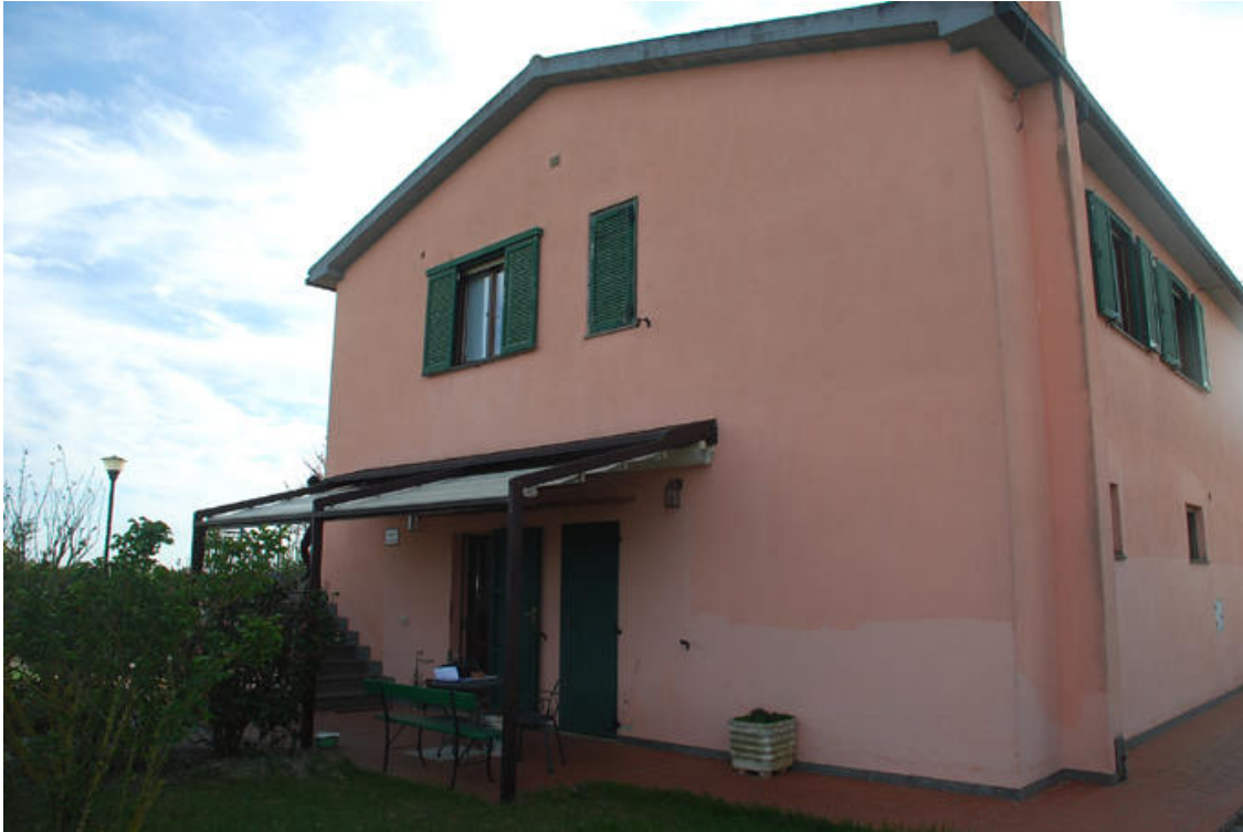
Rif.fot.5 – Prospetto frontale
