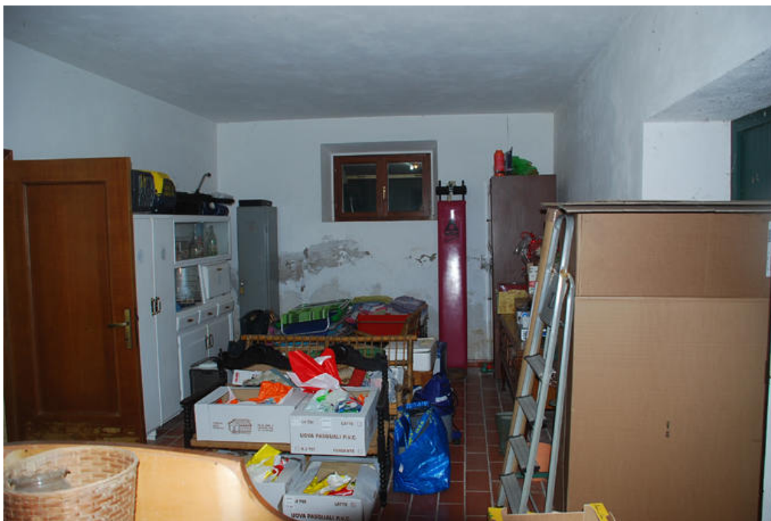
Rif.fot.27 –Magazzini lato ovest rif. fot1
