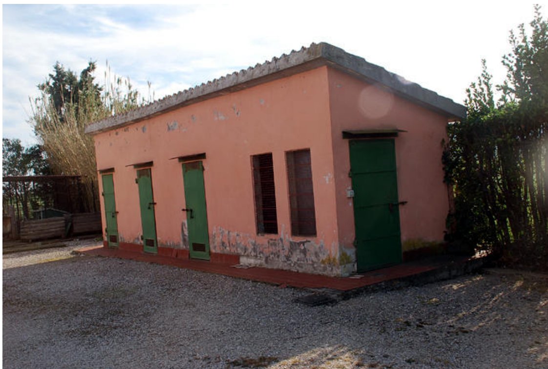
Rif.fot.33 –Magazzino in muratura lato nord-ovest
