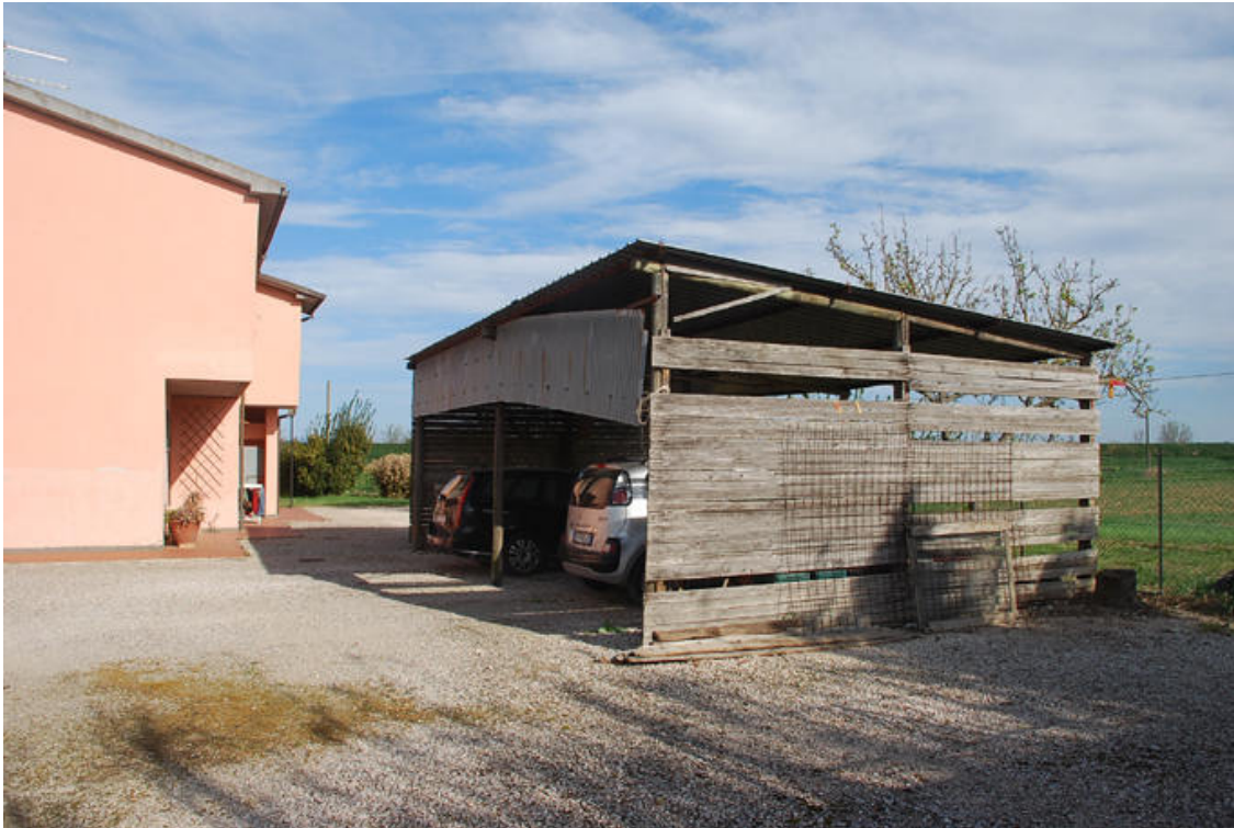
Rif.fot.38 – Tettoia in legno per rimessaggio auto
