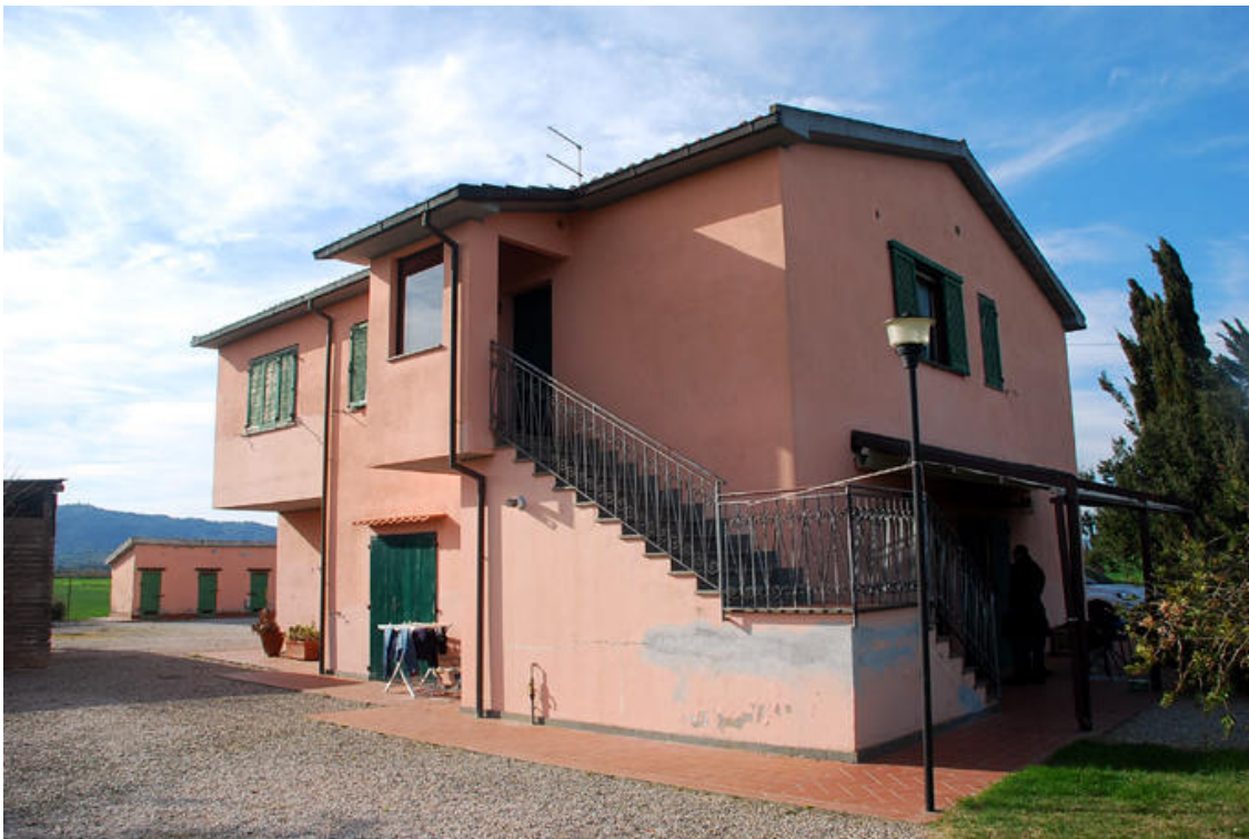
Rif.fot.6 – Prospetto laterale sinistro
