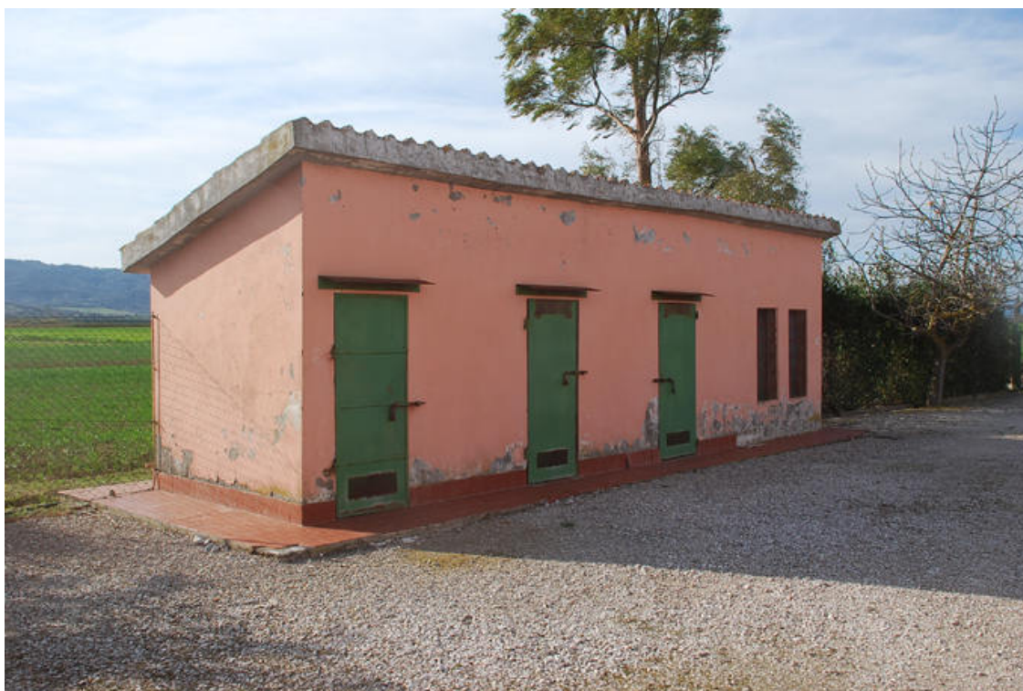
Rif.fot.32 -Magazzino in muratura lato sud-est
