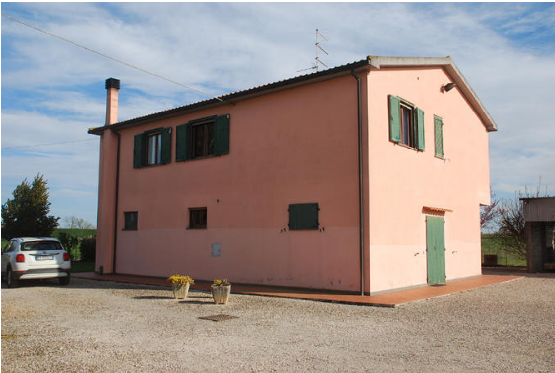
Rif.fot.8 – Prospetto laterale sinistro
