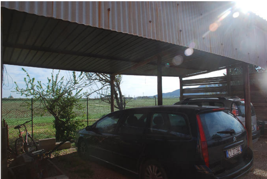
Rif.fot.39 – Tettoia in legno per rimessaggio auto
