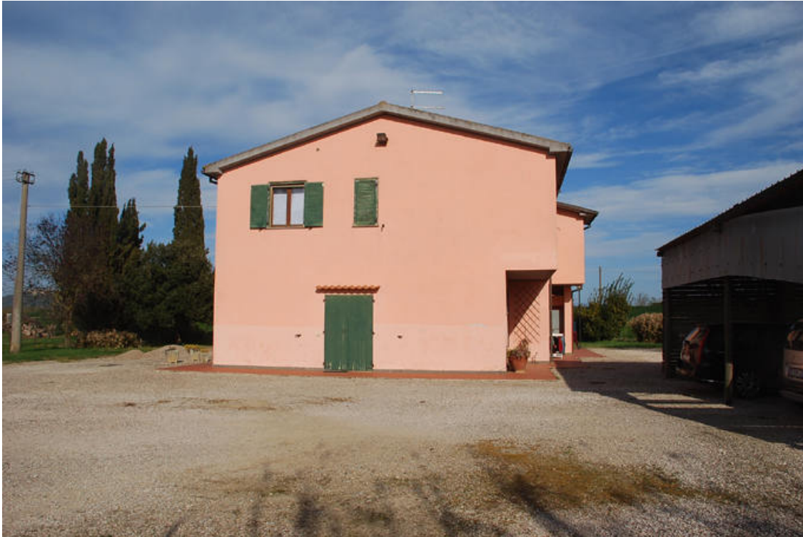
Rif.fot.7 – Prospetto laterale retro
